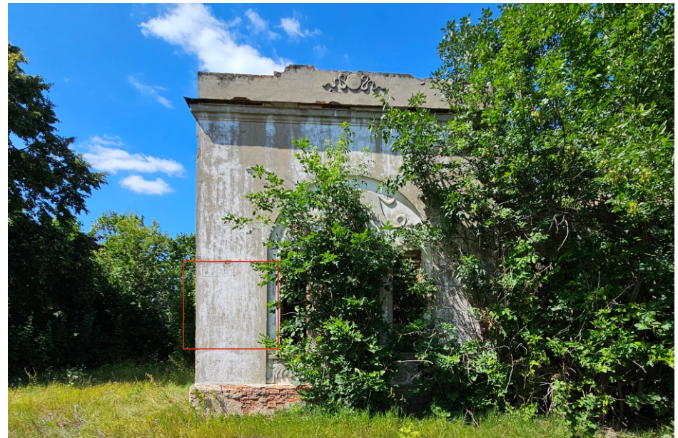
Вид на объект до установки информационной надписи
