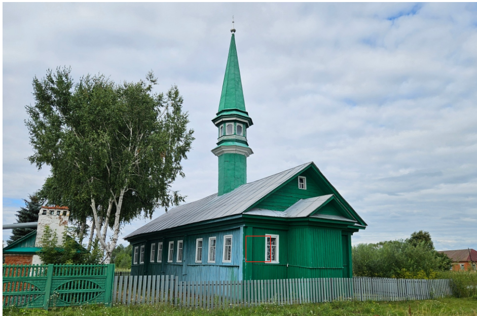
Вид на объект до установки информационной надписи
