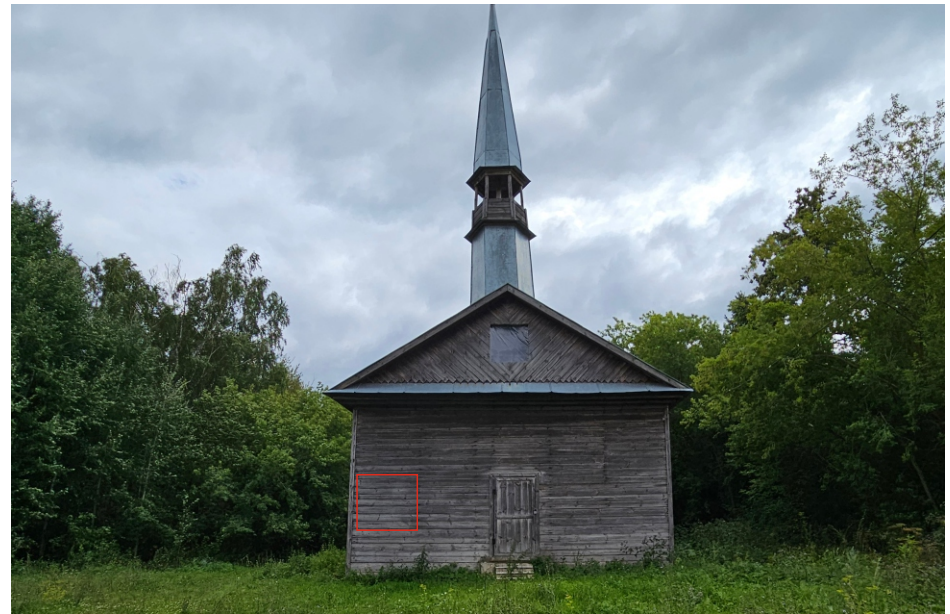
Вид на объект до установки информационной надписи
