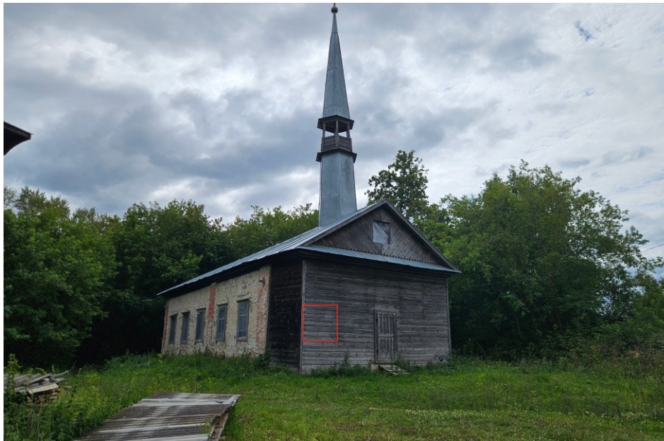
Вид на объект до установки информационной надписи
