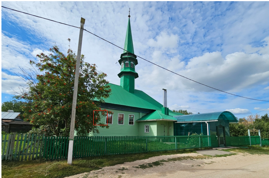
Вид на объект до установки информационной надписи
