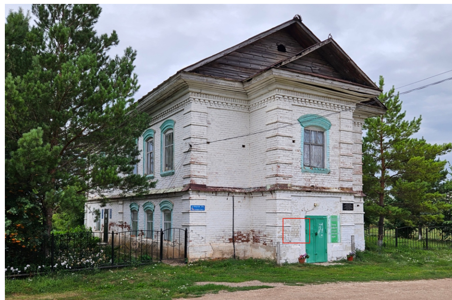
Вид на объект до установки информационной надписи
