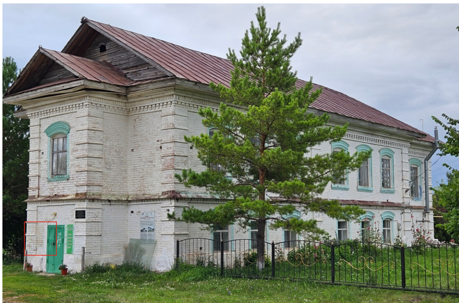
Вид на объект до установки информационной надписи
