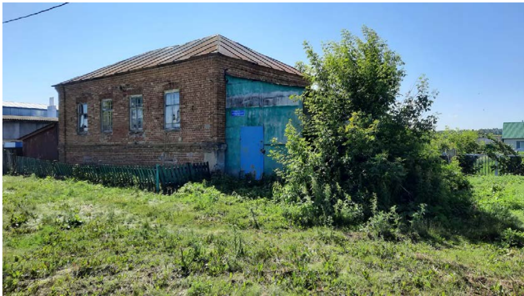
Фото 2. Вид с северо-запада.
