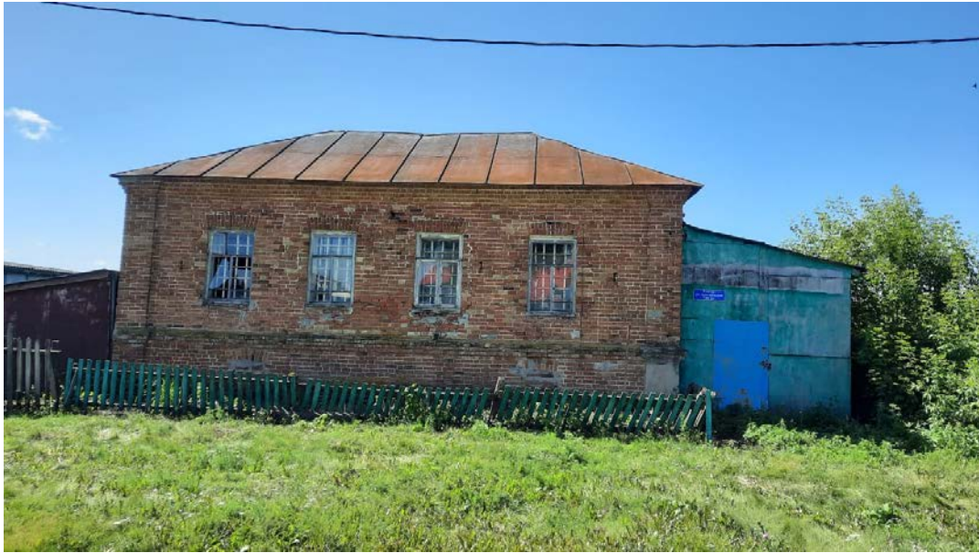
Фото 1. Вид с северо-востока
