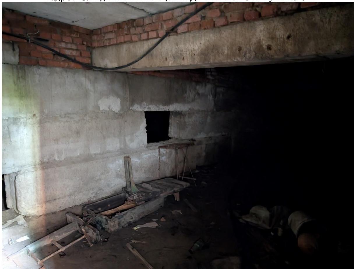
Кадр №14. Подвальные помещения. Дата съемки: 04 августа 2025 г.
