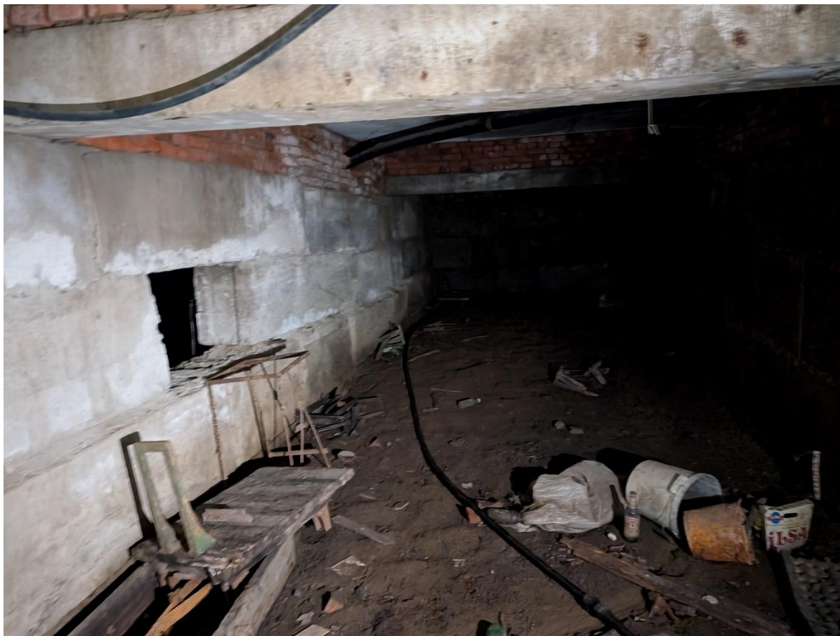
Кадр №15. Подвальные помещения. Дата съемки: 04 августа 2025 г.
