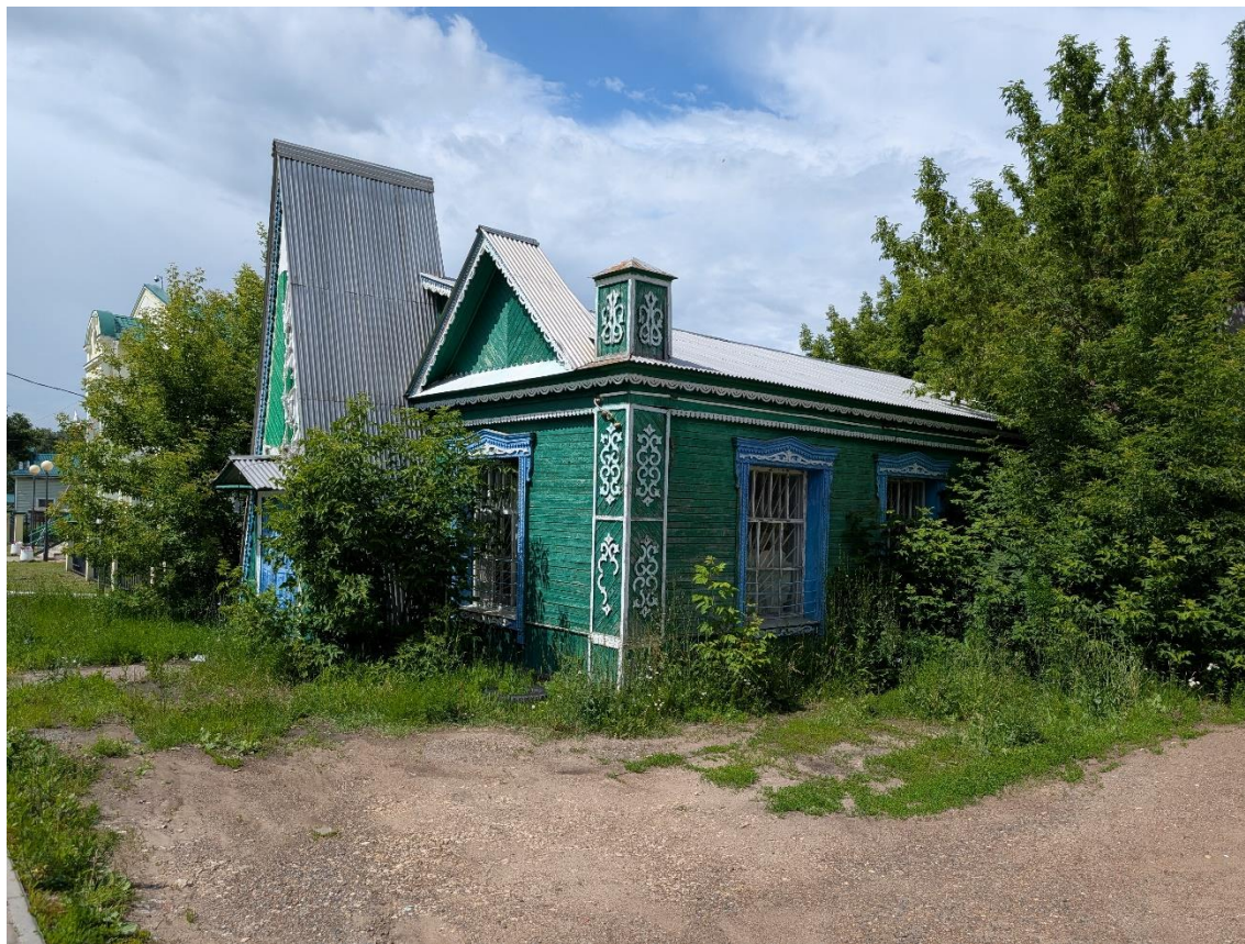
Кадр №1 Главный и боковой фасад. С ул. Горького. Дата съемки: 04 августа 2025 г
