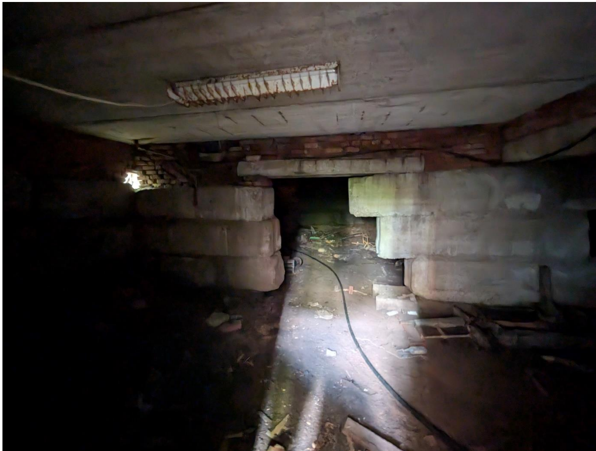
Кадр №13. Подвальные помещения. Дата съемки: 04 августа 2025 г.
