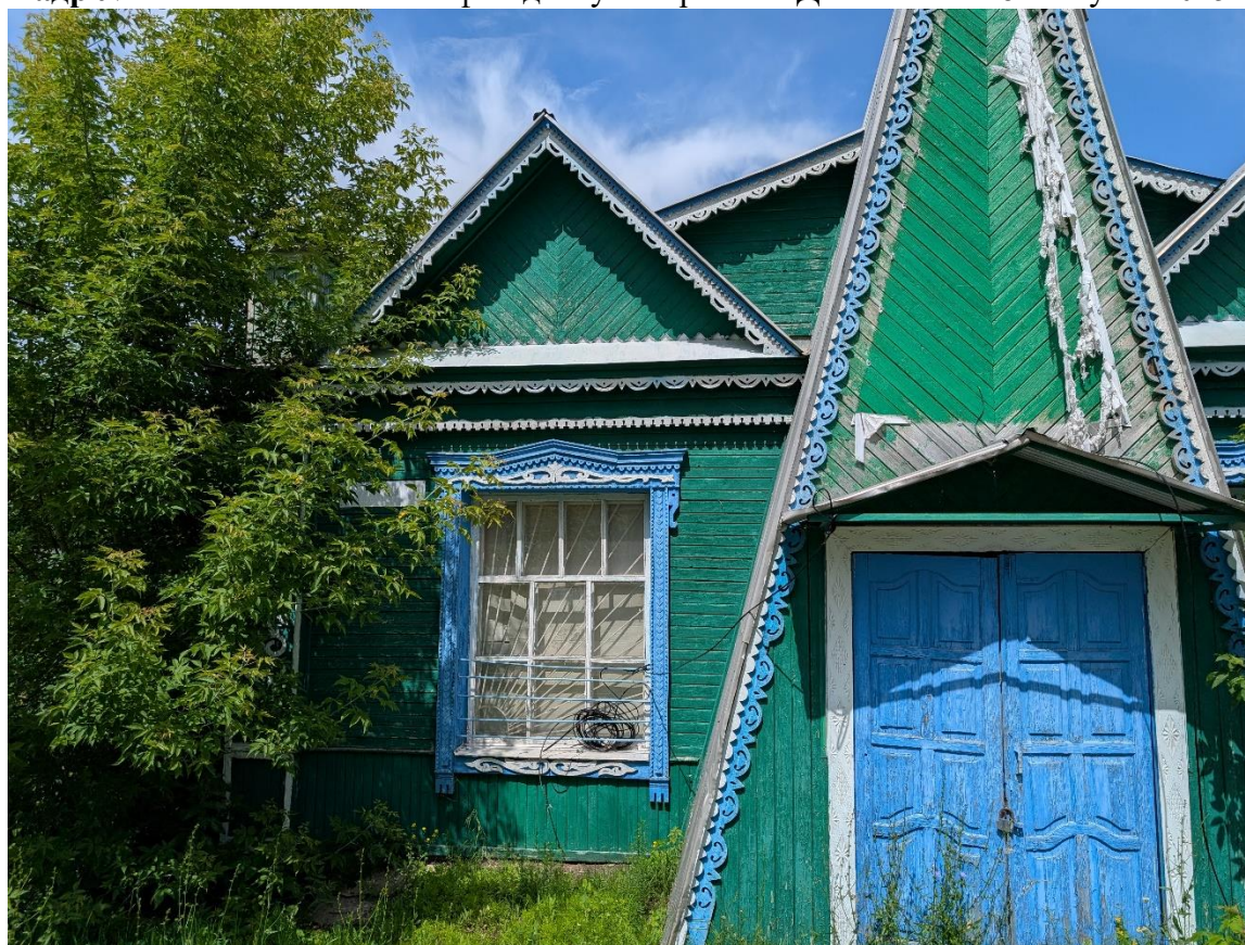
Кадр №2. Главный фасад. Фото с ул. Горького. Дата съемки: 04 августа 2025 г.
