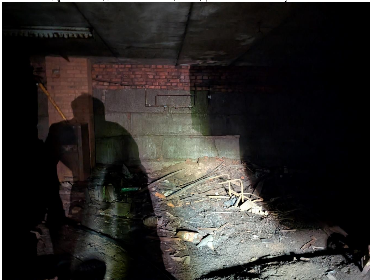
Кадр №16. Подвальные помещения. Дата съемки: 04 августа 2025 г.
