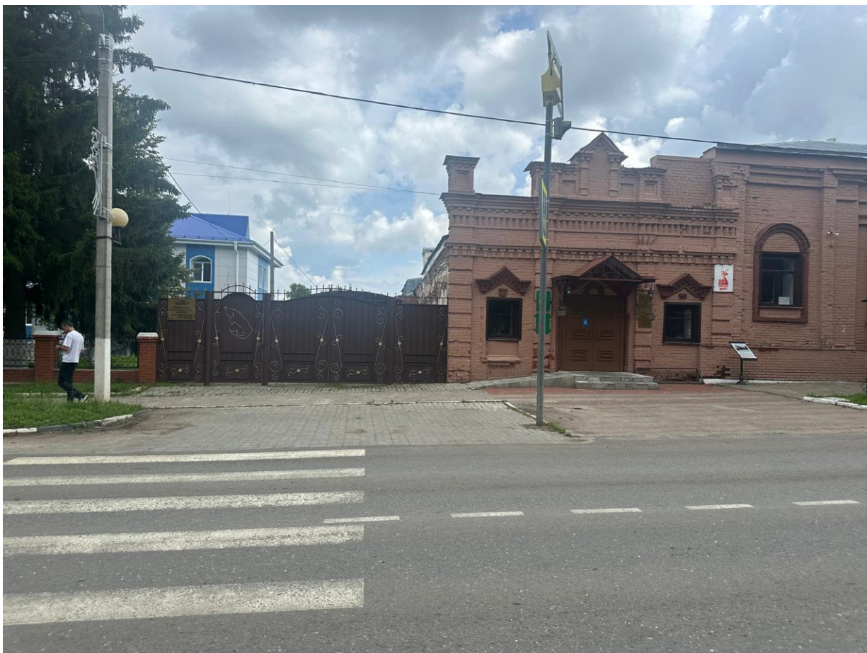
Кадр 9. Фото на главный фасад здания № 69. Дата: 15.08.2025
