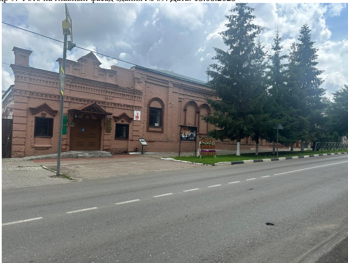
Кадр 10. Фото на главный фасад здания № 69. Дата: 15.08.2025
