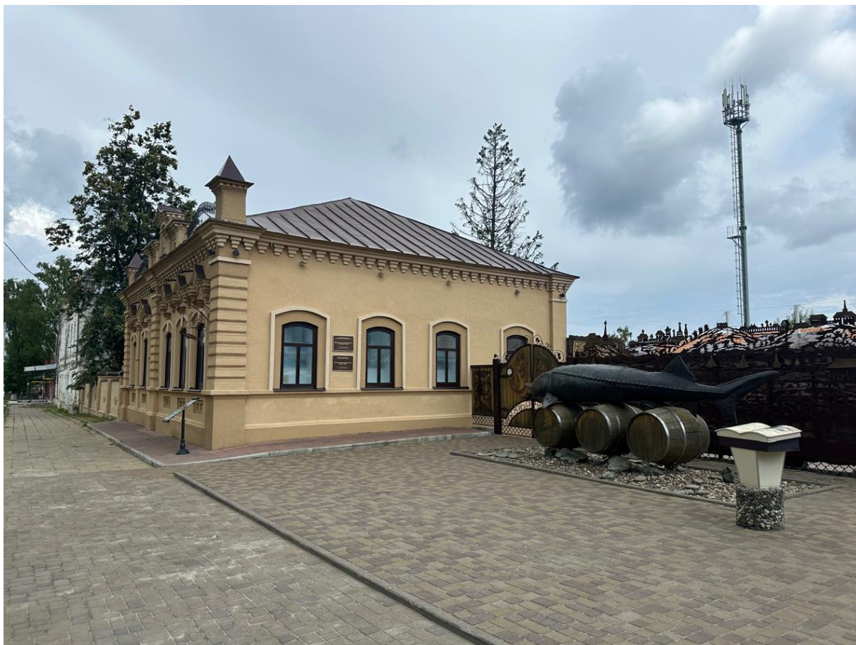
Кадр 1. Фото объекта по адресу: г.Тетюши, ул.Свердлова, д.63. Дата: 15.08.2025
