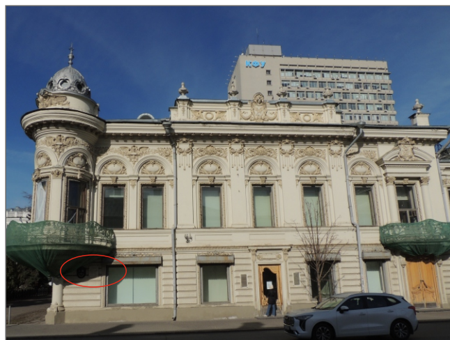
Вид на объект до установки информационной надписи
