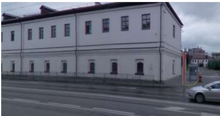
1. Вид на объект до установки информационной надписи
