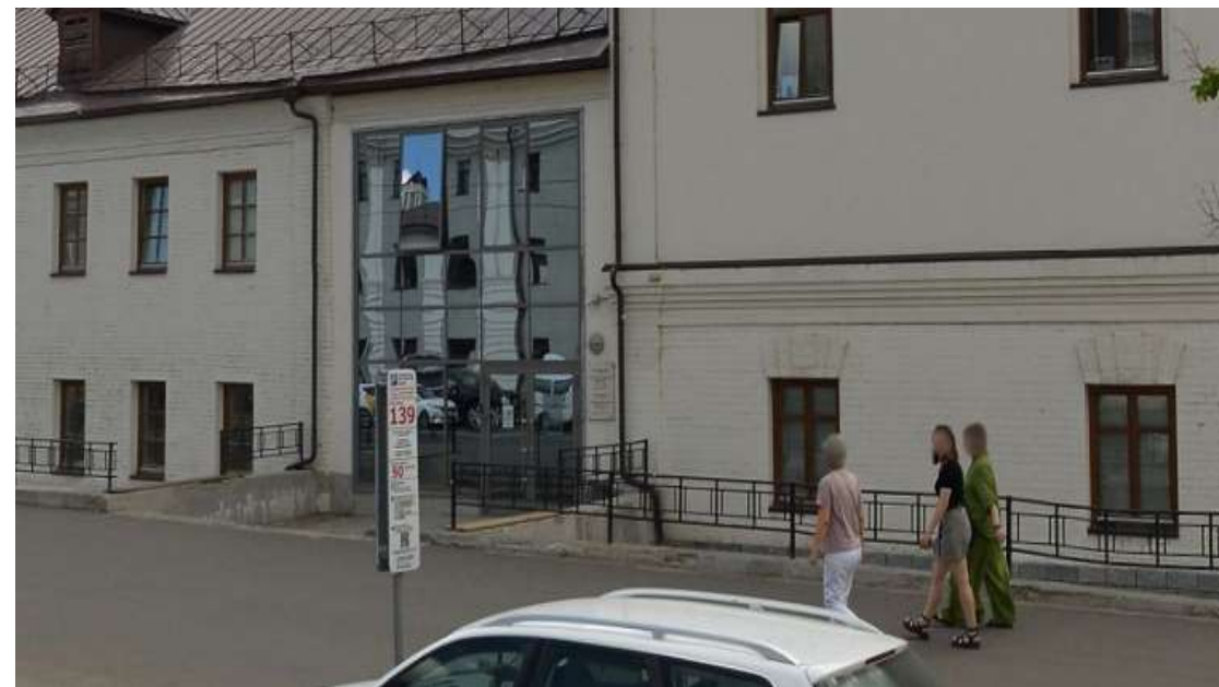
6. Фото фиксация ОКН с указанием места размещения информационной надписи (фотомонтаж)
