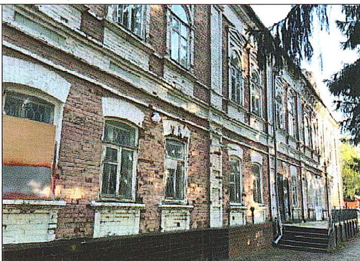
Рис. 6. Северо-западный фасад по ул. Октябрьской
