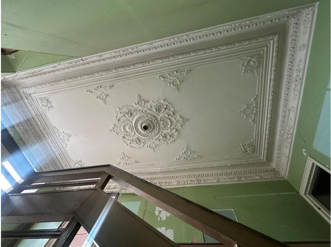
Кадр 23. Лестничная клетка Фото февраль 2025
