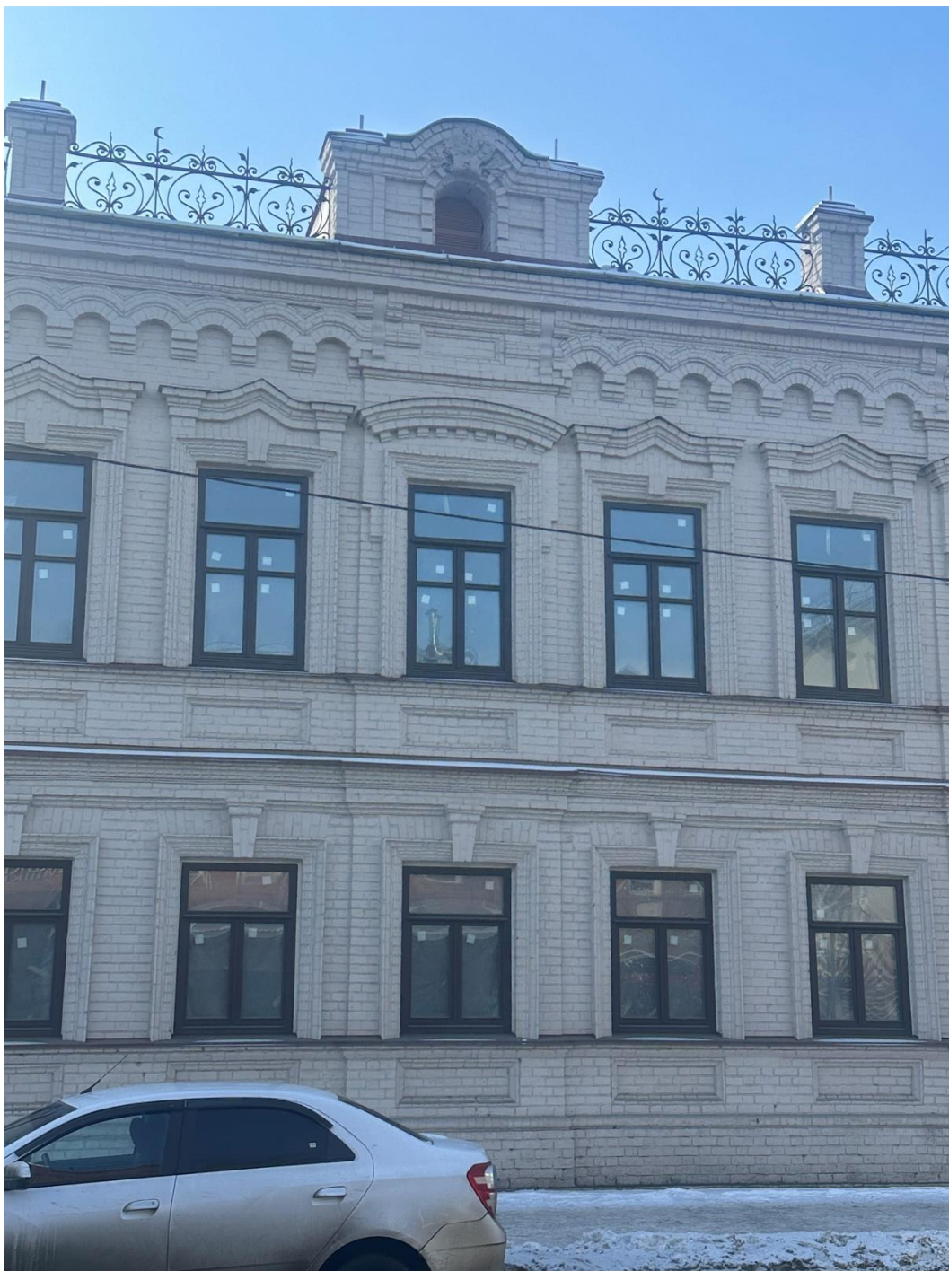
Кадр 5. Фрагмент главного фасада Фото февраль 2025
