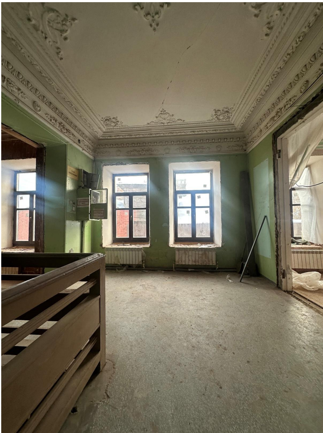
Кадр 25. Лестничная клетка Фото февраль 2025
