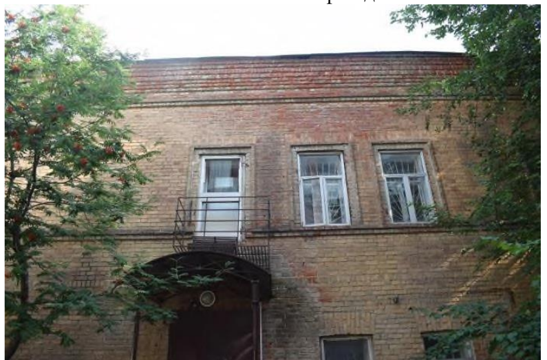
Балкон с кованым ажурным ограждением по 2-му этажу скошенной части фасада
