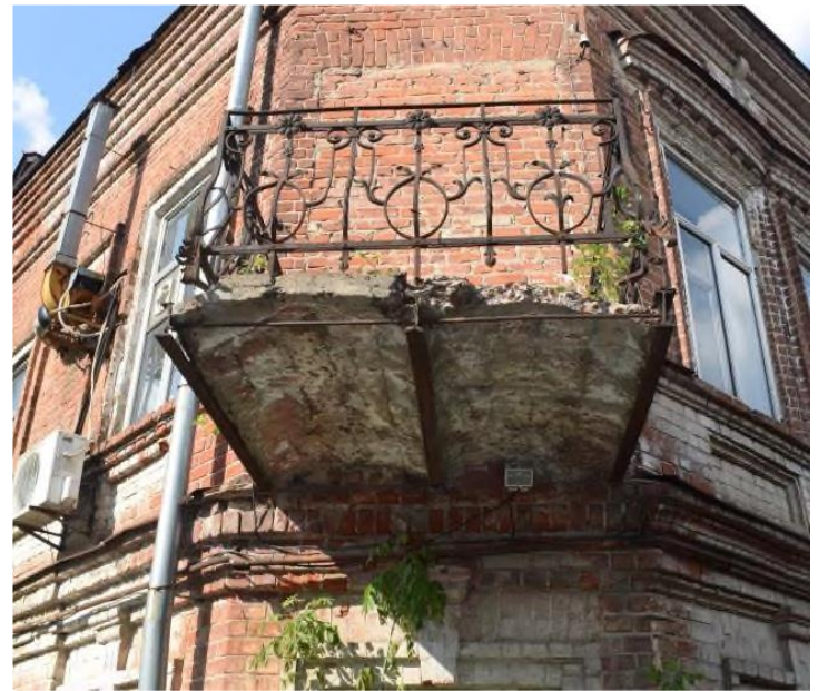
Балкон с кованым ажурным ограждением по 2-му этажу скошенной части фасада
