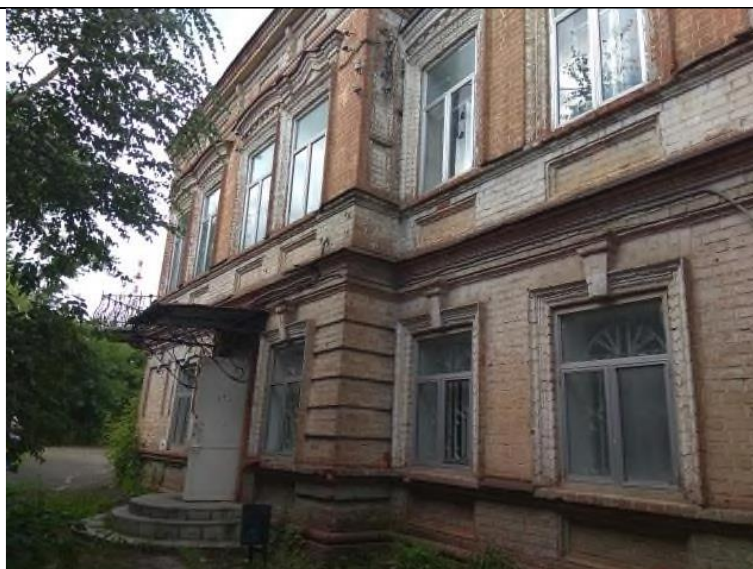
Боковой (дворовый) фасад
