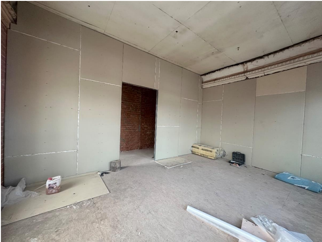
Кадр 28. Помещение 2 этажа Фото февраль 2025
