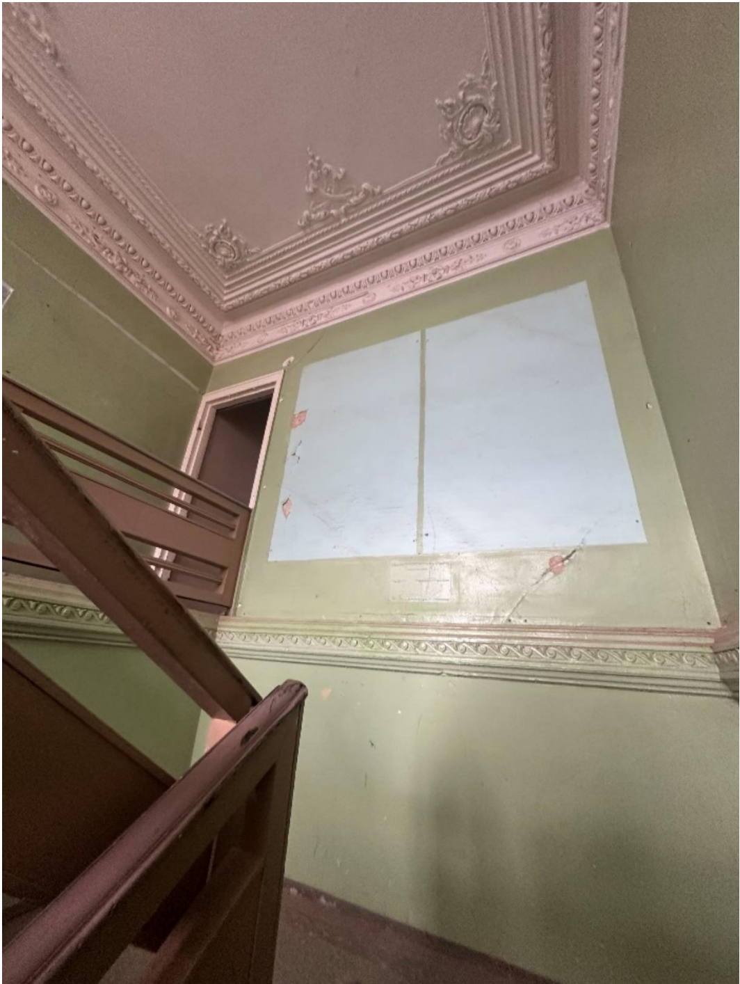
Кадр 24. Лестничная клетка Фото февраль 2025
