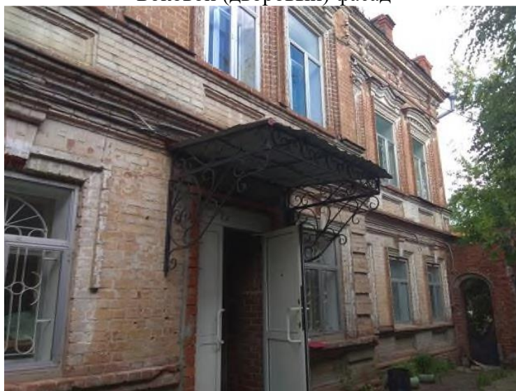
Боковой (дворовый) фасад
