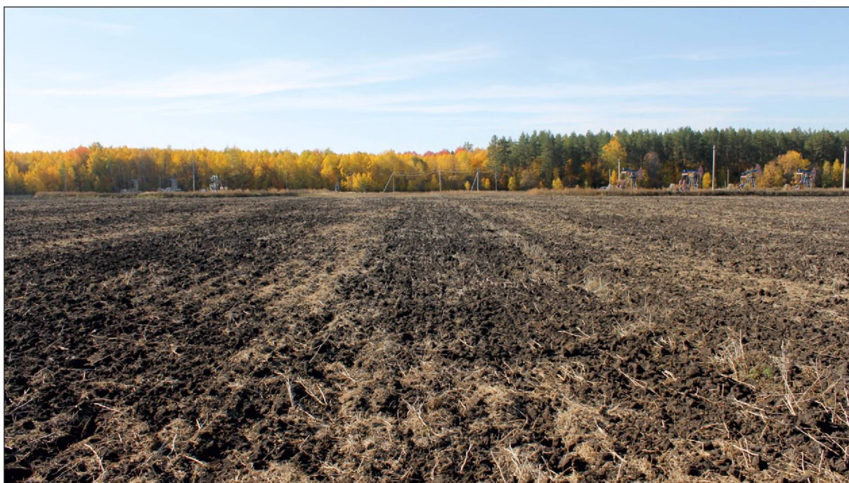
Рис.14. «Обустройство куста скважин W-3 Демкинского нефтяного месторождения АО "Татех"» Республика Татарстан, Аксубаевский муниципальный район. Точка фотофиксации 3. Вид с северо-востока.
