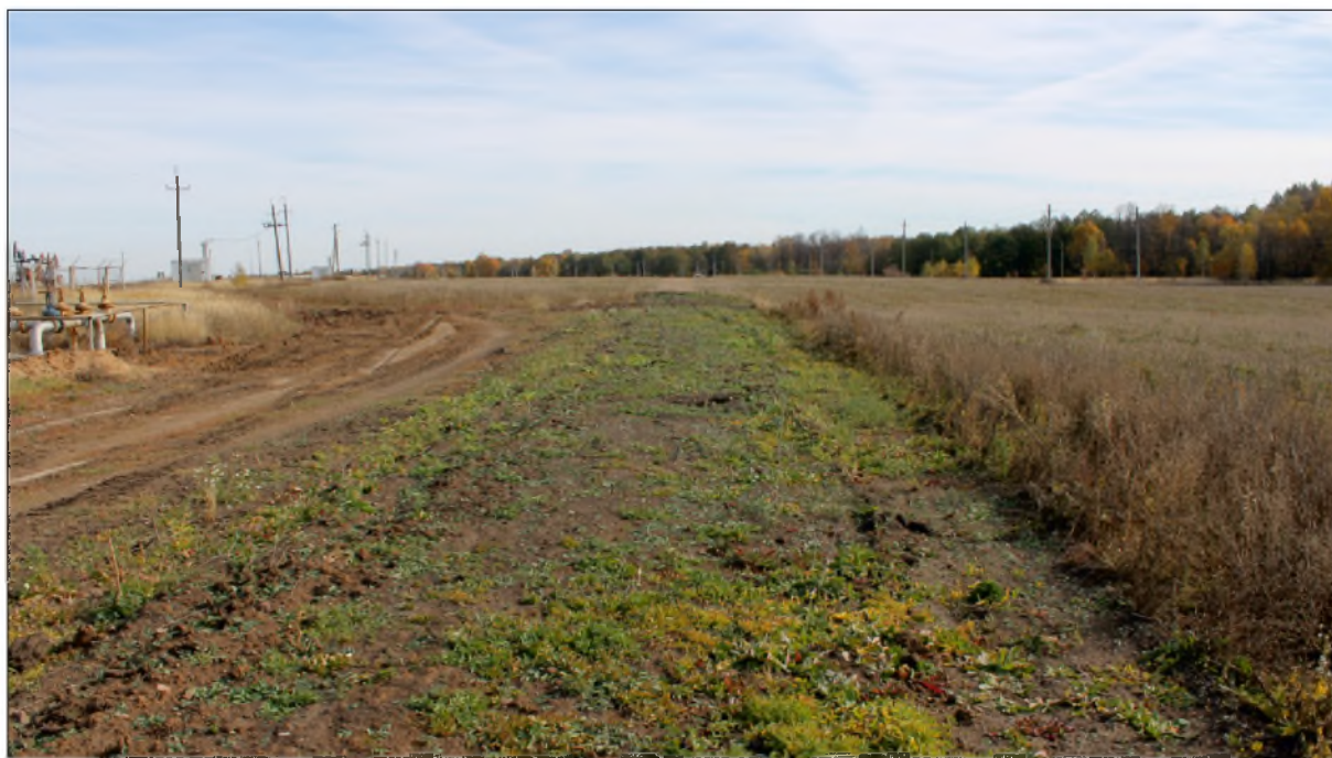
Рис.10. «Строительство высоконапорного водовода от КНС-1 до скв.973». Зюзеевское нефтяное месторождение, Республика Татарстан, Нурлатский муниципальный район. Точка фотофиксации 1. Вид с запада.
