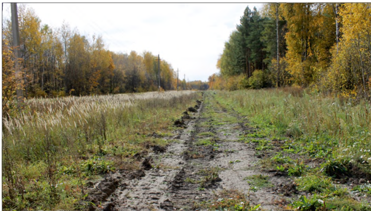
Рис.16. «Строительство высоконапорного водовода от КНС-1 до скв.973». Зюзеевское нефтяное месторождение, Республика Татарстан, Нурлатский муниципальный район. Точка фотофиксации 4. Вид с севера.
