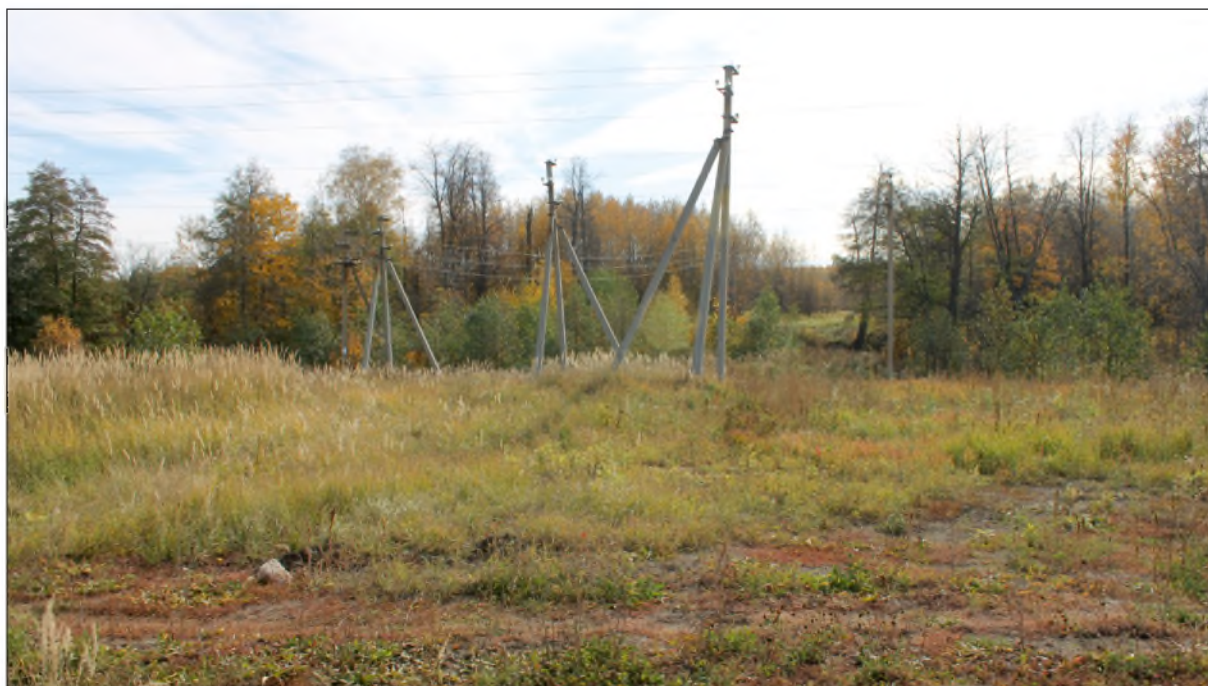
Рис.12. «Строительство высоконапорного водовода от КНС-1 до скв.973». Зюзеевское нефтяное месторождение, Республика Татарстан, Нурлатский муниципальный район. Точка фотофиксации 2. Вид с северо-северо-запада.
