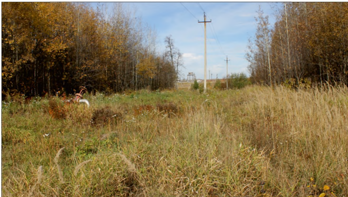
Рис.13. «Строительство высоконапорного водовода от КНС-1 до скв.973». Зюзеевское нефтяное месторождение, Республика Татарстан, Нурлатский муниципальный район. Точка фотофиксации 3. Вид с юго-юго-востока.
