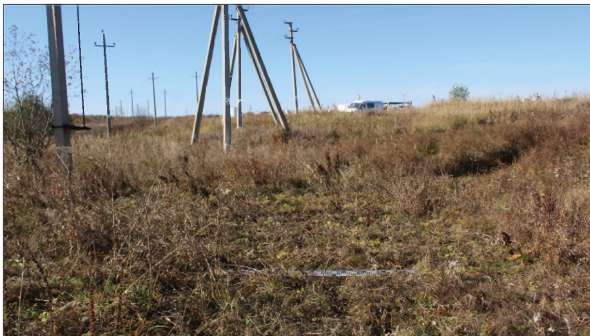
Рис.38. «Строительство высоконапорного водовода от КНС-1 до скв.973». Зюзеевское нефтяное месторождение, Республика Татарстан, Нурлатский муниципальный район. Место под шурф 4. Вид с востока.
