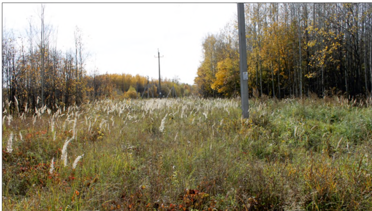
Рис.14. «Строительство высоконапорного водовода от КНС-1 до скв.973». Зюзеевское нефтяное месторождение, Республика Татарстан, Нурлатский муниципальный район. Точка фотофиксации 3. Вид с севера.
