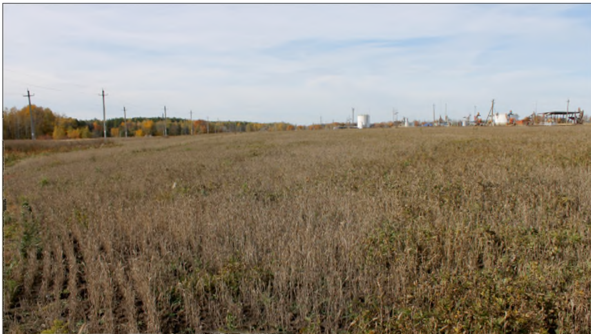
Рис.11. «Строительство высоконапорного водовода от КНС-1 до скв.973». Зюзеевское нефтяное месторождение, Республика Татарстан, Нурлатский муниципальный район. Точка фотофиксации 2. Вид с востока.
