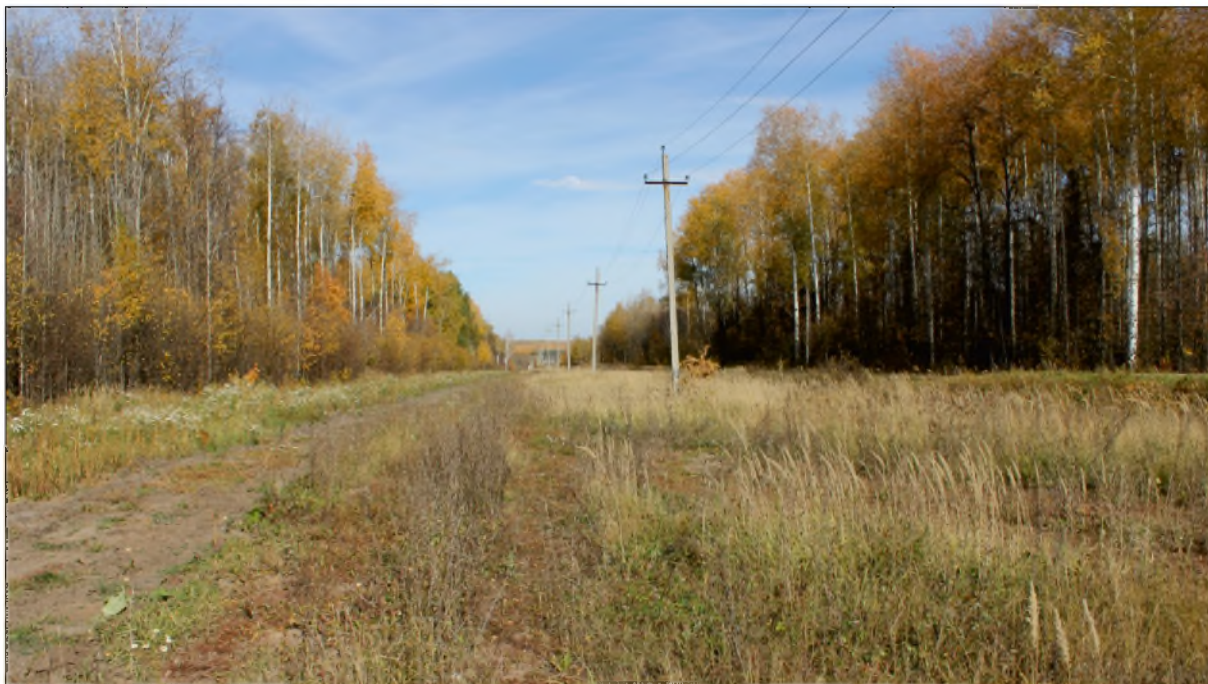
Рис.17. «Строительство высоконапорного водовода от КНС-1 до скв.973». Зюзеевское нефтяное месторождение, Республика Татарстан, Нурлатский муниципальный район. Точка фотофиксации 5. Вид с юга.
