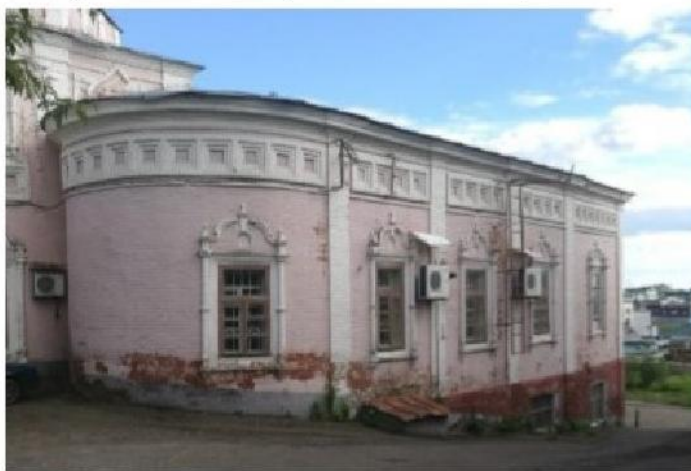
Северо-западный фасад. Северо-западная апсида. Вид с севера.
