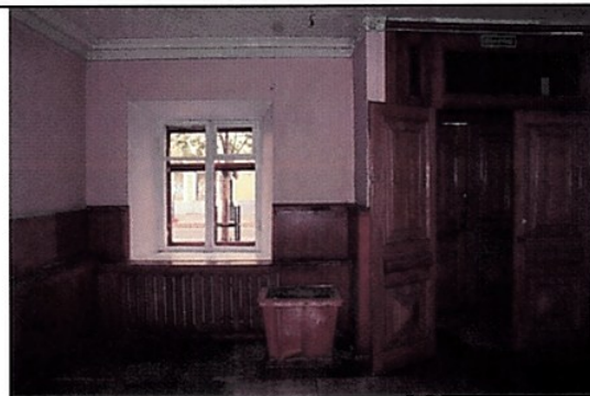
Оконные и дверные проемов
