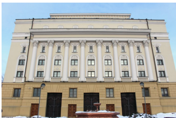
Задний фасад по ул. Дзержинского
