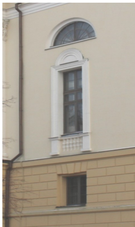
Фрагмент бокового фасада
