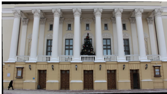
Фрагмент главного фасада по ул. Карла Маркса
