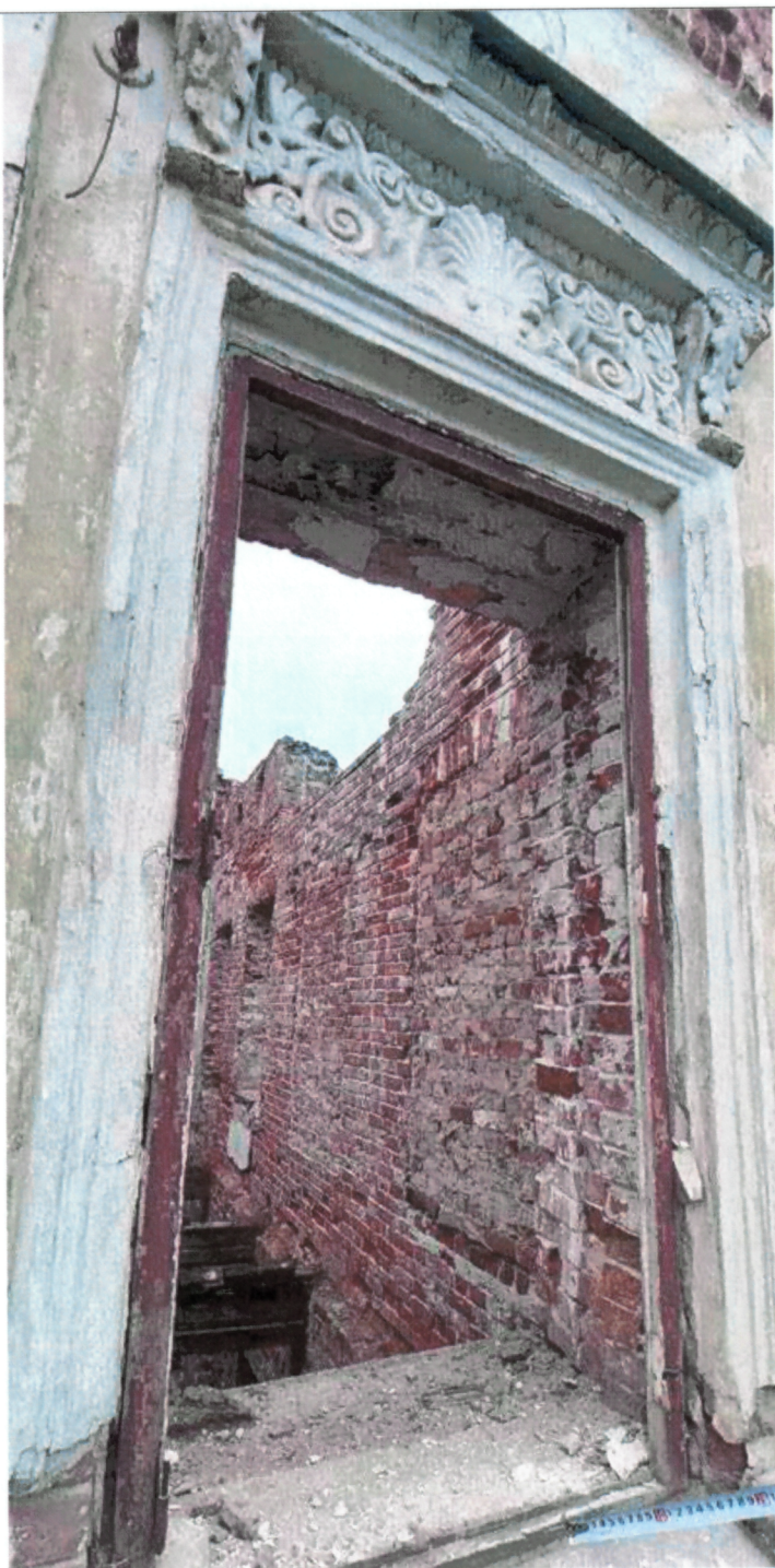
Оконный проем 2-го этажа.
