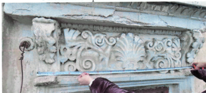
Прямолинейные профилированные сандрики оконных проемов 2-го этажа на фигурных консолях.
