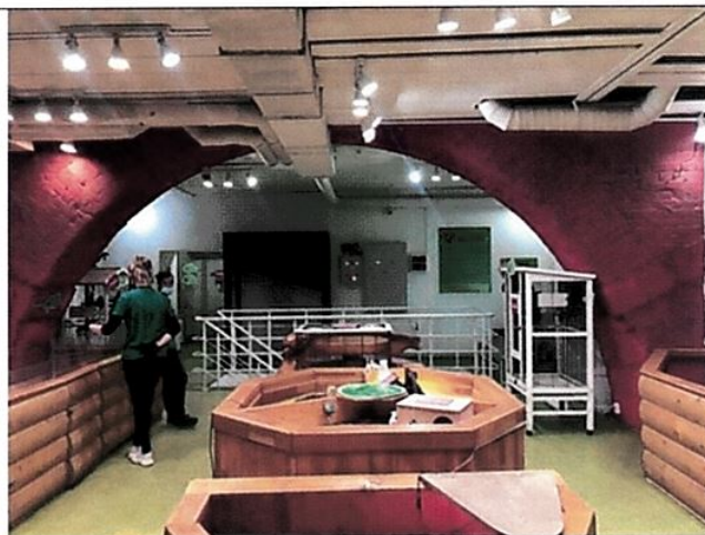
Вид стены 1 этажа с арочным проемом
