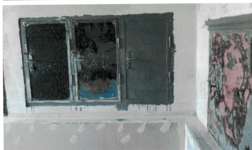
Пом. №1: 4 встроенных в стену металлических сейфа.
