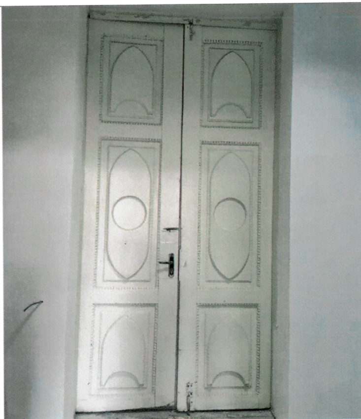
Пом. №4: историческая двустворчатая деревянная филенчатая дверь с декоративным оформлением.
