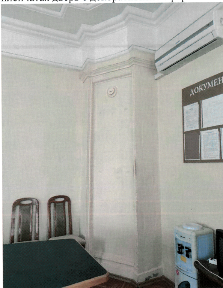
Пом. №5: угловая изразцовая печь, профилированные тяги.
