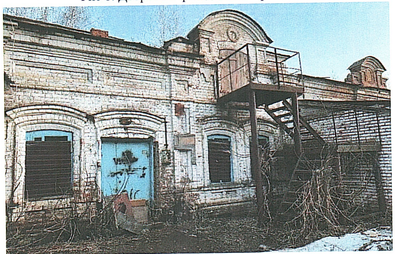
Рис 9. Дворовый фасад здания флигеля
