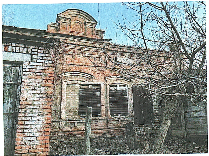
Рис 8. Дворовый фасад здания флигеля
