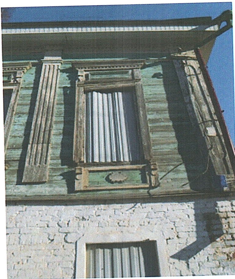
Рис 9. Оконный наличник главного фасада.
