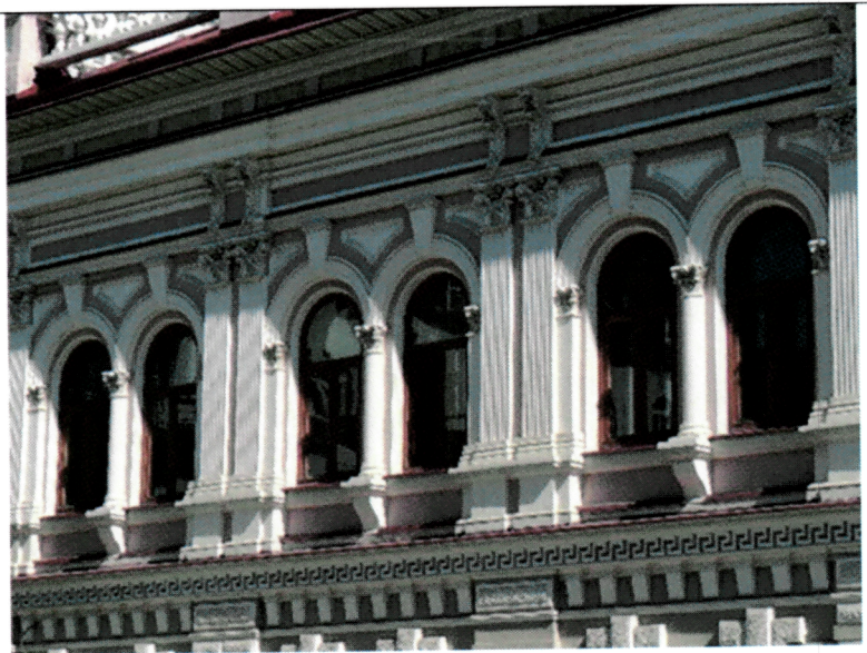
Оформление оконных проемов и простенков второго этажа.
