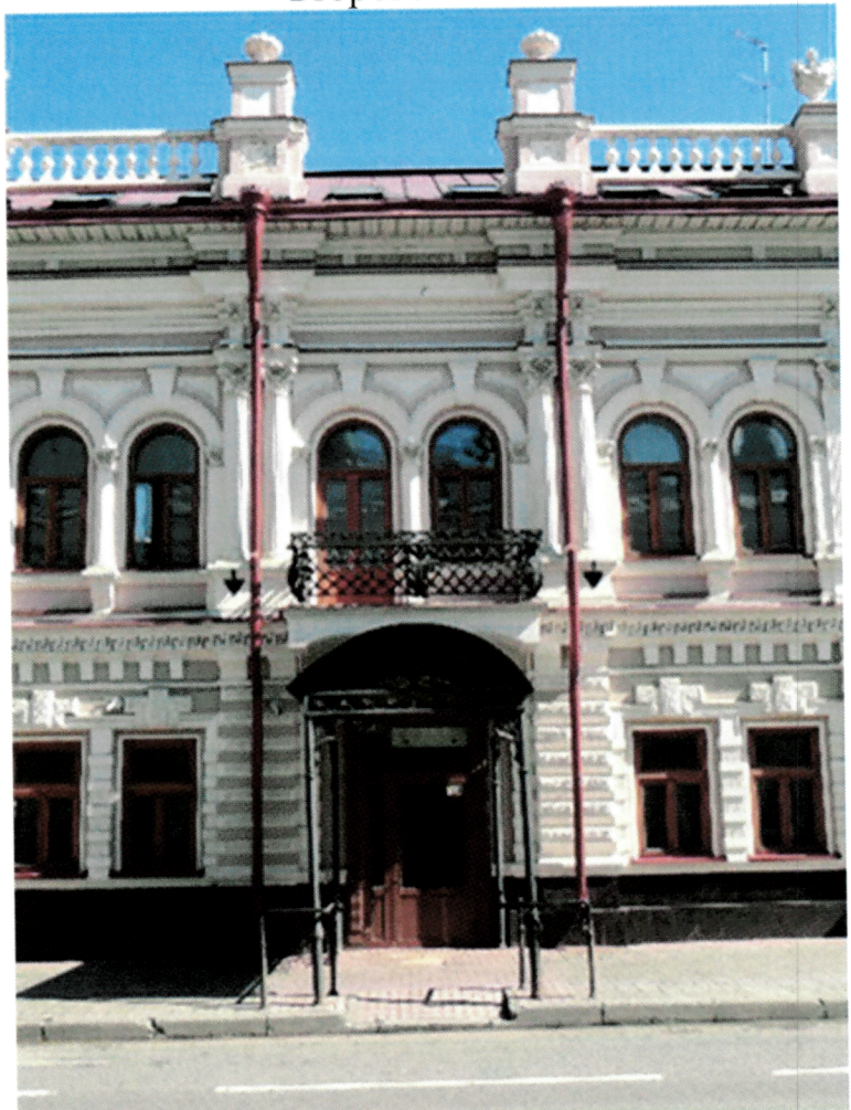
Оформление центральной части фасада с балконом (металлическое балконное ограждение воссоздано) и парадным входом по ул. Островского.
