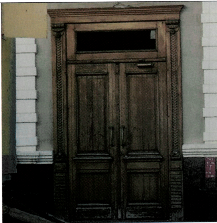
Дверной проем с заполнением по ул. Кави Наджми.
