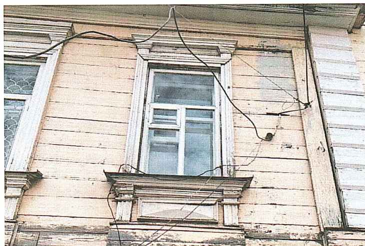
Рис 23. Оконный наличник главного фасада
