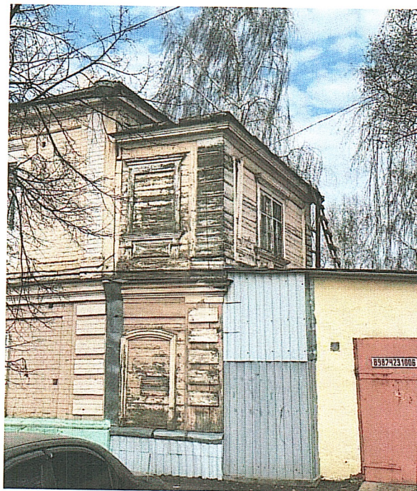
Рис 9. Фрагмент бокового и дворового фасада
