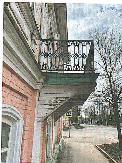
Рис 15. Балкон по улице К.Либкнехта
