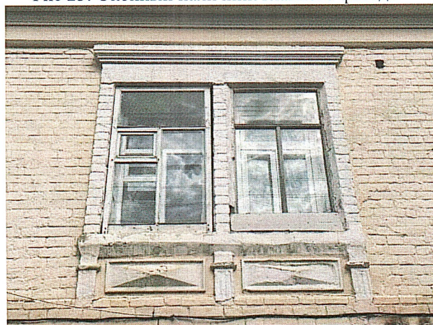
Рис 24. Оконные проемы фасада по улице Ленина
