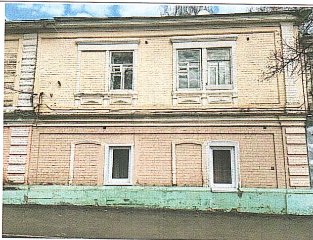
Рис 8. Фрагмент бокового фасада
