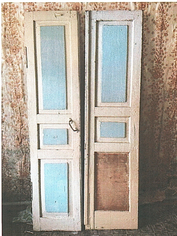
Рис 38. Филенчатая дверь
