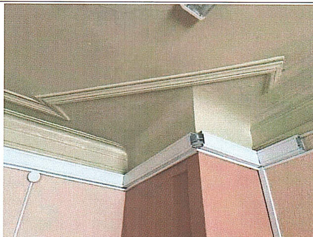
Рис 29. Потолочные тяги
