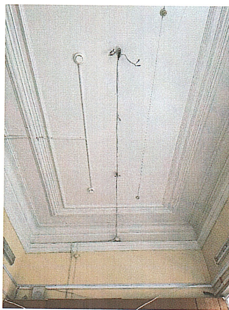
Рис 35. Потолочные и карнизные тяги
