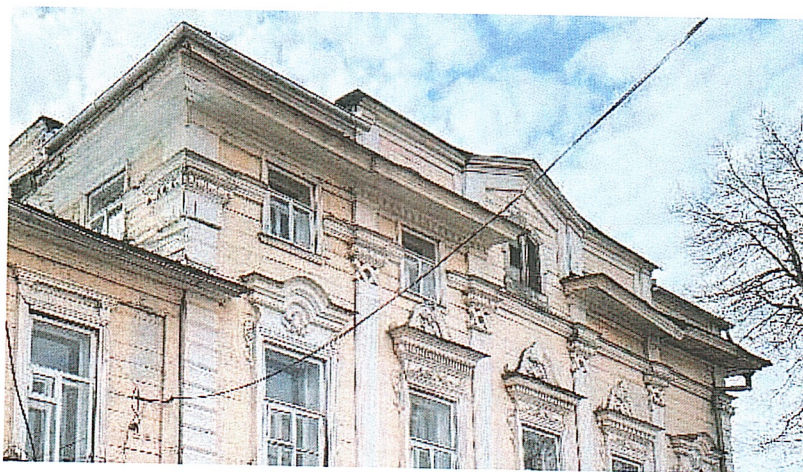
Рис 16. Венчающий здание парапет
