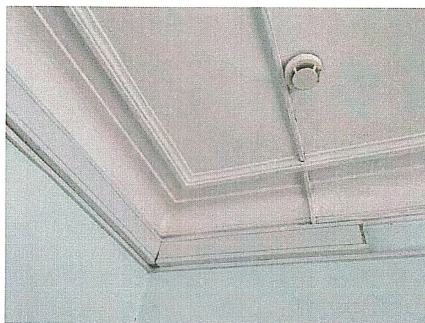
Рис 31. Потолочные и карнизные тяги
