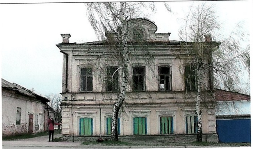
Рис. 7. Главный (восточный) фасад
