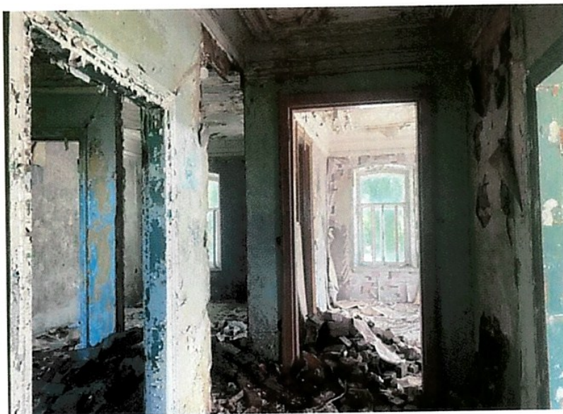
Рис. 19. Фрагмент помещения 2-го этажа
