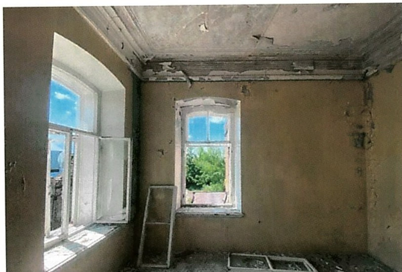
Рис. 22. Фрагмент помещения 2-го этажа с профилированными тягами
