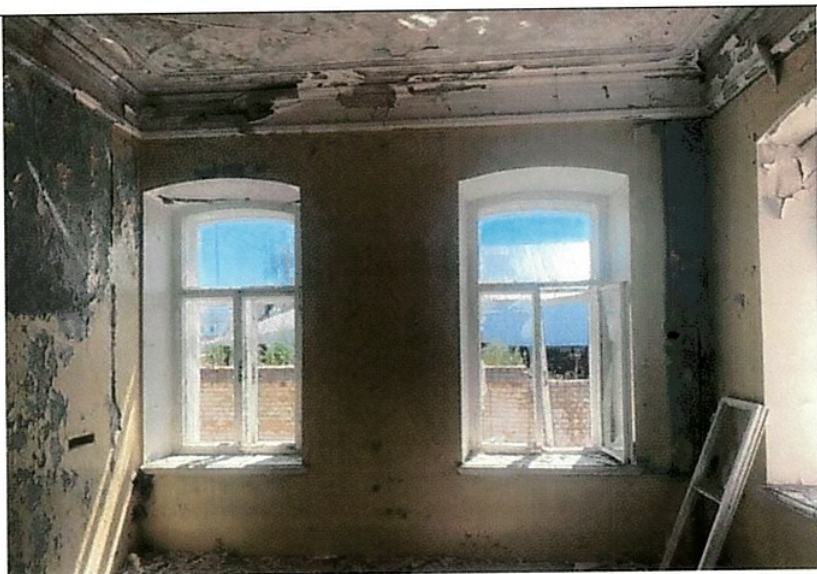
Рис. 20. Фрагмент помещения 2-го этажа
