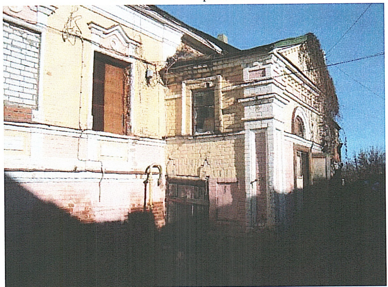
Рис 6. Дворовый фасад, входная группа главного дома
