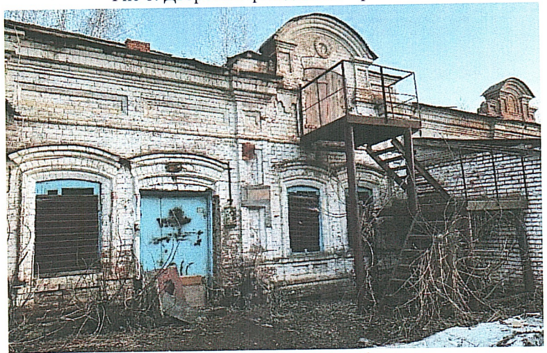
Рис 9. Дворовый фасад здания флигеля
