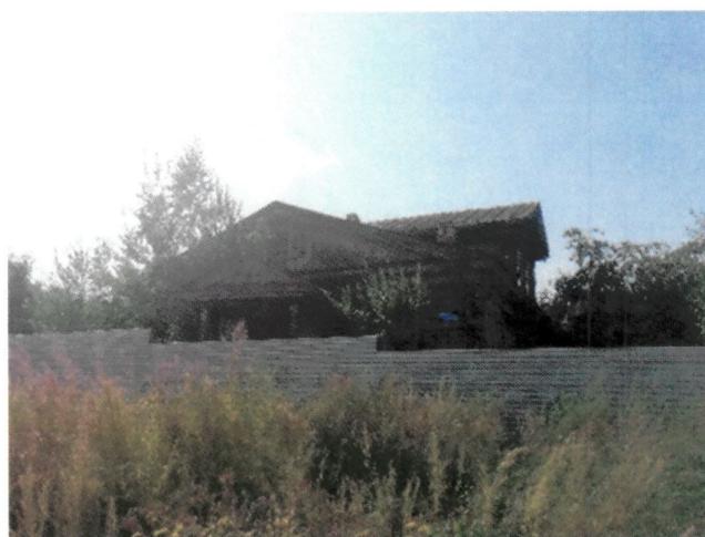
Рис. 11. Общий вид северо-восточного фасада
