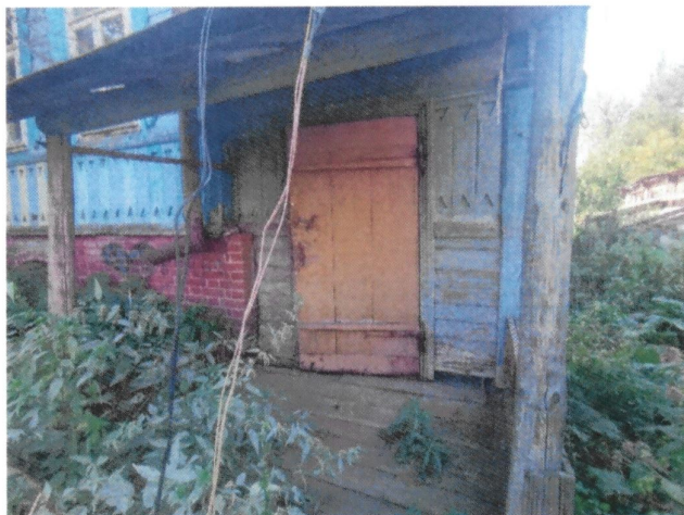
Рис. 7 – 9. Общие виды северо-западного фасада
