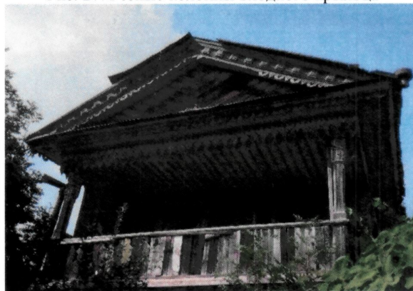
Рис. 28. Балкон юго-восточного фасада
