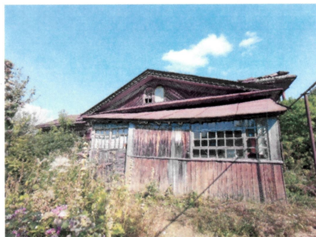
Рис. 15. Общий вид юго-западного фасада, веранда
