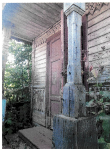
Рис. 13, 14. Фрагменты крыльца северо-восточного фасада
