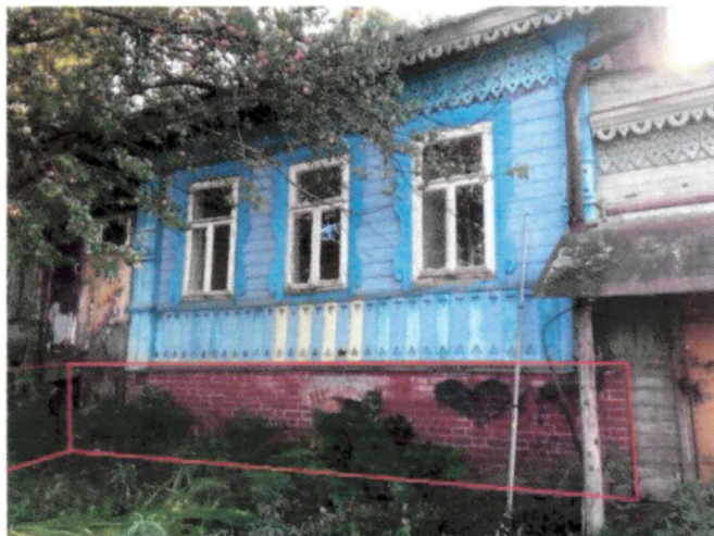
Рис. 31. Открытая кирпичная кладка фундамента
