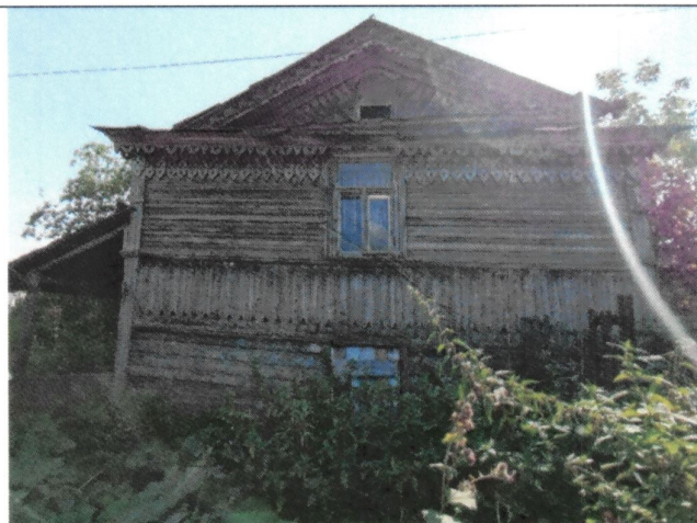
Рис. 10. Вид на северо-западный фасад
