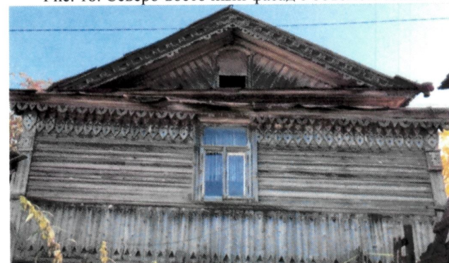
Рис. 19. Фронтон юго-западного фасада
