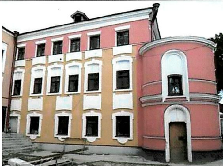
Дворовый фасад с выделенным цветом разновременными историческими деталями.
