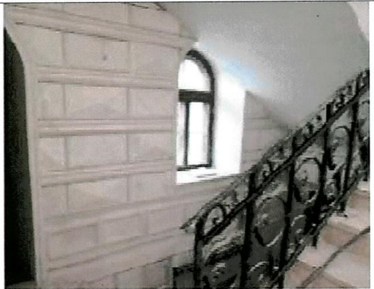
Парадная лестница на уровне 1-го этажа.
