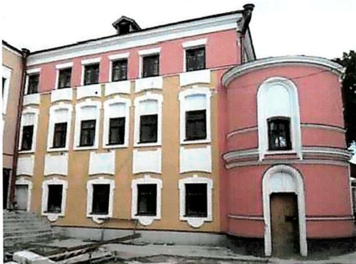
Восстановленные столярные заполнения оконных проемов.
