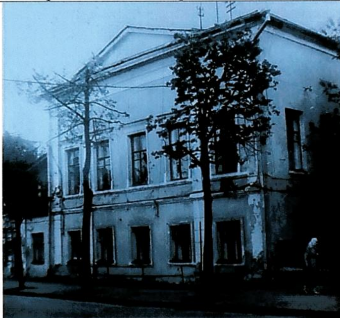
Историческая расстекловка главного фасада.
