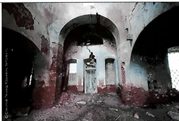
Лучковые перемычки оконных и дверных проемов первого яруса храма со стороны интерьера, арочные перемычки проемов 1-го этажа
