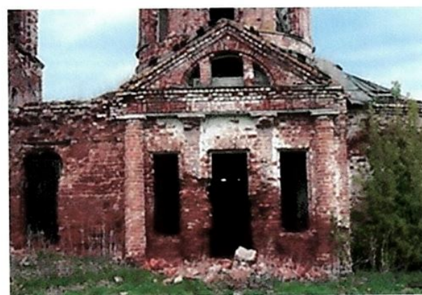
Первый ярус храма. Классический пристенный портик с четырьмя колоннами тосканского ордера, двумя высокими оконными и дверным по центру проемами. Портик завершается треугольным фронтоном с крупным полуарочным трехчастным проемом
