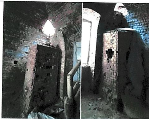
Две кирпичные прямоугольные в плане печи всеверной и южной частях трапезной
