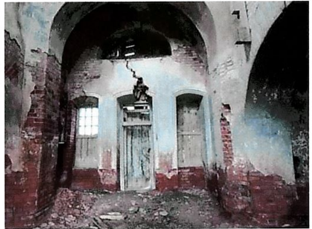
Профилированные тяги в обрамлении оконных и дверных проемов первого яруса кафоликона
