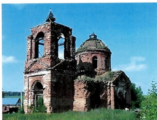
Общий вид на объект с юго-западной стороны
