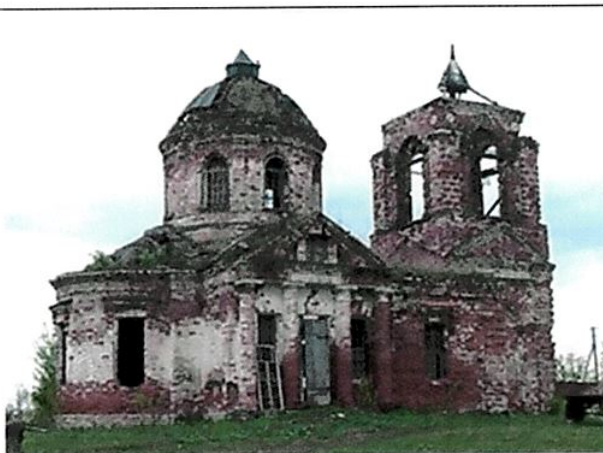
Общий вид на объект с северной стороны
