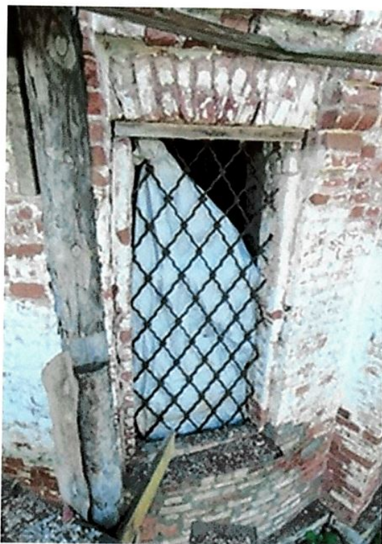
Кованые металлические решетки кубоватого рисунка оконных проемов первого этажа
