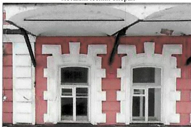
Рис 14. Сегментное (лучковое) перекрытие на металлических опорах
