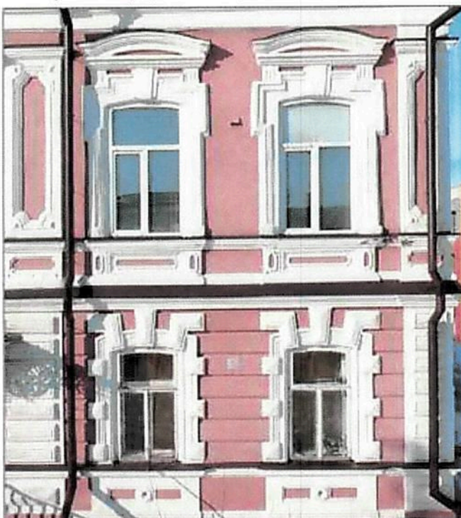
Рис 24. Профилированные наличники окон с строеными (веерными) замковыми камнями и филенками в мотивах «ананасный руст»
