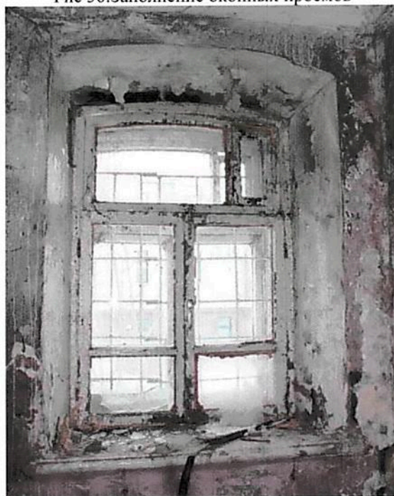
Рис 37. Оконный расцвет; раскладка столярного заполнения
