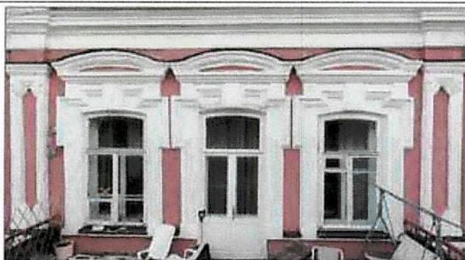
Рис 10. Пилястры с нишами и филёнками. Фланкировка раскреповки (плоскость балкона)
