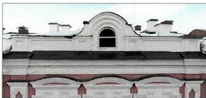
Рис 11. Атик с квадратными и прямоугольными перспективными нишами и полуциркульным оконным проемом в тимпане; кирпичные выпуски труб; венчающий карниз; лучковые сандрики центральной трехосевой раскреповки фасада (окна балкона); фланкировка раскреповки пилястрами с нишами с изломами в углах и полукружиями
