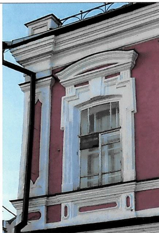
Рис 36. Заполнение оконных проёмов
