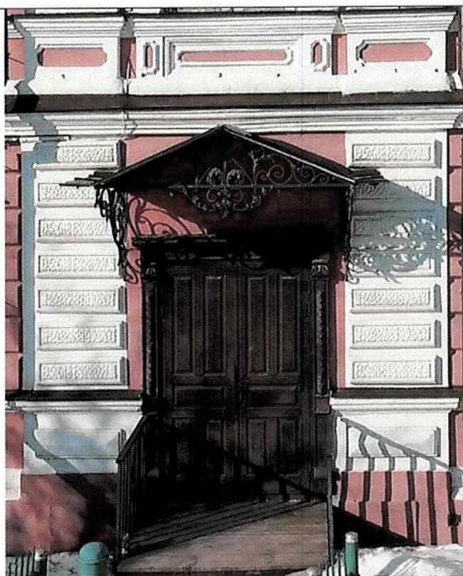
Рис 23. Металлический зонт со скатной кровлей; декоративное убранство обрамления дверного проема
