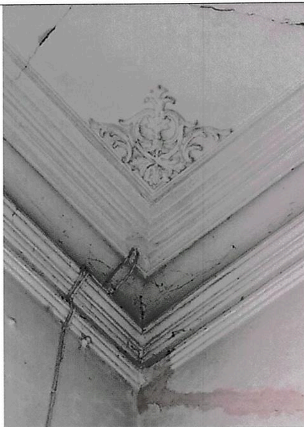
Рис 41. Галтельный карниз и лепной декор; профилированные тяги
