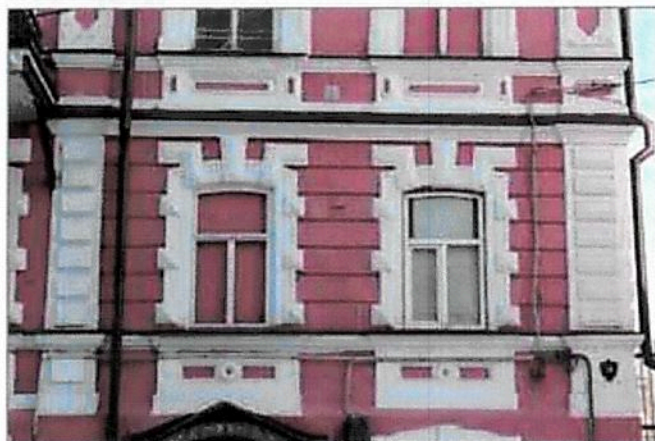
Рис 16. Штукатурный (плоский) наличник оконного проема первого этажа с замковым камнем. Металлический зонт со скатной кровлей над дверным проемом
