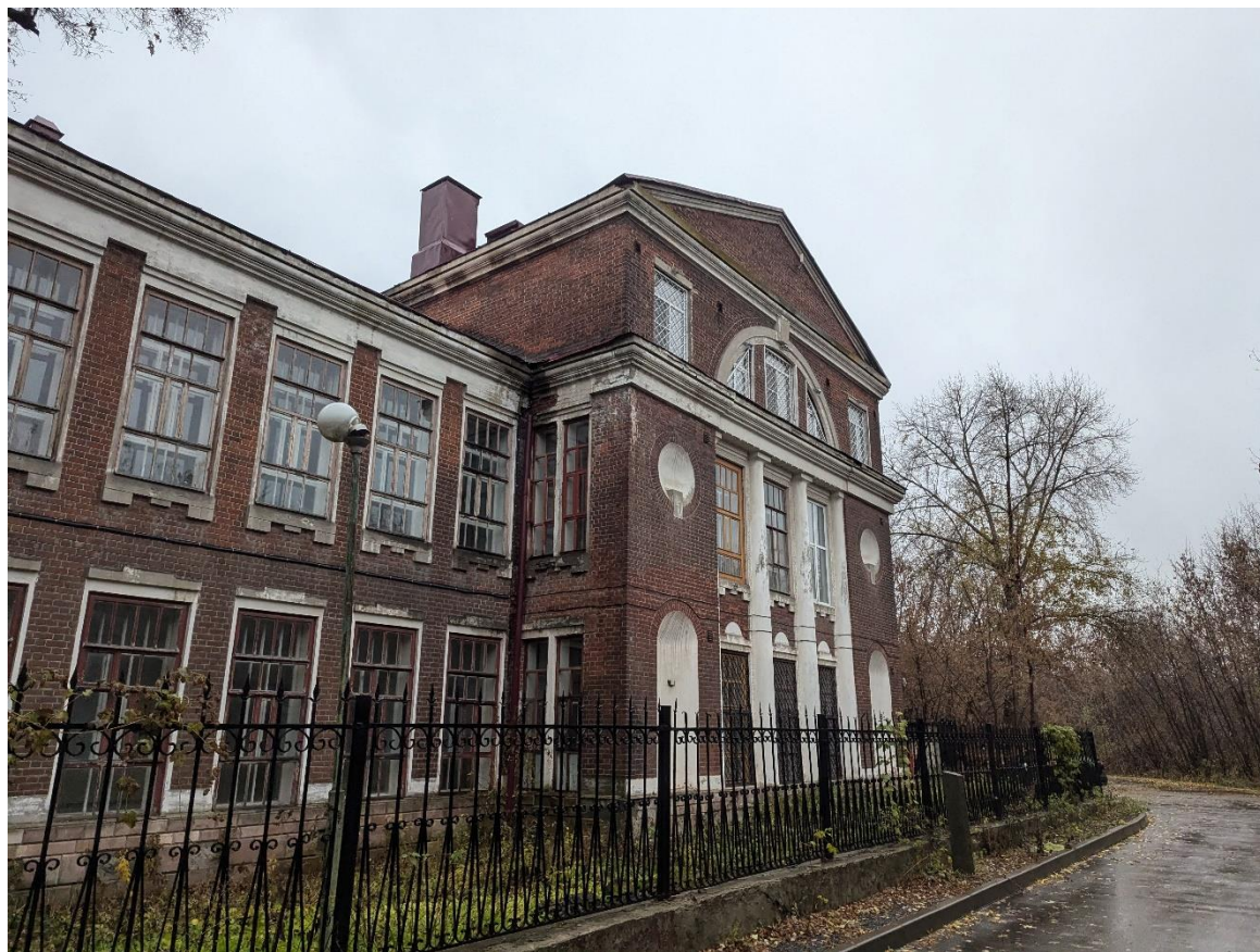
Кадр 3. Дата: 01.11.2024 г. Главный фасад, со стороны ул.Ватутина
