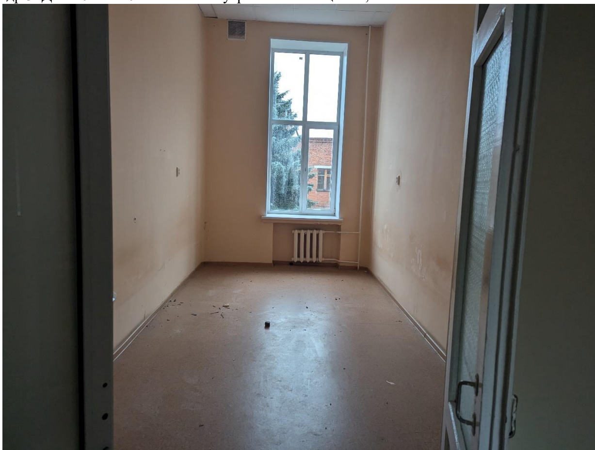
Кадр 4. Дата: 01.11.2024 г. Фото внутренних помещений, 2 этаж
