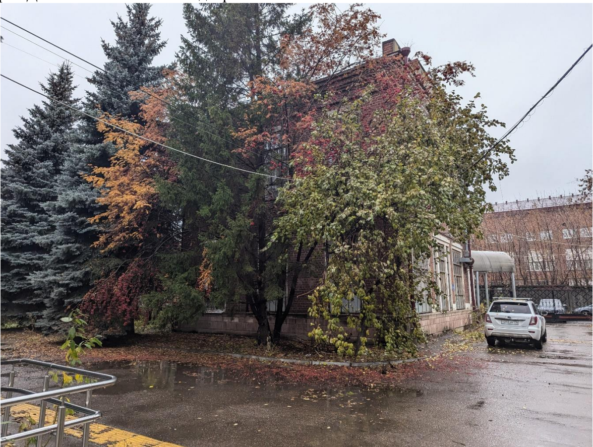
Кадр 10. Дата: 01.11.2024 г. Дворовый фасад
