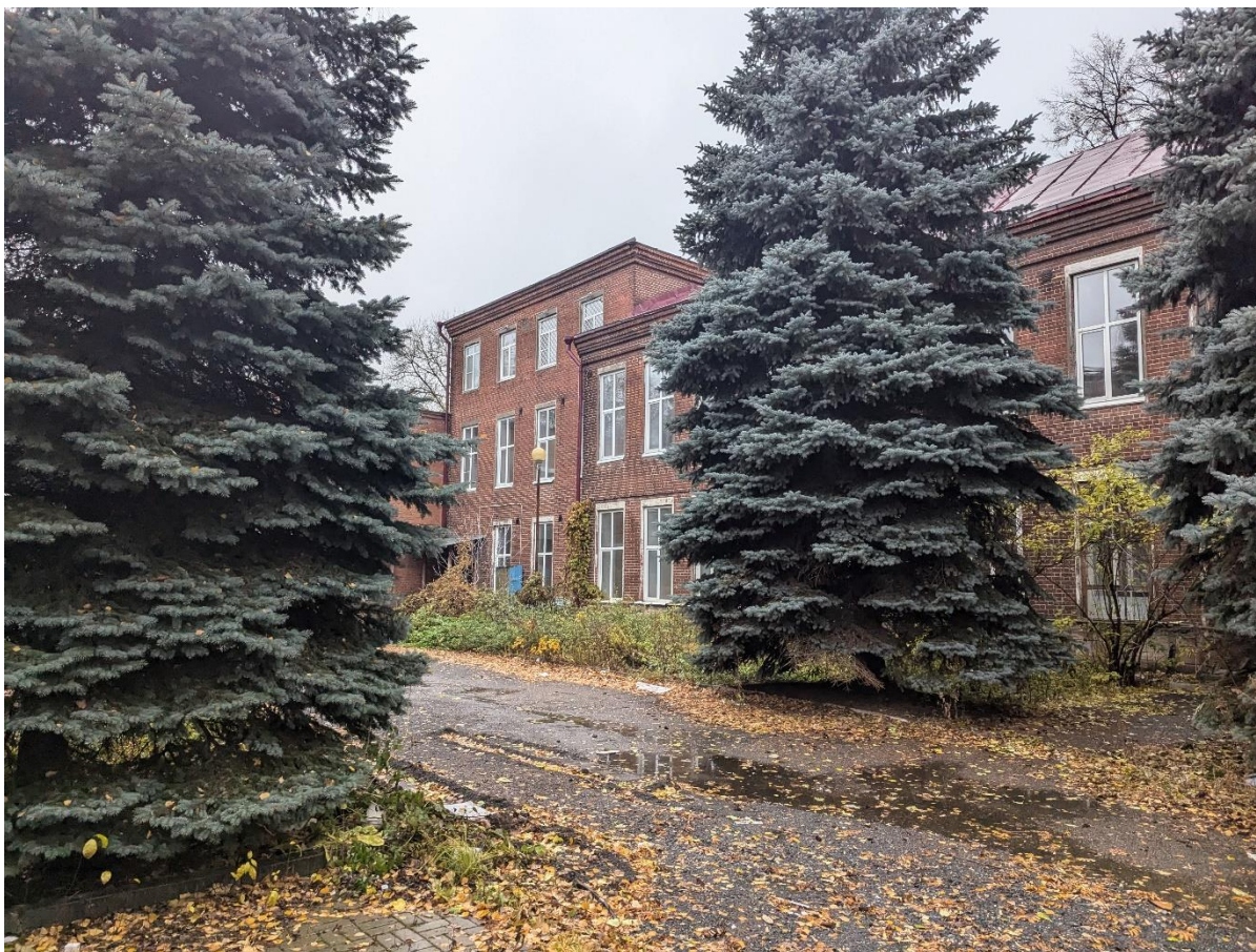
Кадр 11. Дата: 01.11.2024 г. Дворовый фасад
