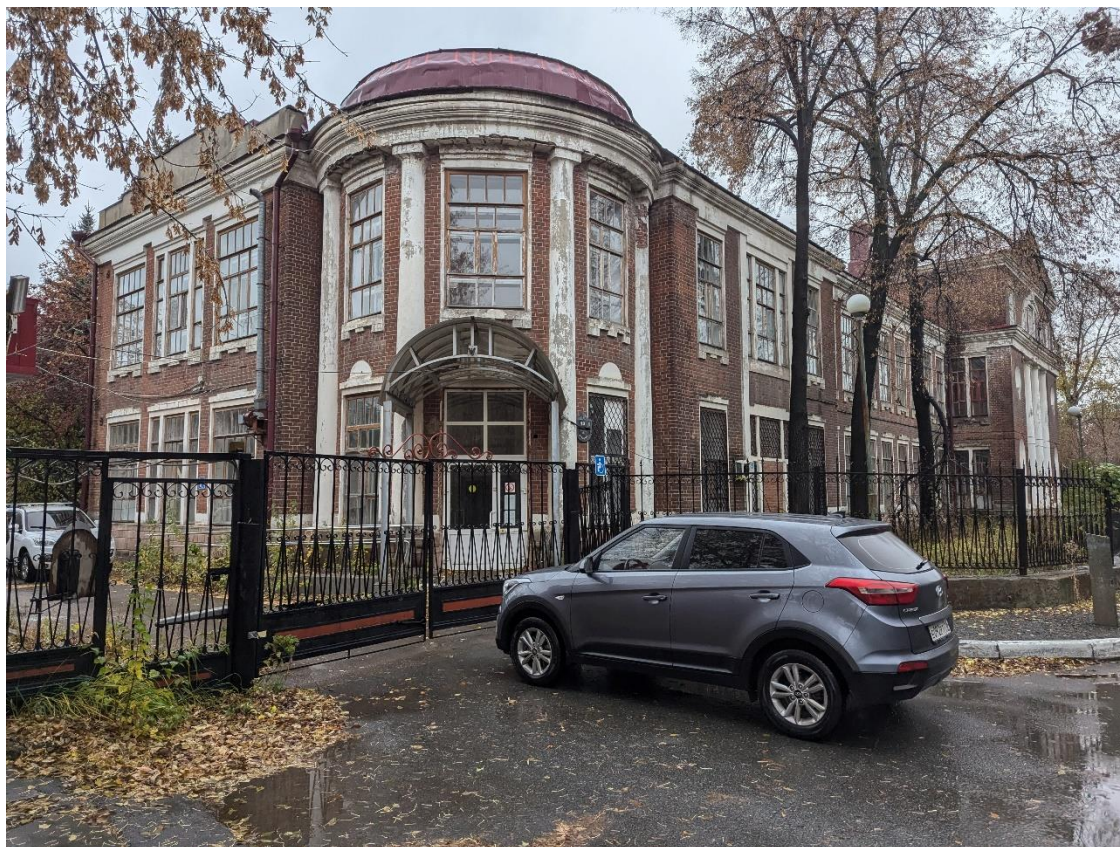
Кадр 1. Дата: 01.11.2024 г. Главный фасад, со стороны ул.Ватутина
