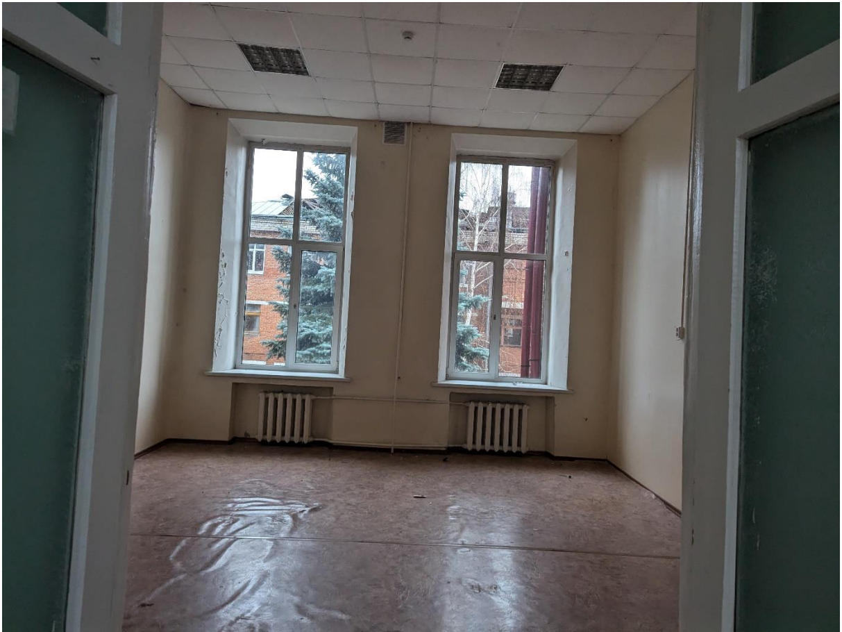
Кадр 11. Дата: 01.11.2024 г. Фото внутренних помещений, 2 этаж
