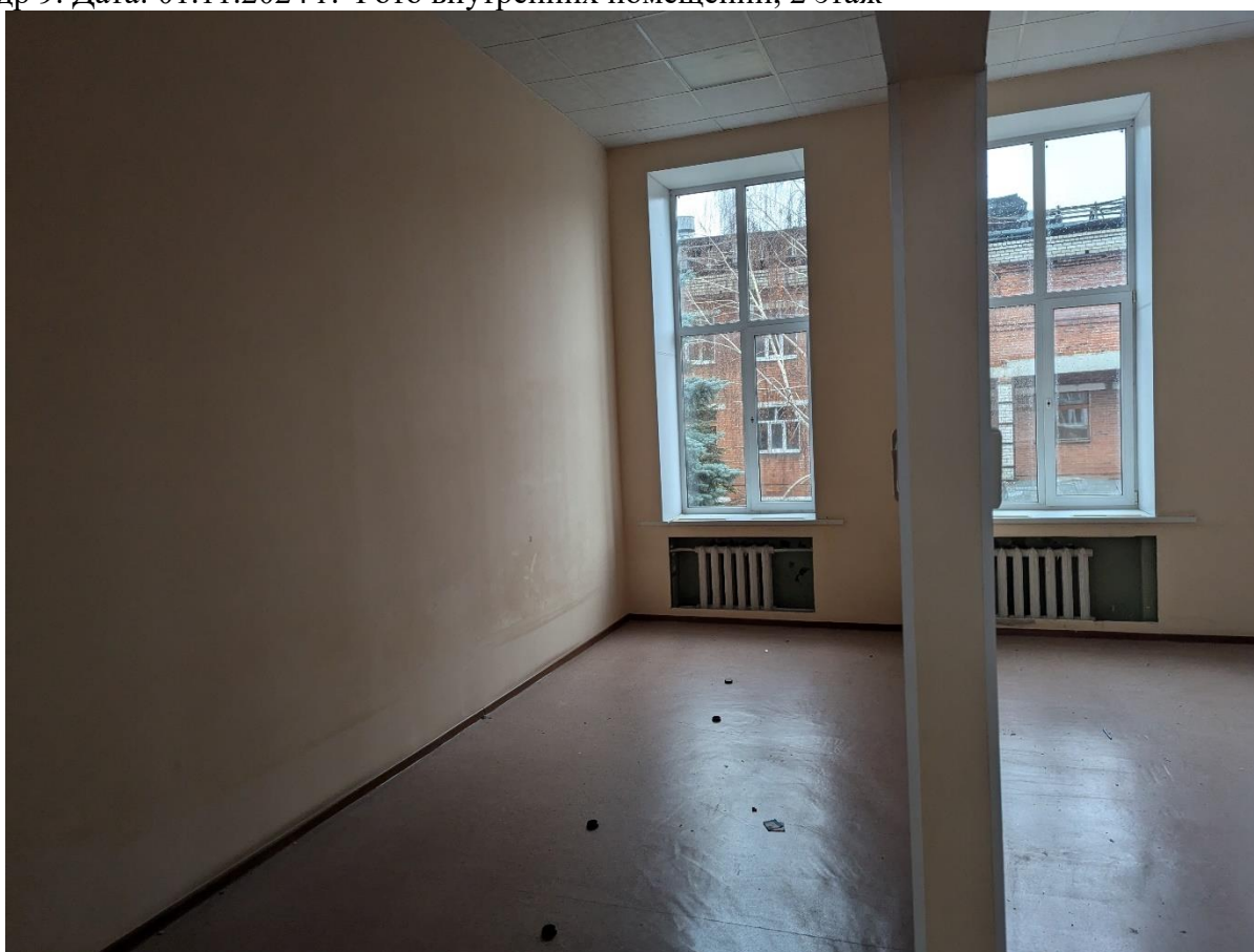
Кадр 10. Дата: 01.11.2024 г. Фото внутренних помещений, 2 этаж
