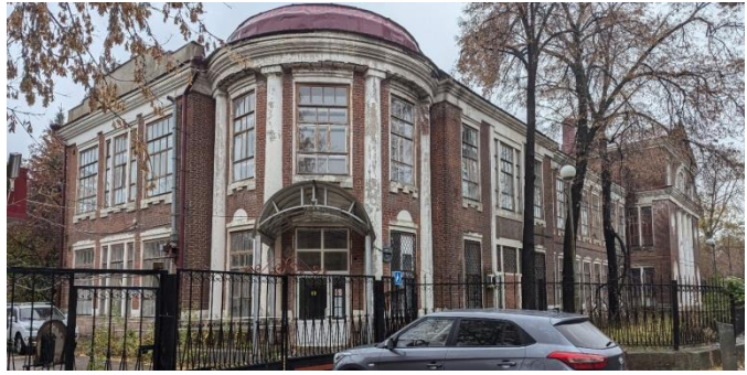
Общий вид на здание
