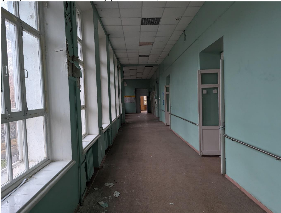
Кадр 8. Дата: 01.11.2024 г. Фото внутренних помещений, 2 этаж
