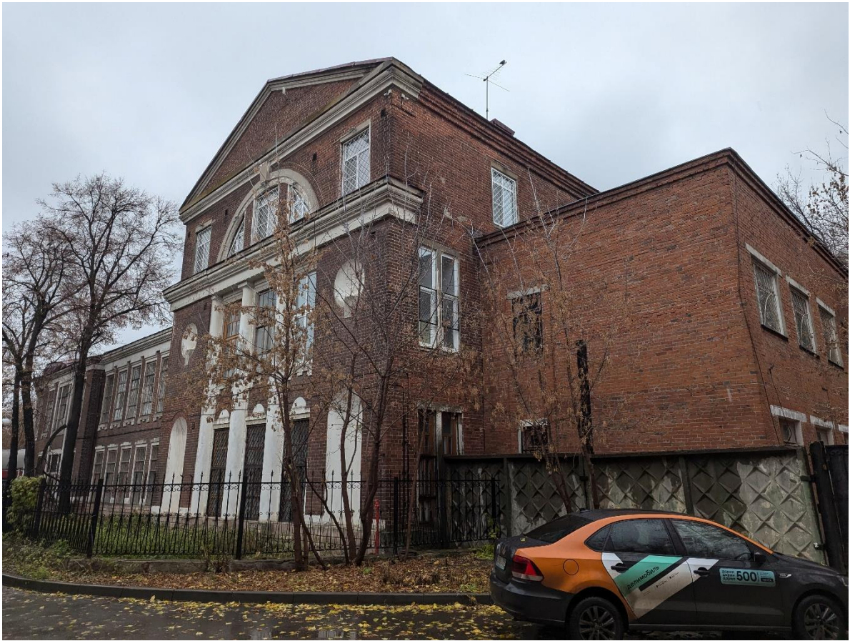
Кадр 5. Дата: 01.11.2024 г. Главный фасад, со стороны ул.Ватутина
