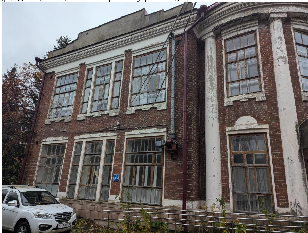
Кадр 8. Дата: 01.11.2024 г. Со стороны внутреннего двора
