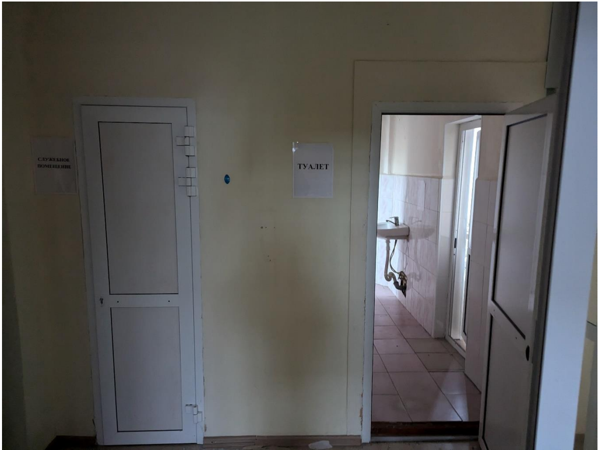
Кадр 1. Дата: 01.11.2024 г. Фото внутренних помещений, 2 этаж
