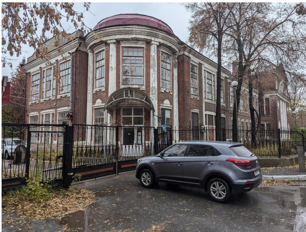
Кадр 2. Дата: 01.11.2024 г. Главный фасад, со стороны ул.Ватутина
