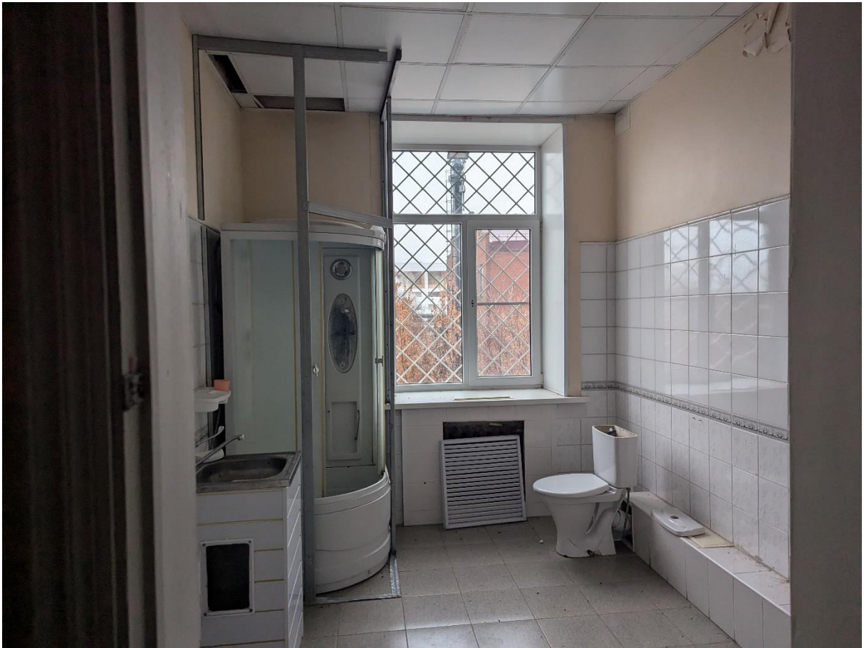
Кадр 9. Дата: 01.11.2024 г. Фото внутренних помещений, 3 этаж
