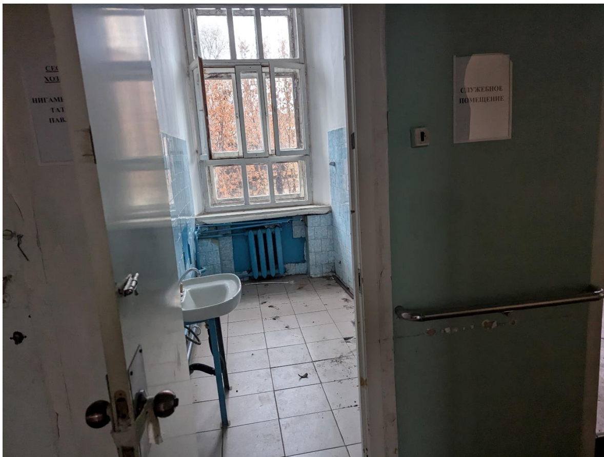
Кадр 5. Дата: 01.11.2024 г. Фото внутренних помещений, 2 этаж
