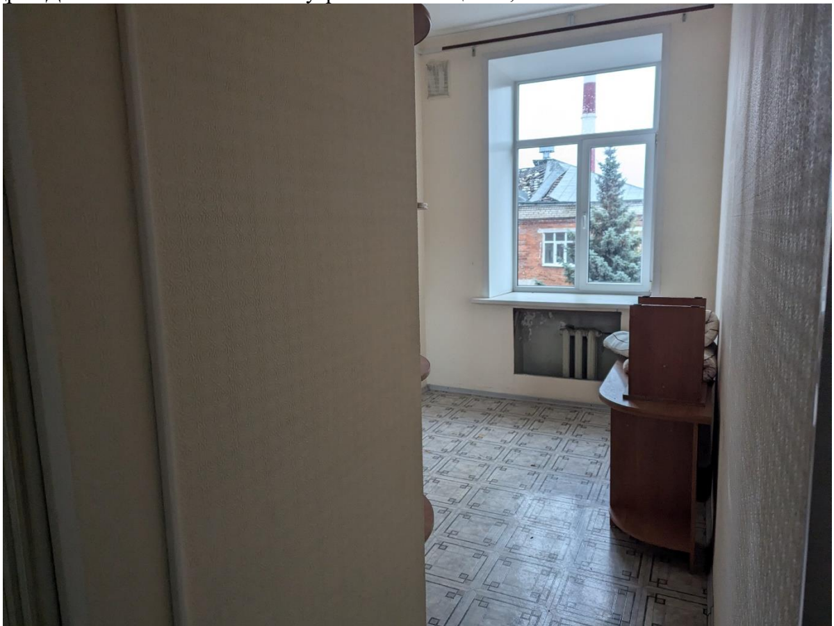
Кадр 10. Дата: 01.11.2024 г. Фото внутренних помещений, 3 этаж
