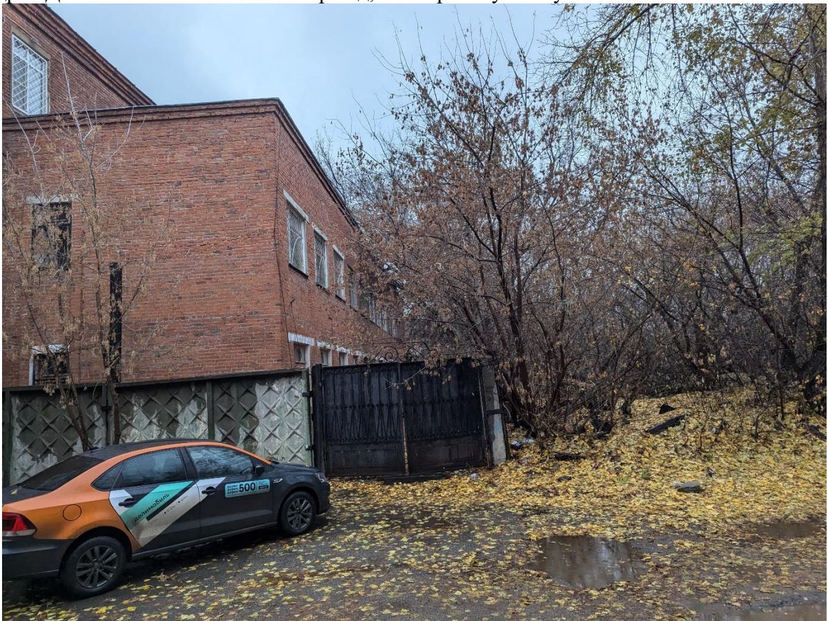
Кадр 6. Дата: 01.11.2024 г. Со стороны ул.Ватутина
