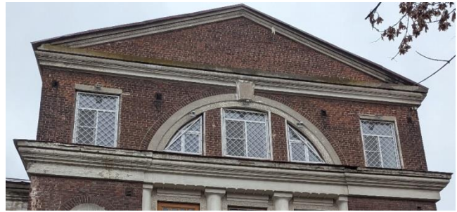
Оконные заполнения главного (южного) фасада.
