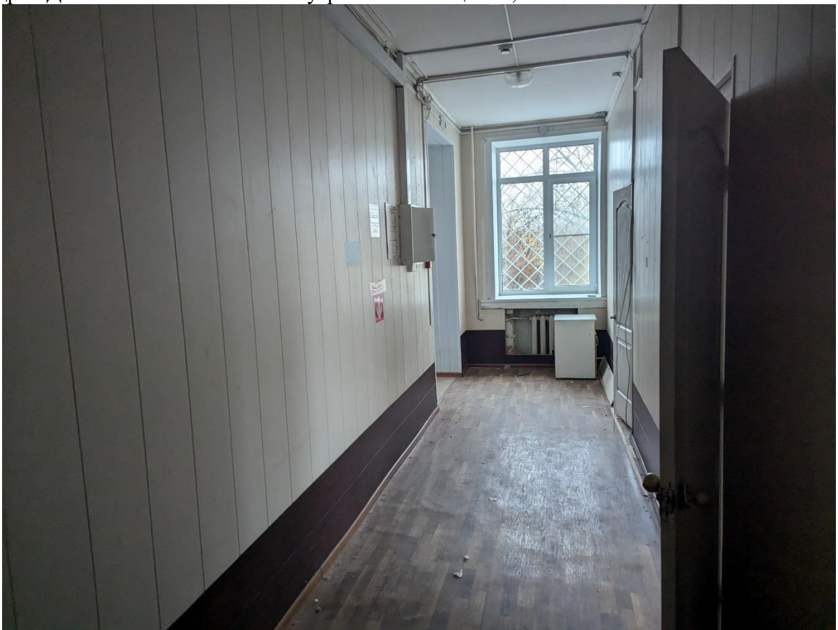
Кадр 6. Дата: 01.11.2024 г. Фото внутренних помещений, 3 этаж
