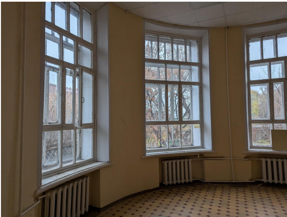
Кадр 18. Дата: 01.11.2024 г. Фото внутренних помещений, 2 этаж
