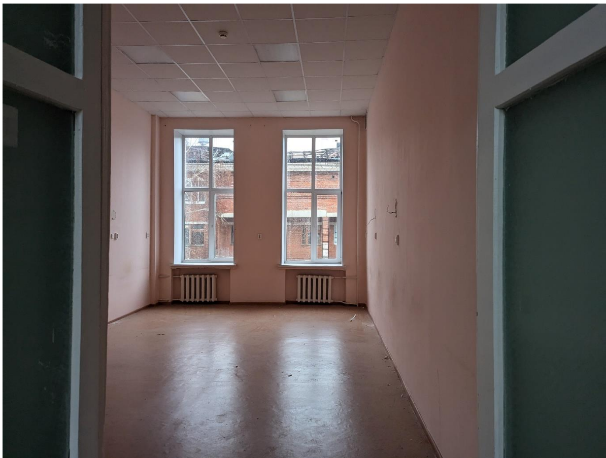
Кадр 13. Дата: 01.11.2024 г. Фото внутренних помещений, 2 этаж
