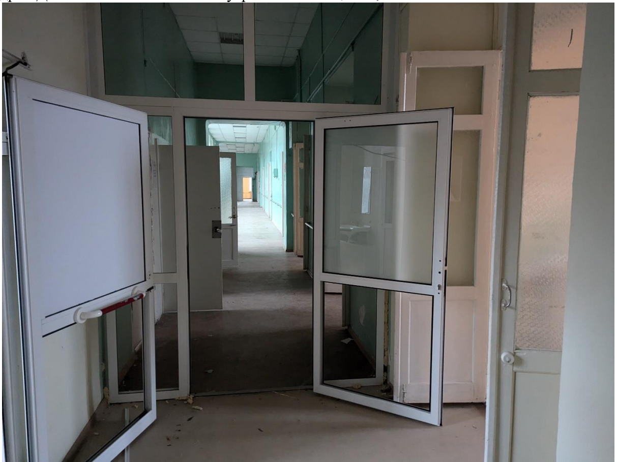
Кадр 2. Дата: 01.11.2024 г. Фото внутренних помещений, 2 этаж
