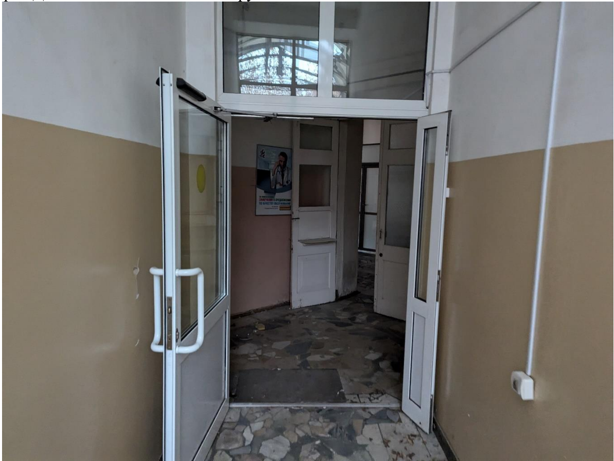
Кадр 2. Дата: 01.11.2024 г. Фото внутренних помещений
