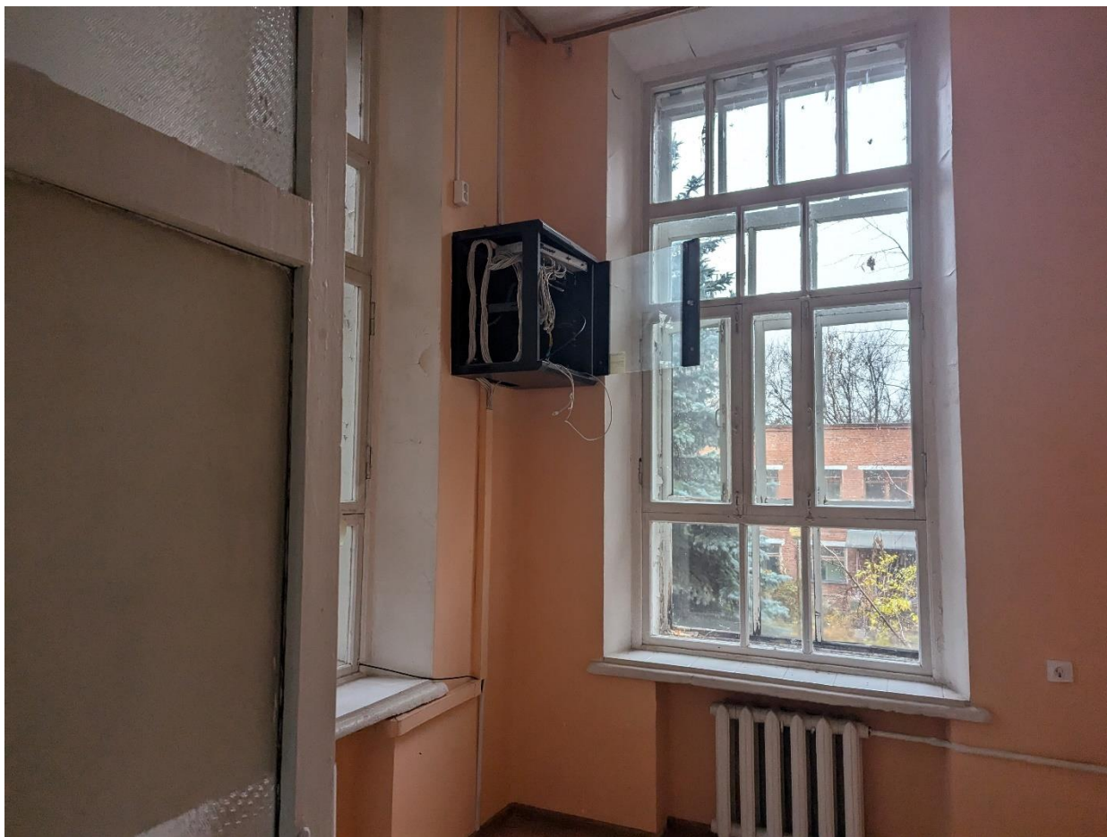
Кадр 22. Дата: 01.11.2024 г. Фото внутренних помещений, 2 этаж
