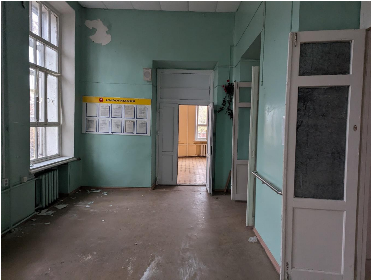
Кадр 16. Дата: 01.11.2024 г. Фото внутренних помещений, 2 этаж
