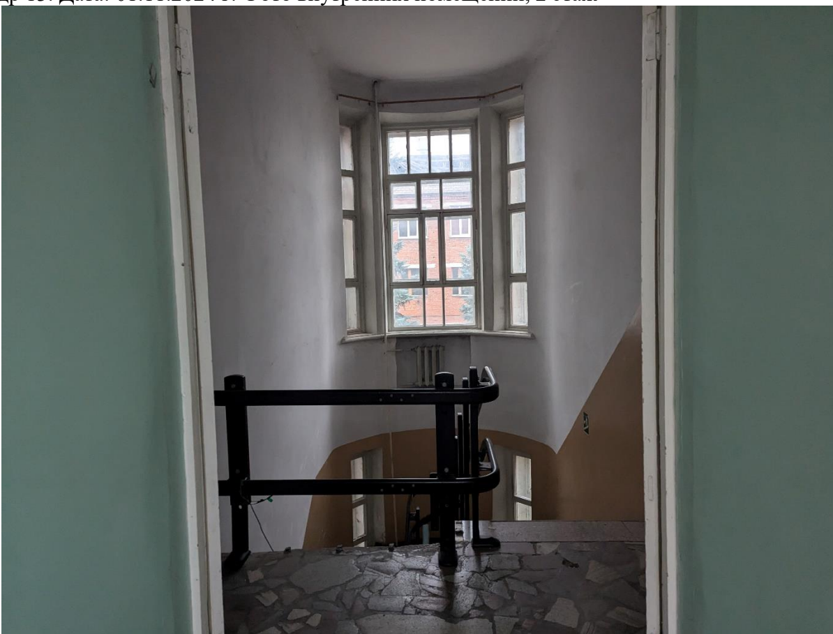
Кадр 14. Дата: 01.11.2024 г. Фото внутренних помещений, 2 этаж
