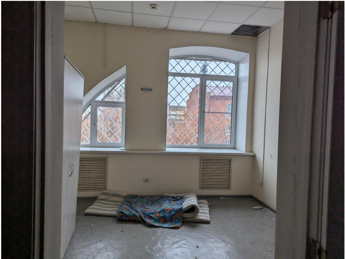
Кадр 1. Дата: 01.11.2024 г. Фото внутренних помещений, 3 этаж
