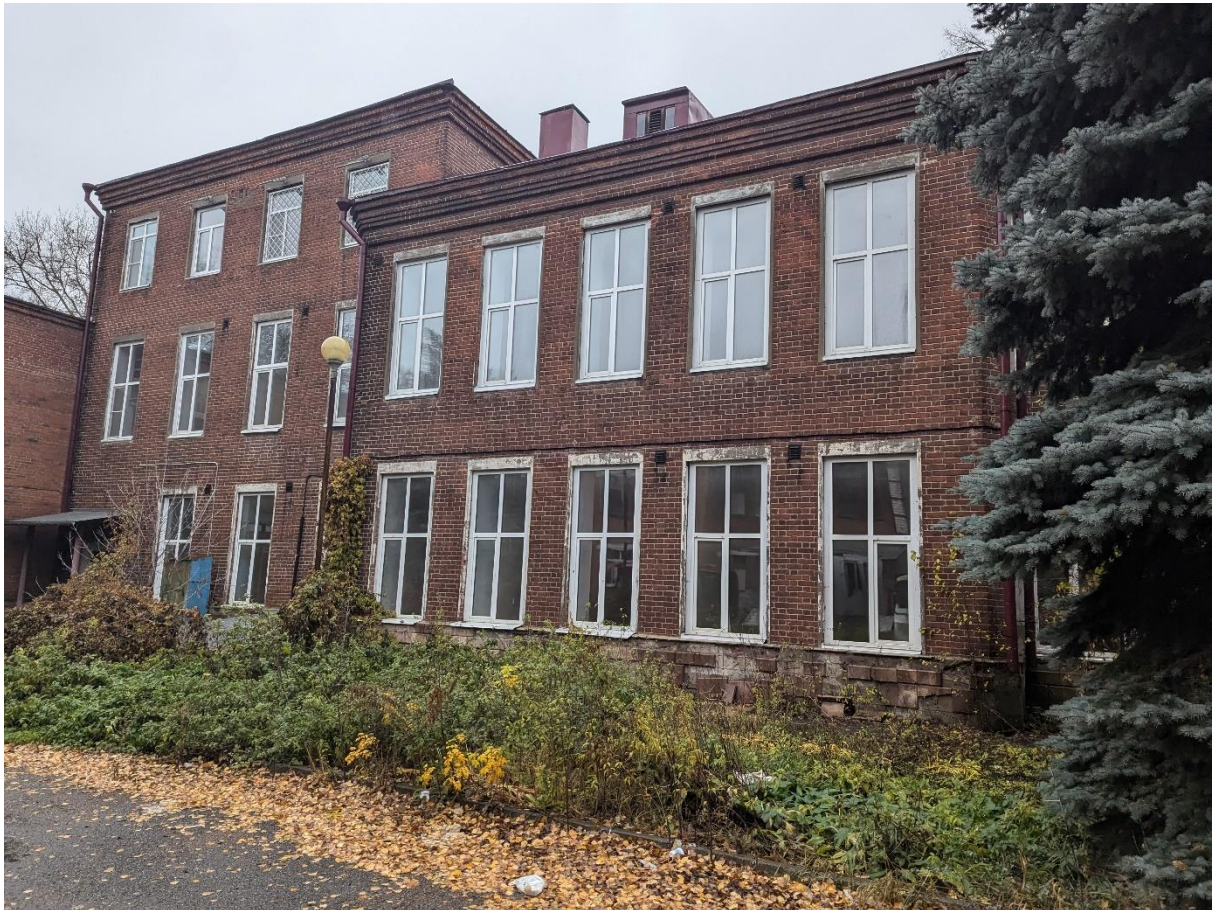
Кадр 13. Дата: 01.11.2024 г. Дворовый фасад
