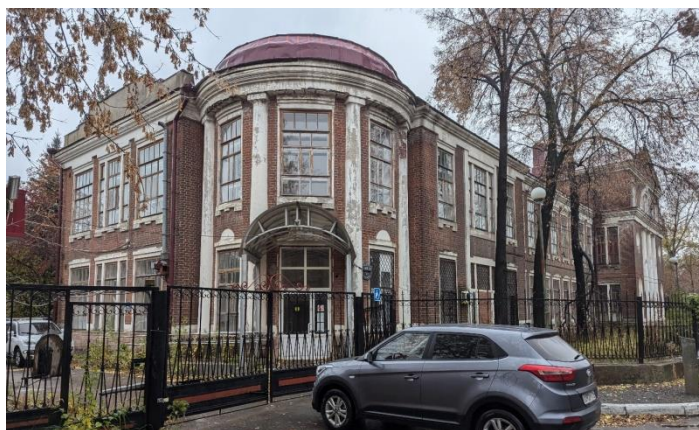
Общий вид на здание (западный фасад)
