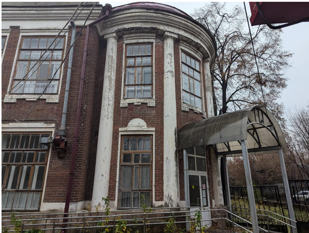
Кадр 7. Дата: 01.11.2024 г. Со стороны внутреннего двора
