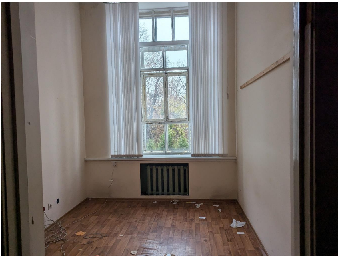
Кадр 20. Дата: 01.11.2024 г. Фото внутренних помещений, 2 этаж
