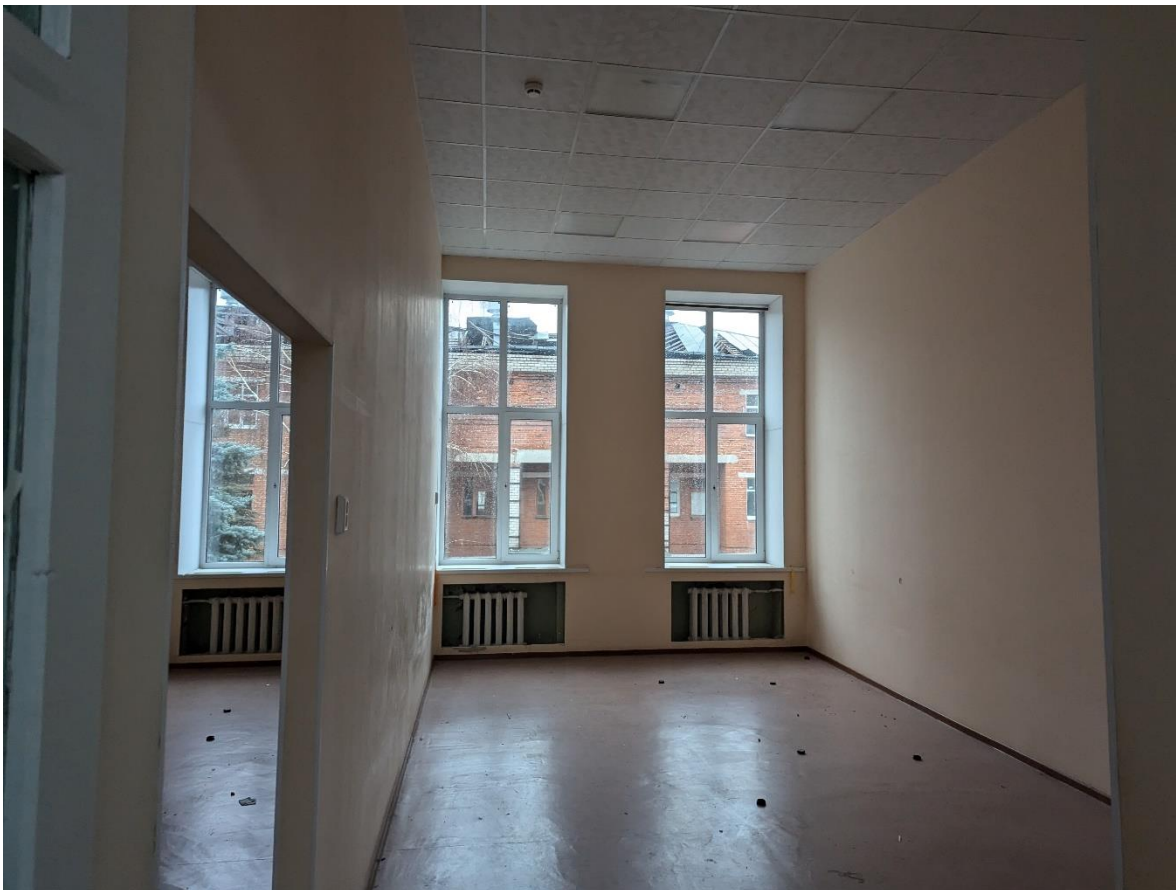
Кадр 9. Дата: 01.11.2024 г. Фото внутренних помещений, 2 этаж
