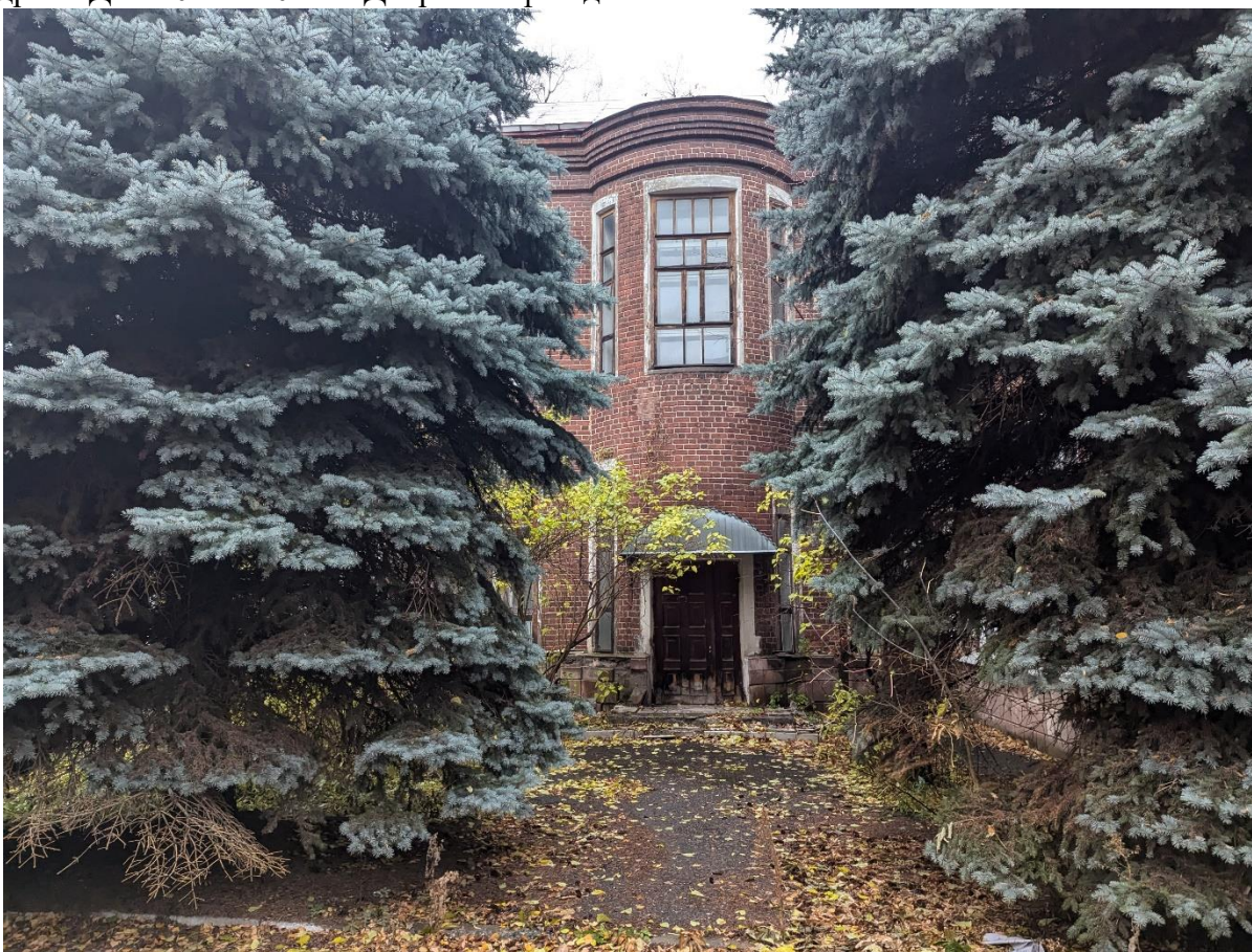
Кадр 12. Дата: 01.11.2024 г. Дворовый фасад
