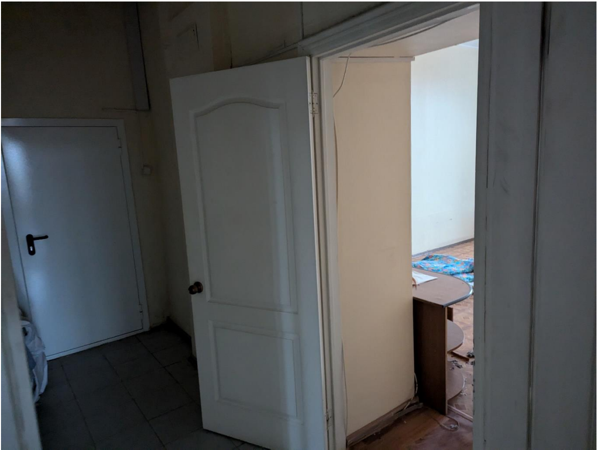
Кадр 7. Дата: 01.11.2024 г. Фото внутренних помещений, 3 этаж
