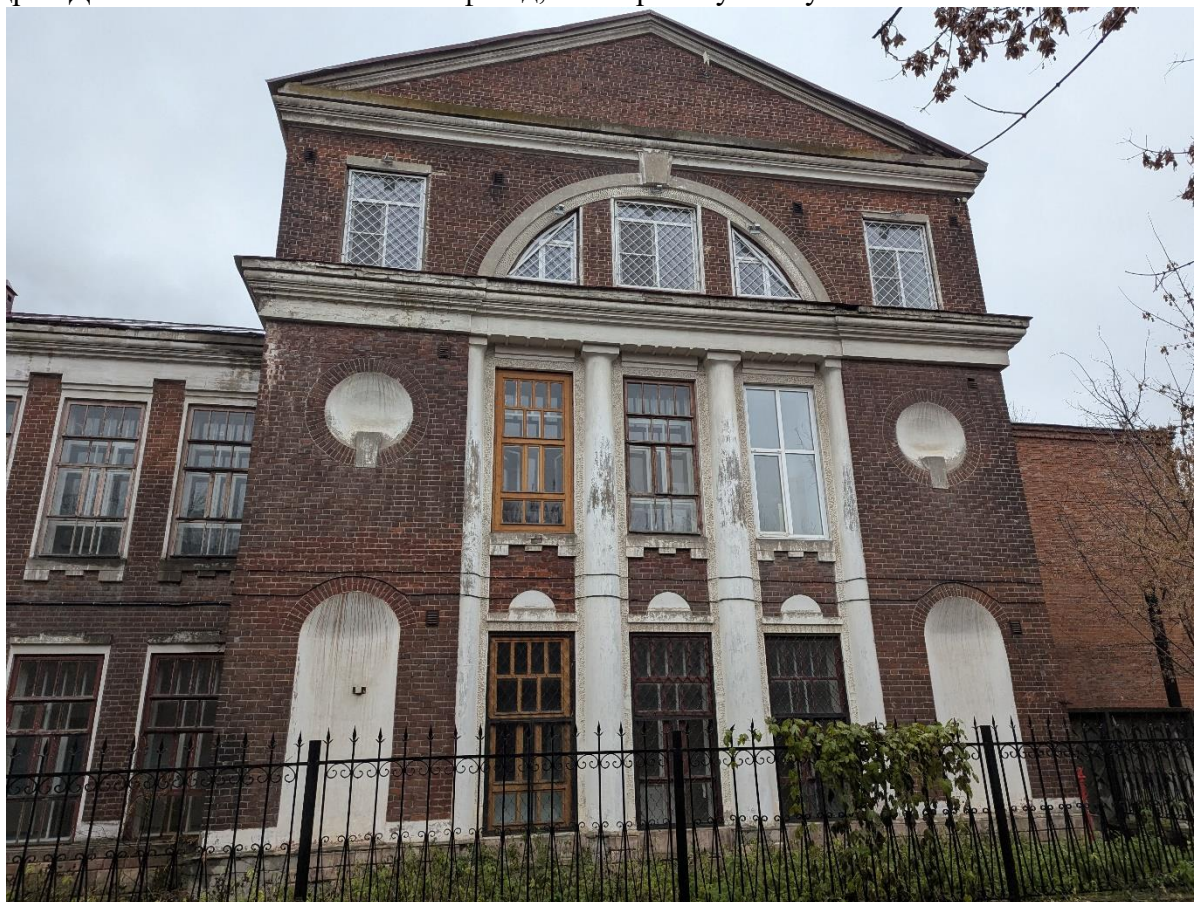
Кадр 4. Дата: 01.11.2024 г. Главный фасад, со стороны ул.Ватутина
