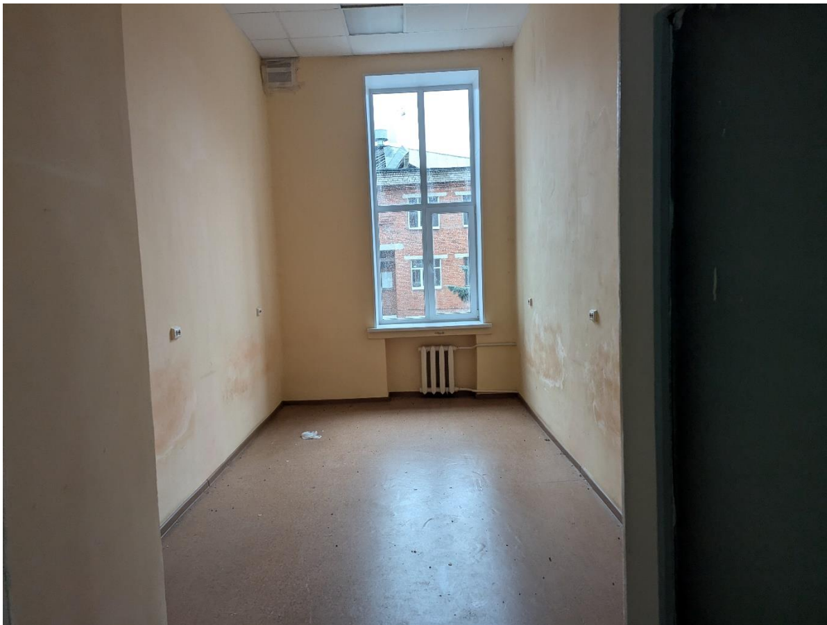
Кадр 7. Дата: 01.11.2024 г. Фото внутренних помещений, 2 этаж
