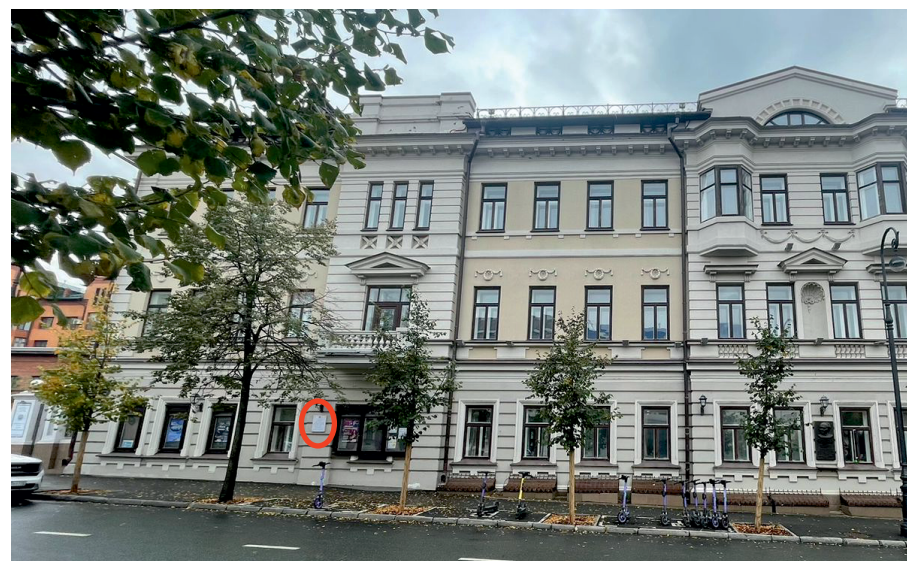
2. Вид на объект до установки информационной надписи
