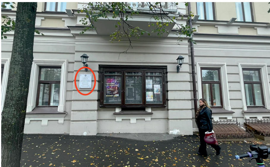
1. Вид на объект до установки информационной надписи
