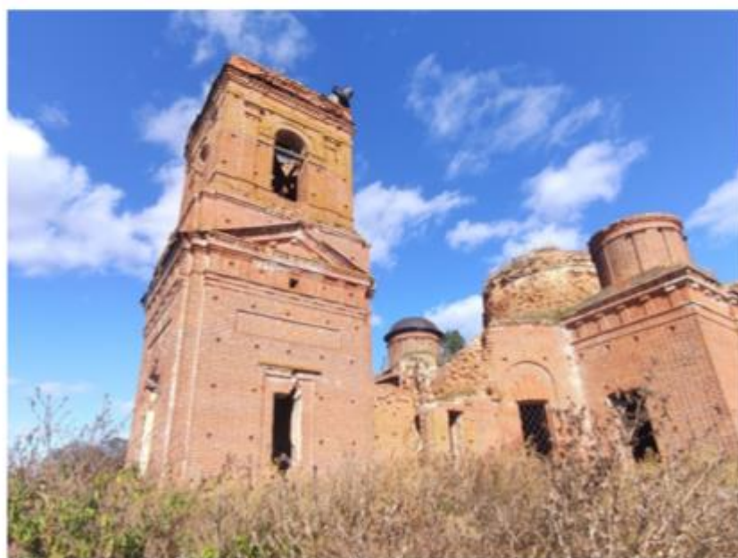
Фото 6. Общий вид на объект с юго-западной стороны
