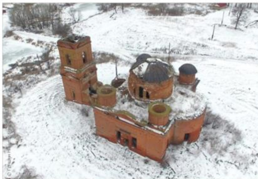
Фото 2015 года. Вид с воздуха с юго-восточной стороны.
