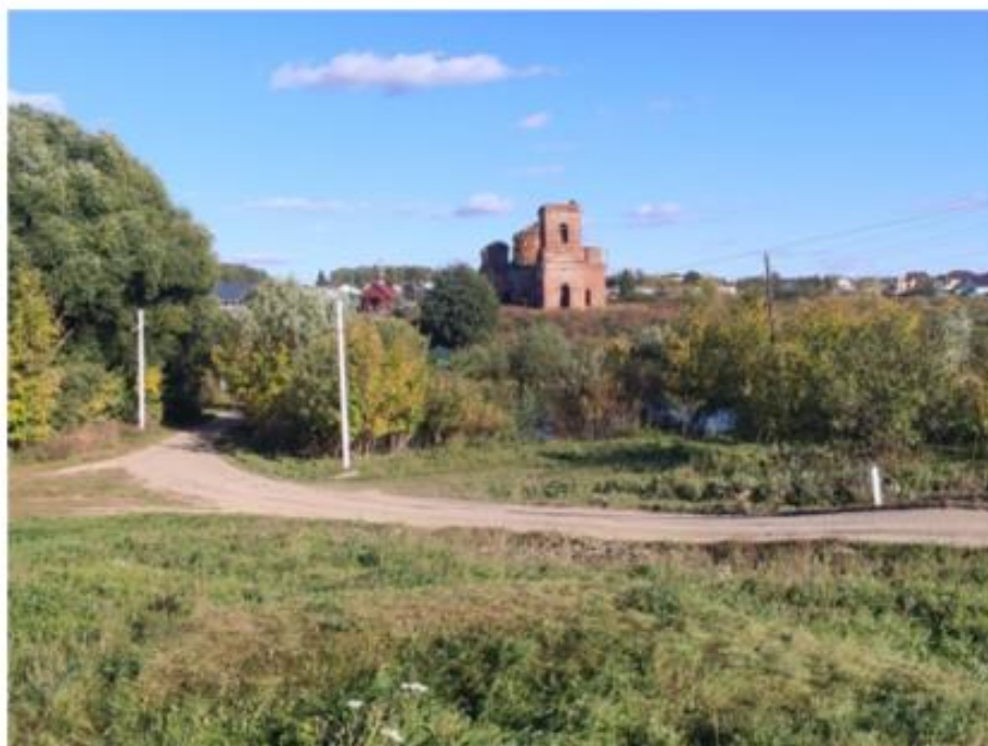
Фото 18. Общий вид на объект с северо-западной стороны (с ул. Нижняя)
