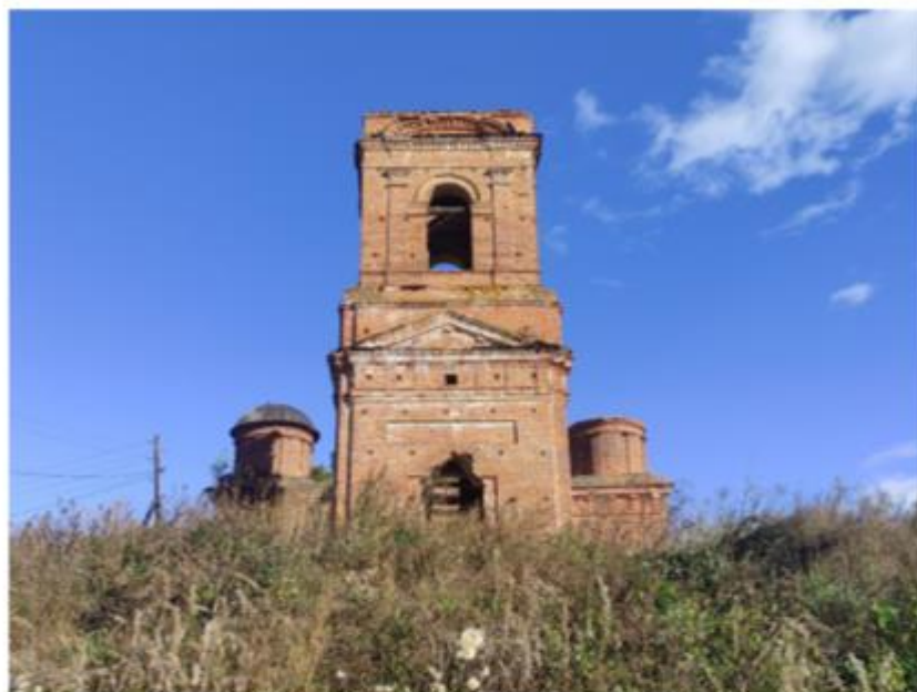
Фото 5. Общий вид на объект с западной стороны
