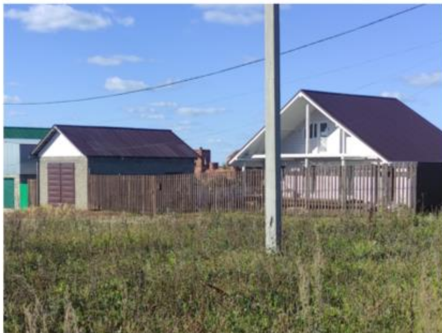
Фото 29. Общий вид на объект с юго-восточной стороны (от до.14 по ул. Школьная)
