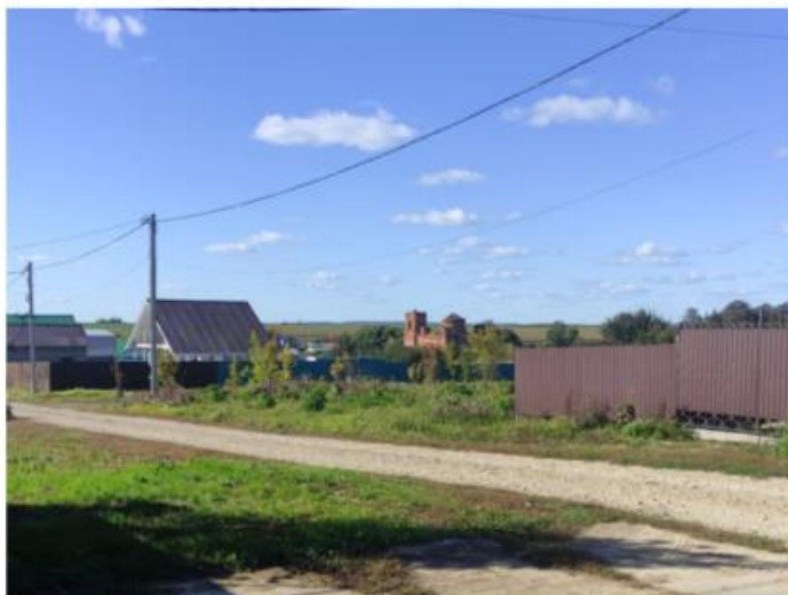
Фото 30. Общий вид на объект с юго-восточной стороны (от до.16 по ул. Школьная)
