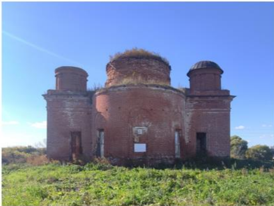
Фото 2. Общий вид на объект с восточной стороны
