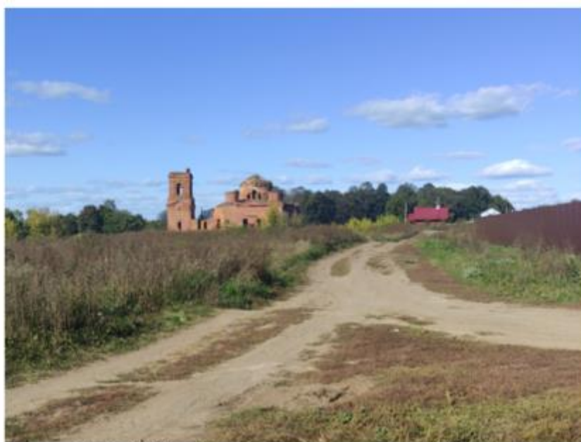
Фото 26. Общий вид на объект с юго-восточной стороны
