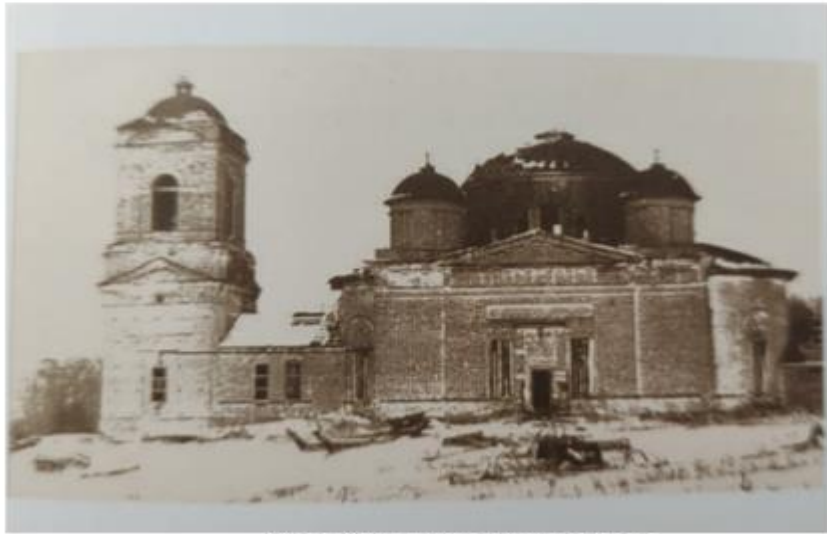
Фото 1972 г. Вид с южной стороны.
