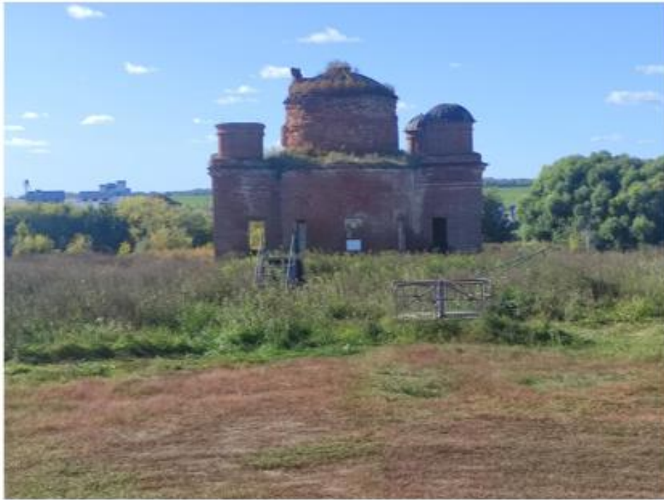
Фото 1. Общий вид на объект с восточной стороны
