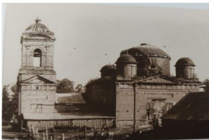
Фото 1991 г. Вид с южной стороны.
