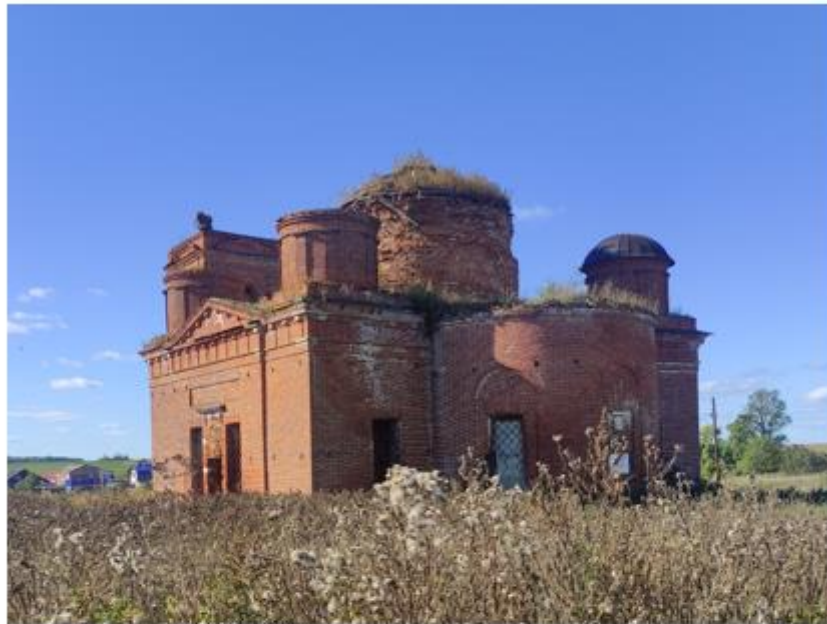
Фото 7. Общий вид на объект с юго-восточной стороны
