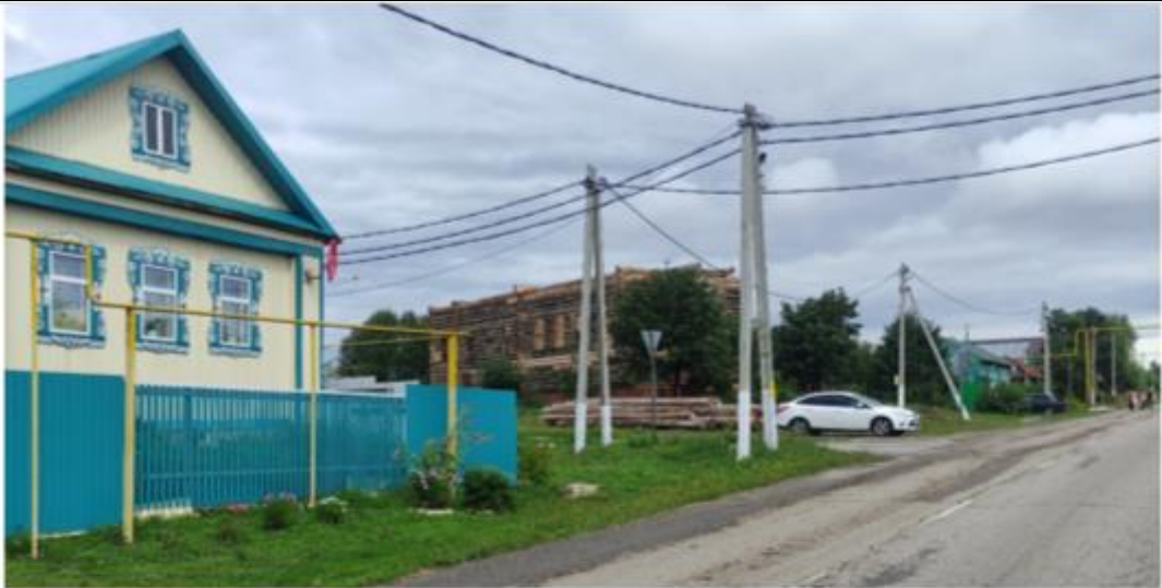
Фото 13. Общий вид на объект с юго-западной стороны.
