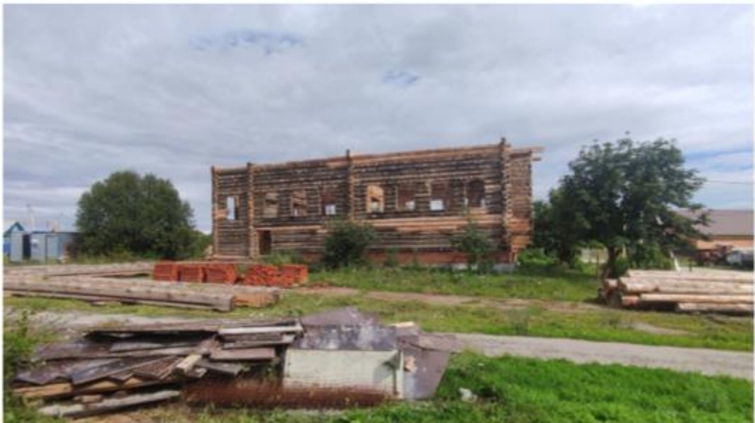
Фото 14. Общий вид на объект с западной стороны.
