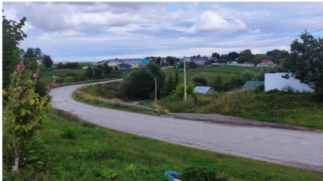
Фото 22. Общий вид на объект с юго-западной стороны.
