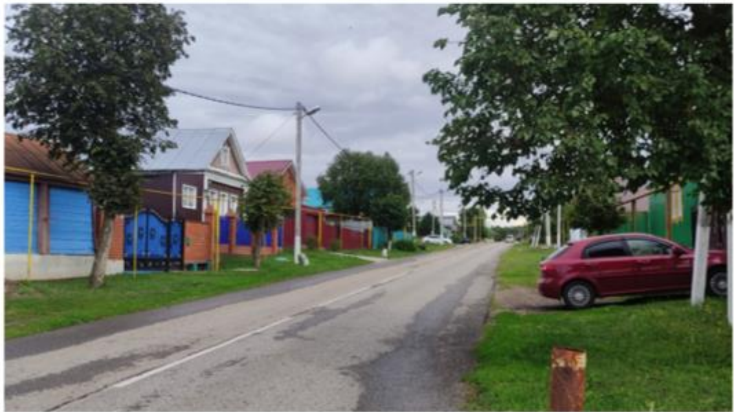
Фото 20. Общий вид на объект с юго-западной стороны.
