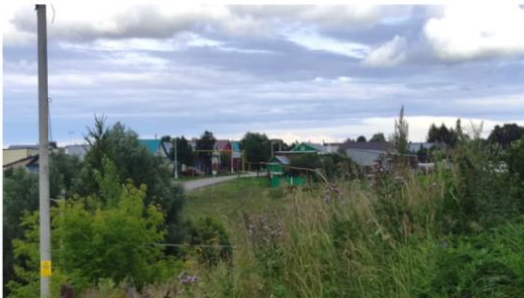
Фото 23. Общий вид на объект с юго-западной стороны.
