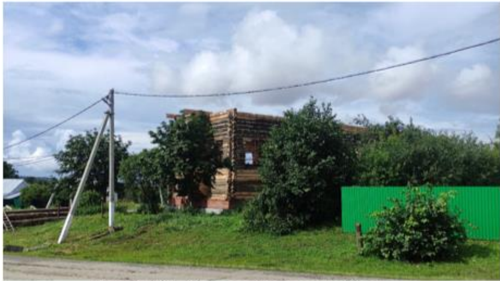
Фото 11. Общий вид на объект с южной стороны
