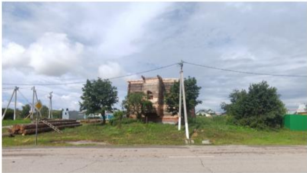
Фото 12. Общий вид на объект с южной стороны.
