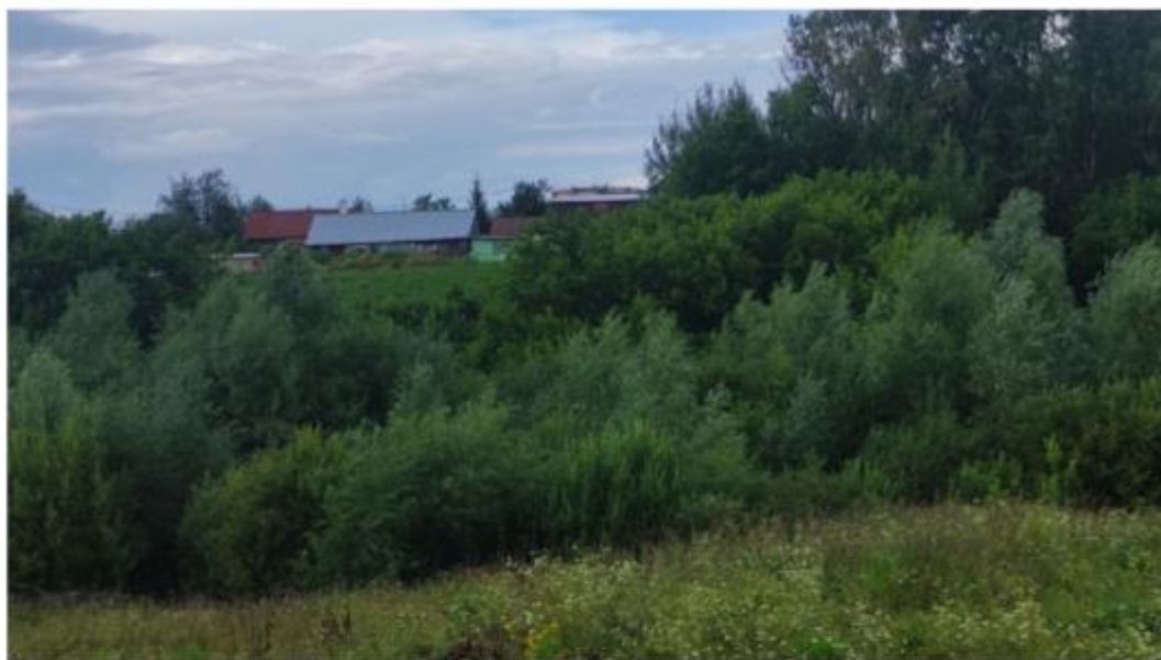
Фото 25. Общий вид на объект с южной стороны.
