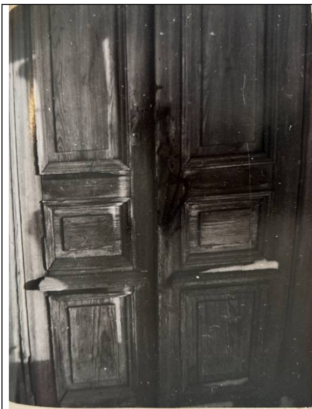
7. Дверь главного входа. Фото 1991 г.
