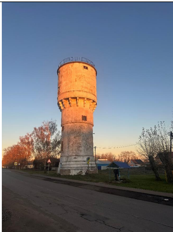
Вид с юго-западной стороны
