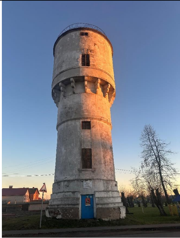
Вид с северо-западной стороны
