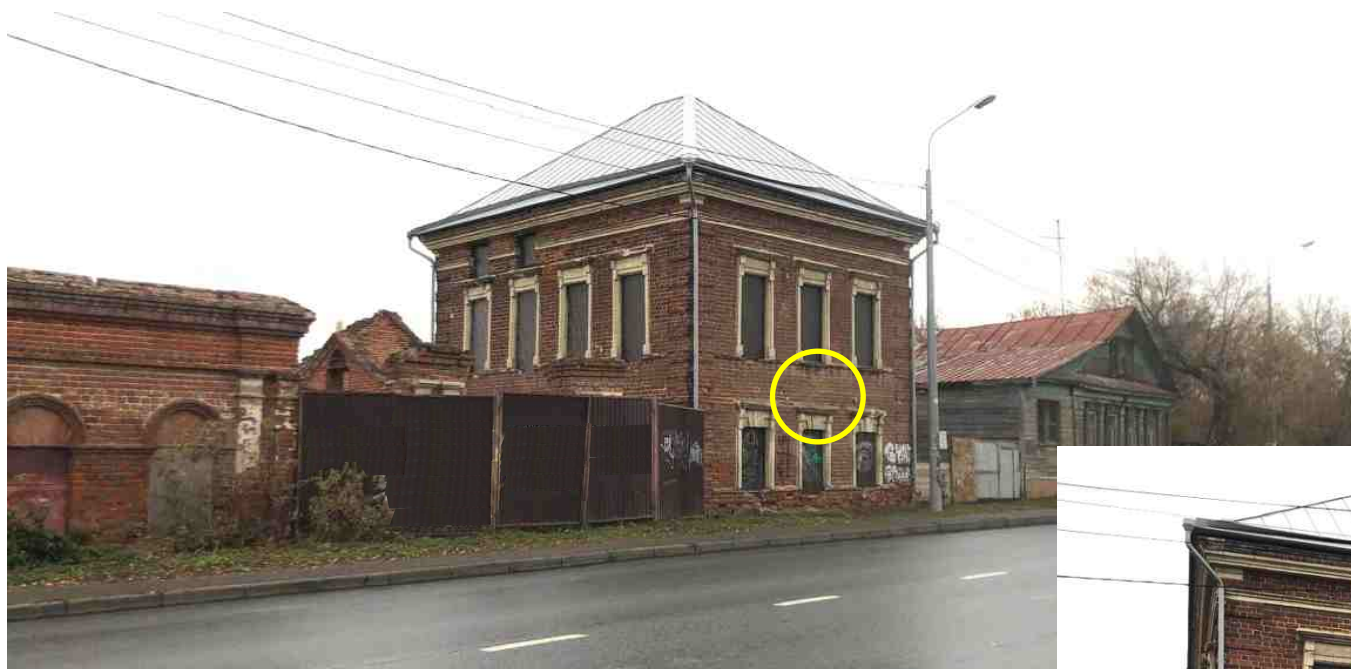
1. Вид на объект до установки информационной надписи
