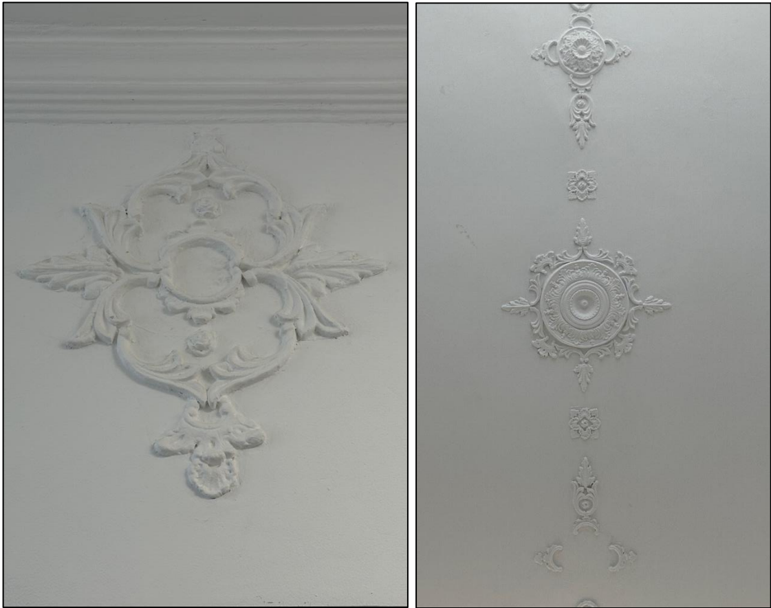
Объект экспертизы. Лепные розетки в помещении служебной лестницы (потолок и стены).
