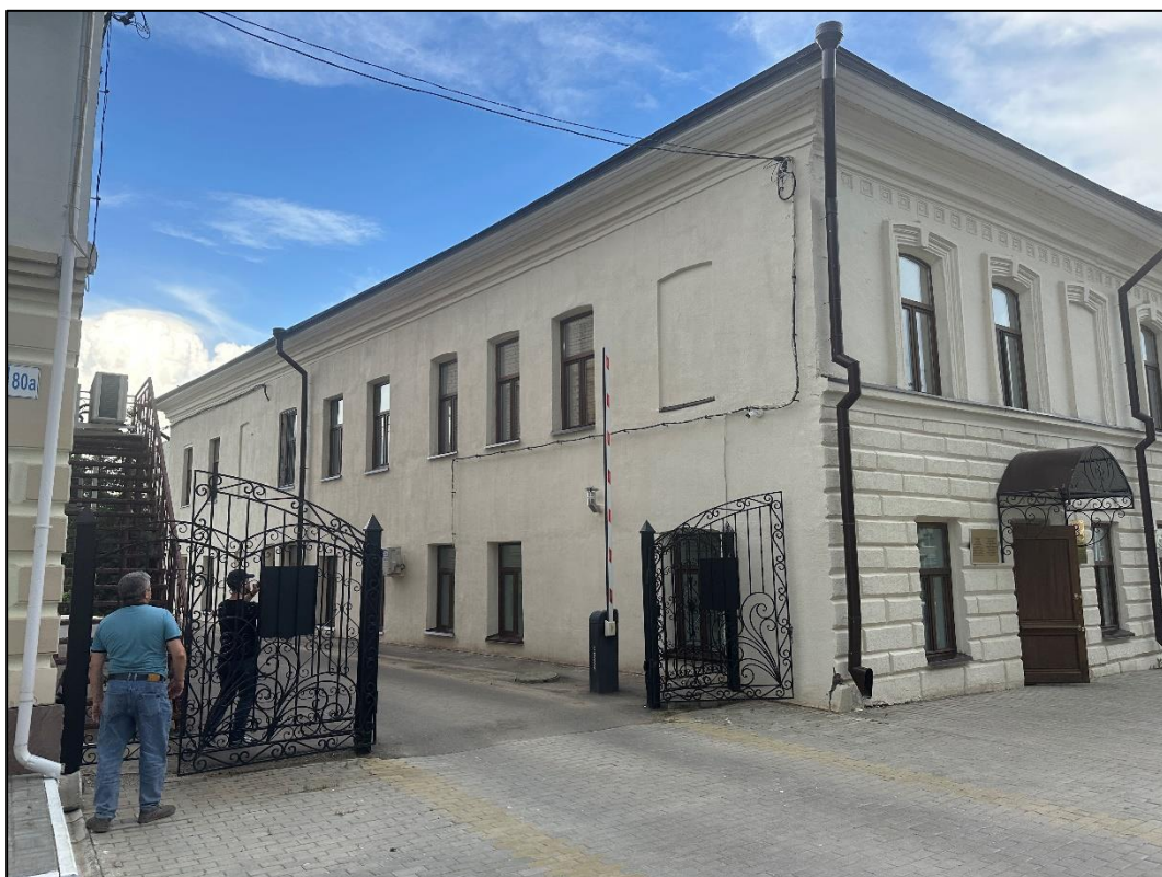
Т.ф. 5. Объект экспертизы. Объемно-пространственная композиция.
