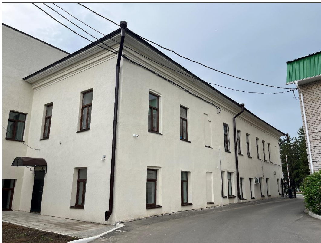
Т.ф. 5. Объект экспертизы. Дворовой фасад.
