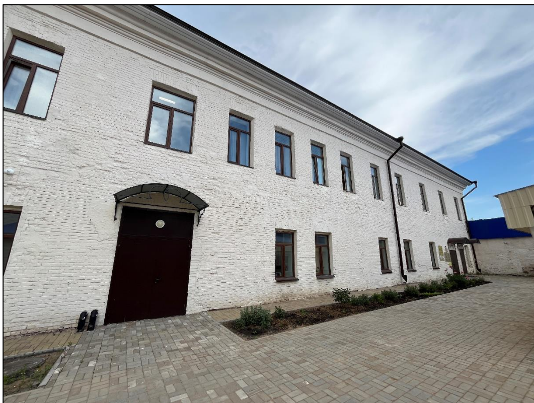
Т.ф. 4. Объект экспертизы. Дворовый фасад.
