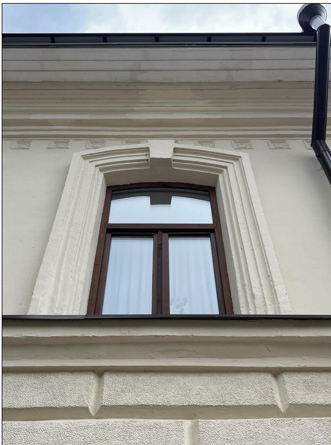
Т.ф. 1. Объект экспертизы. Оконный проем второго этажа с лучковым очертанием, тянутые наличники с замковым камнем.
