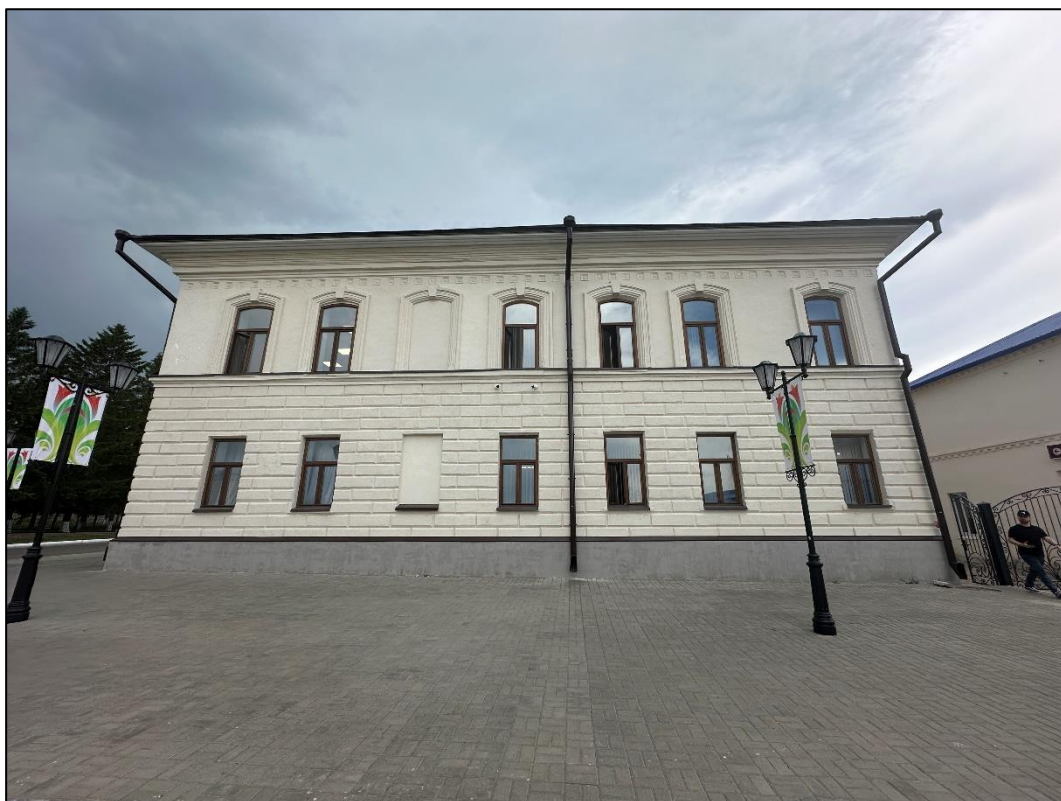
Т.ф. 2. Объект экспертизы. Общий вид со стороны улицы Габдуллы Тукая.
