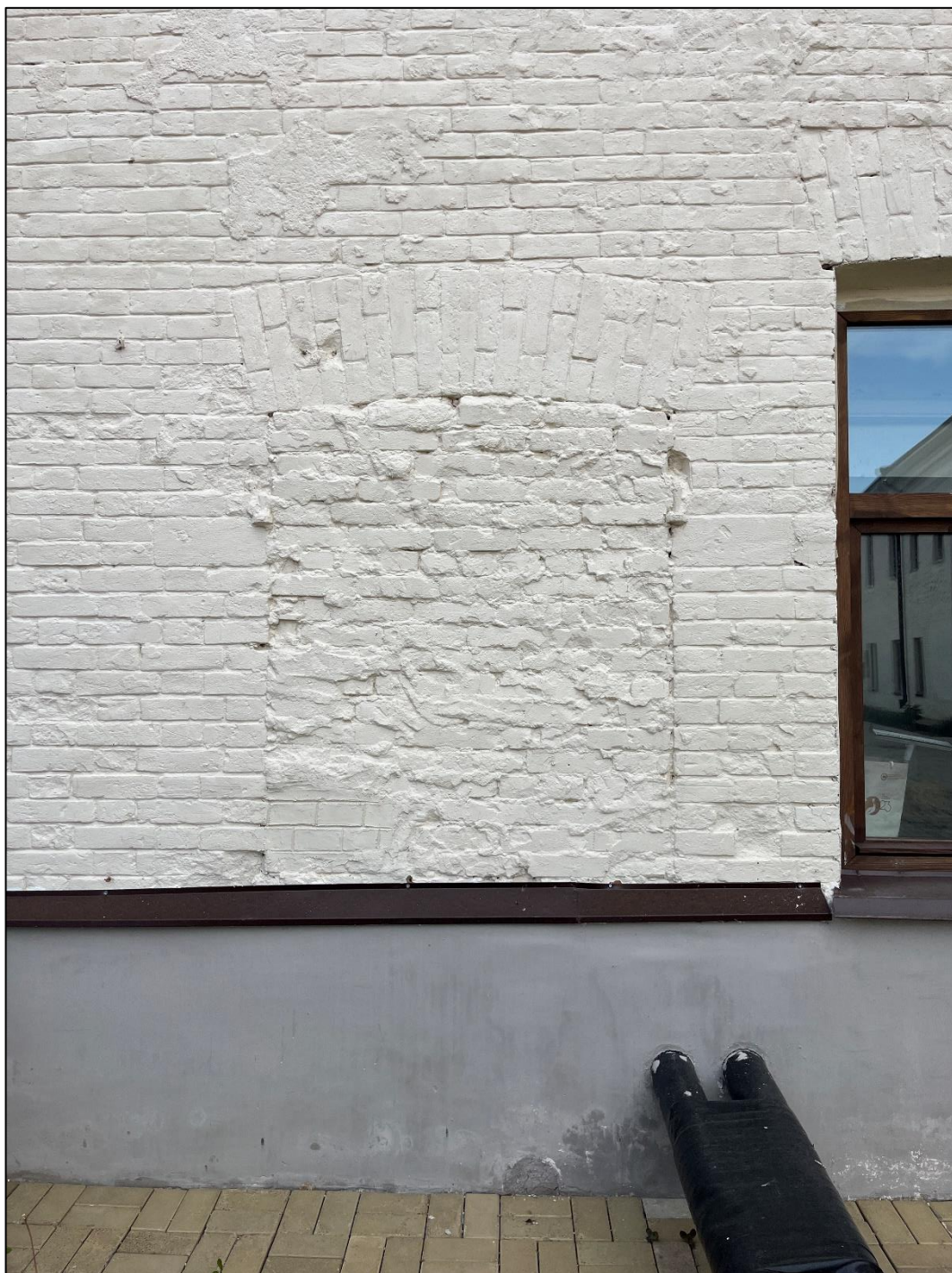
Т.ф. 3. Объект экспертизы. Фактура отделки фасадов (окраска по кирпичной кладке), поздние поновления.
