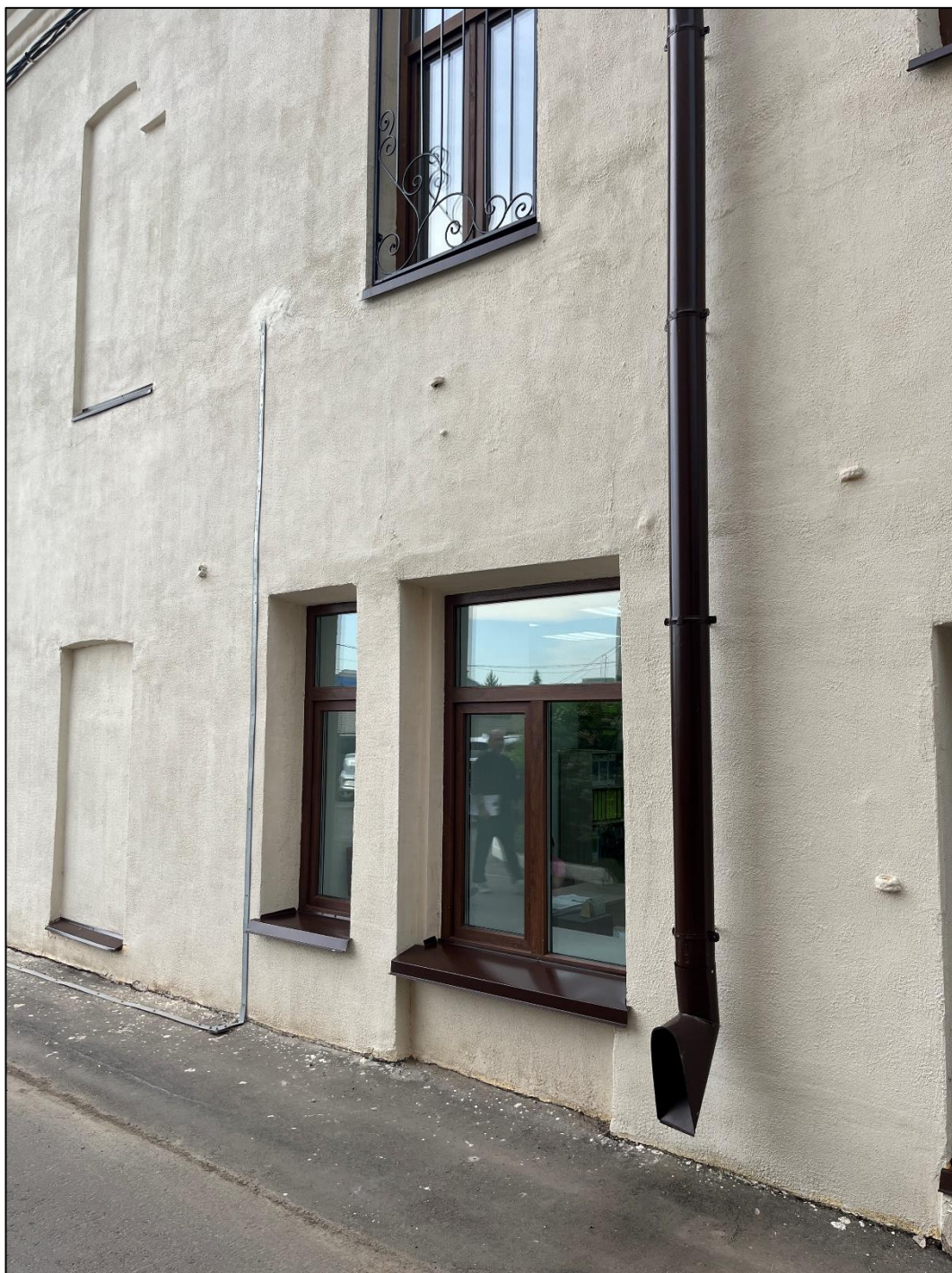
Т.ф. 5. Объект экспертизы. Ритм окон дворового фасада, различие конфигурации объемов, что указывает на разновременность сооружений.
