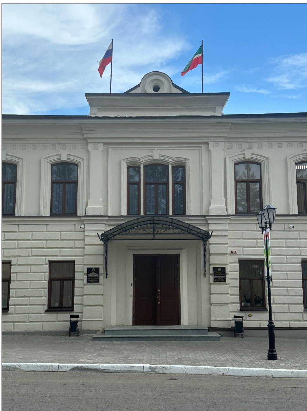
Т.ф. 1. Объект экспертизы. Входная группа (ризалит). Тройной оконный проем второго этажа с замковым камнем. Венчающий карниз. Рустованные пилястры, аттик.
