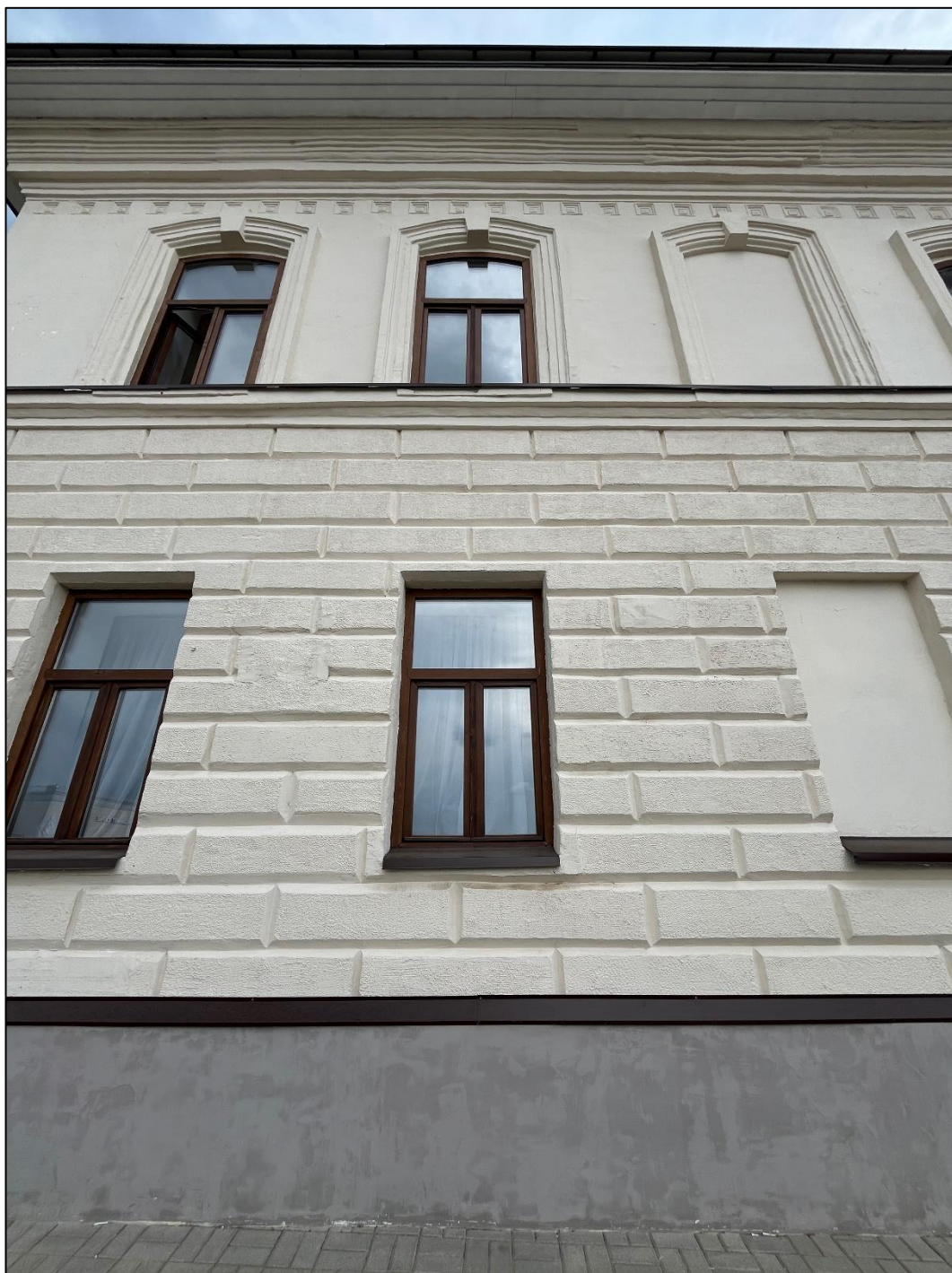
Т.ф. 2. Объект экспертизы. Общий вид со стороны улицы Габдуллы Тукая. Ритм оконных проемов, фактура отделки фасадов. Венчающий карниз (профилировка). Рустовка фасада первого этажа.
