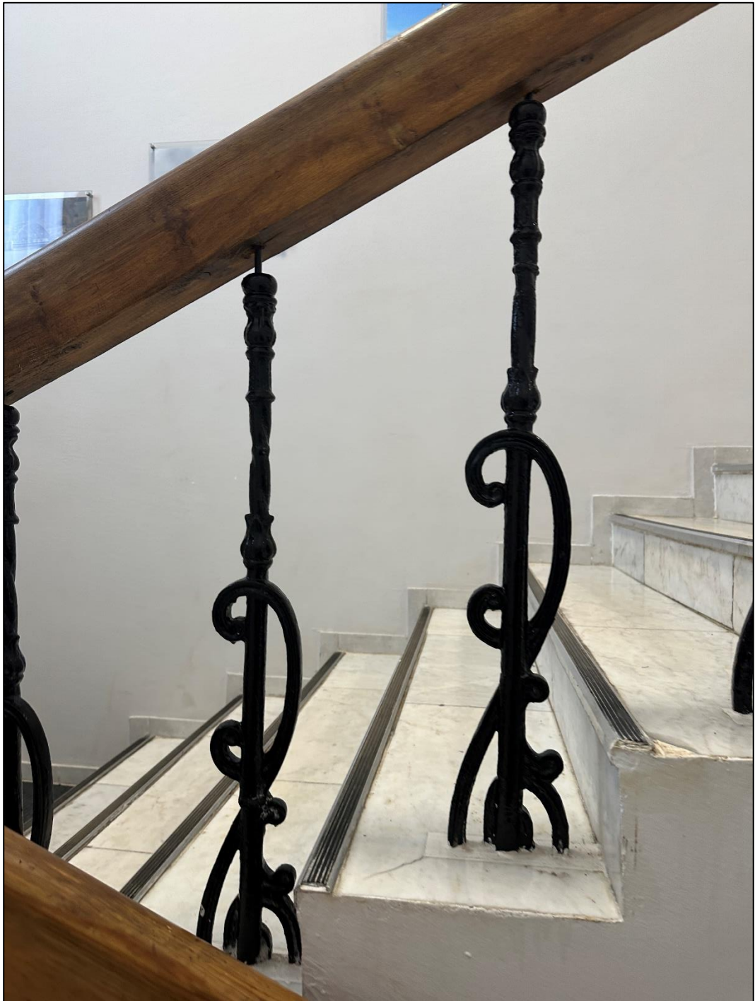
Объект экспертизы. Современное состояние интерьера. Межэтажная лестница, подлинные ограждения их художественного металла.
