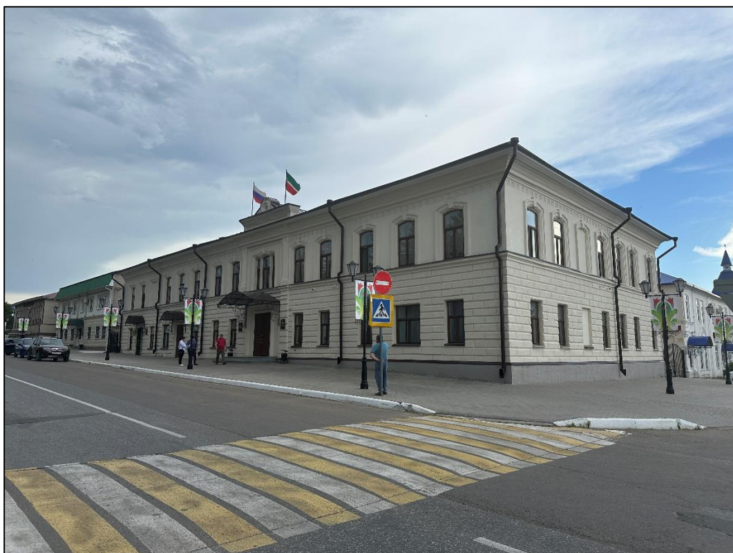
Т.ф. 1. Объект экспертизы. Объемно-пространственная композиция
