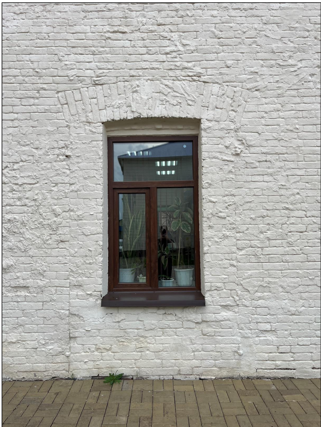
Т.ф. 4. Объект экспертизы. Оконный проем первого этажа с лучковой перемычкой на месте прежнего дверного проема.
