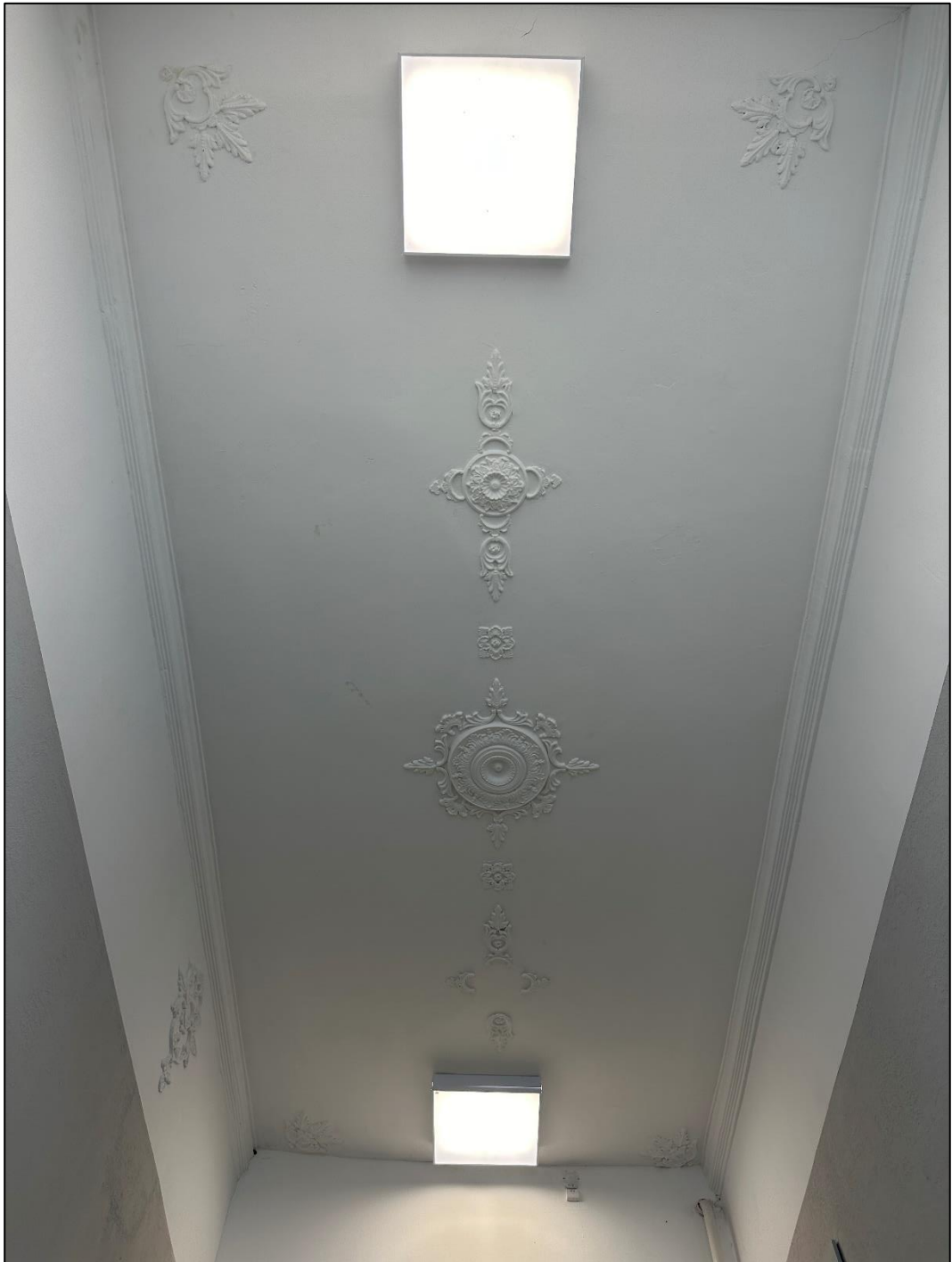
Объект экспертизы. Лепные розетки в помещении служебной лестницы.
