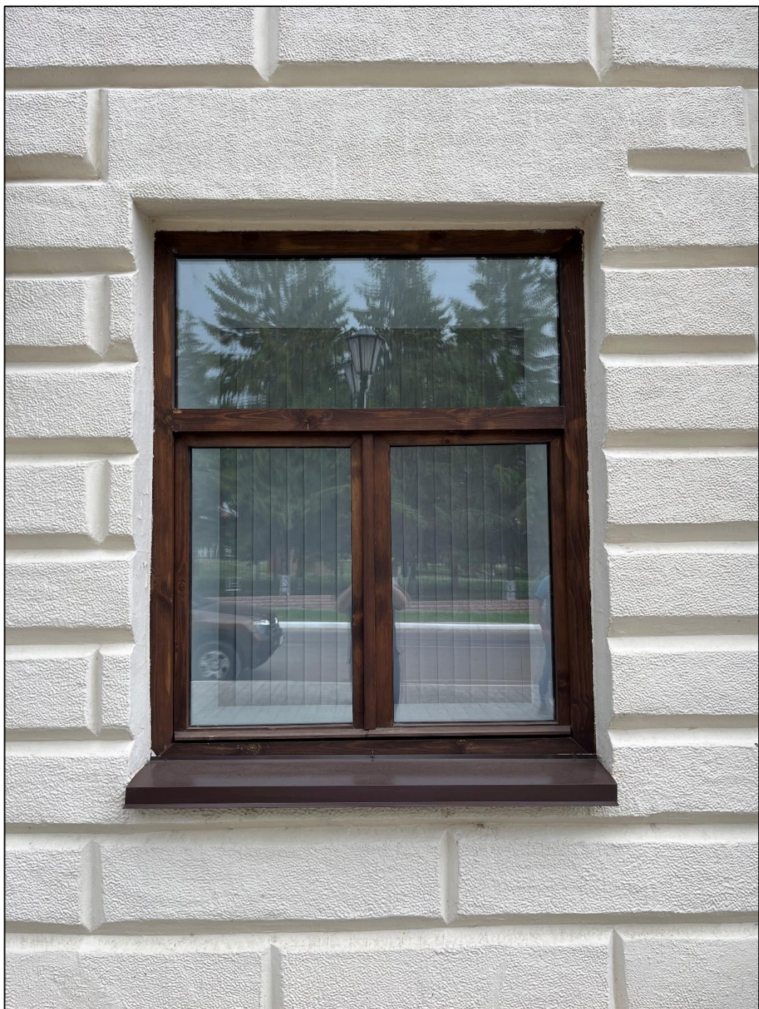
Т.ф. 1. Объект экспертизы. Конфигурация оконного проема первого этажа, рустика (вразбежку).
