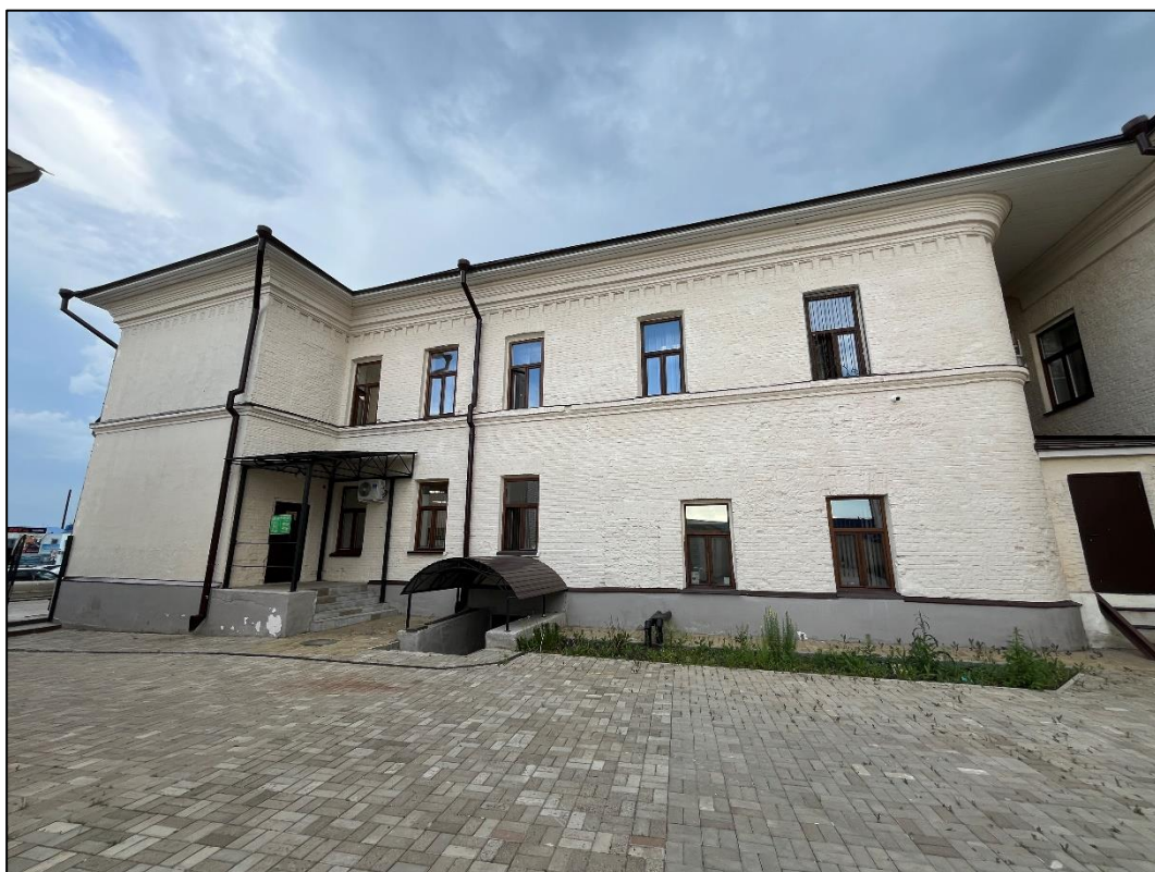
Т.ф. 3. Объект экспертизы. Общий вид со двора.
