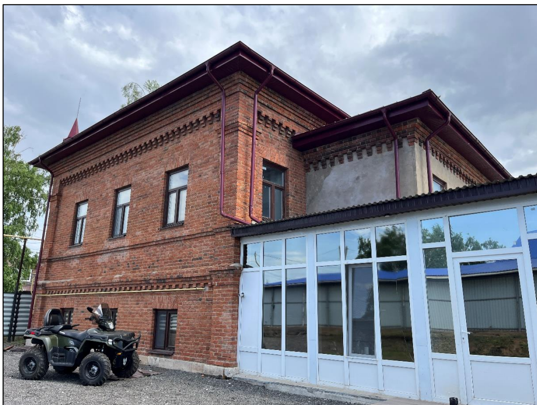
Т.ф. 3. Объект экспертизы. Дворовый фасад.
