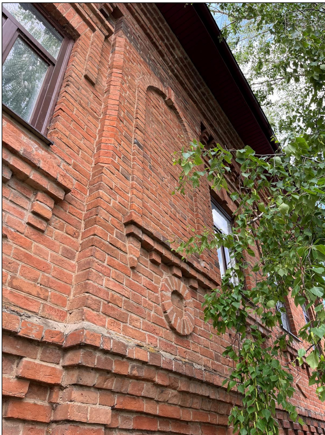
Т.ф. 1. Объект экспертизы. Ризалит, ниши с арочным обрамлением (ложные окна) и замковым камнем, межэтажный карниз, круглая филенка.
