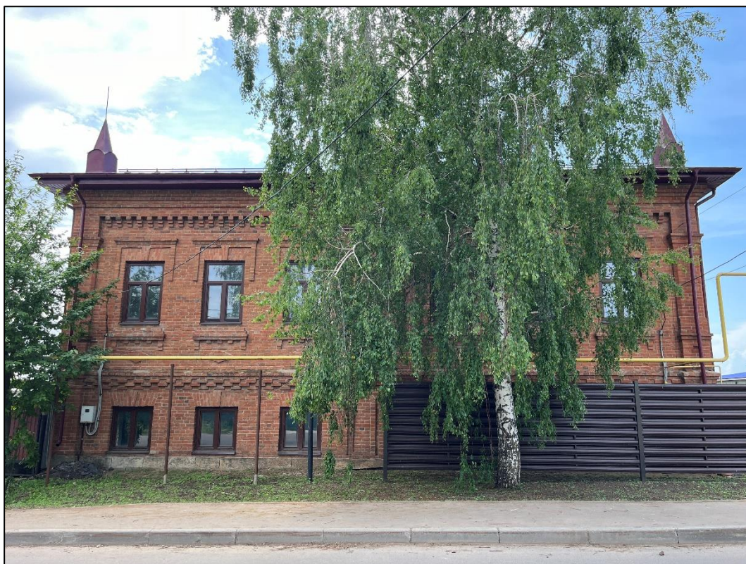
Т.ф. 1. Объект экспертизы. Общий вид со стороны улицы Ленина (главный фасад).
