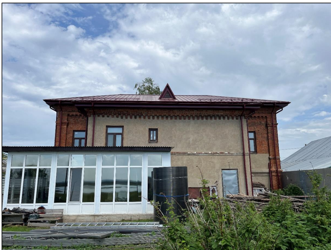
Т.ф. 4. Объект экспертизы. Дворовый фасад.
