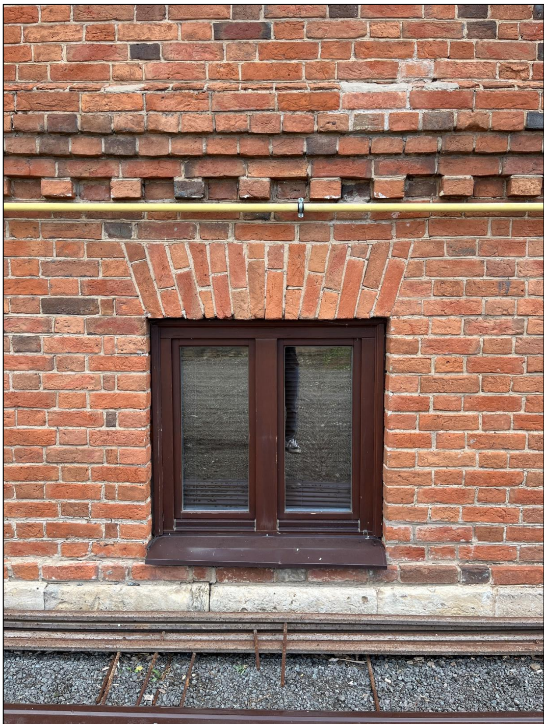
Т.ф. 3. Объект экспертизы. Оконный проем с клинчатой перемычкой и замковым камнем. Межэтажный карниз с сухариками, белокаменный цоколь.
