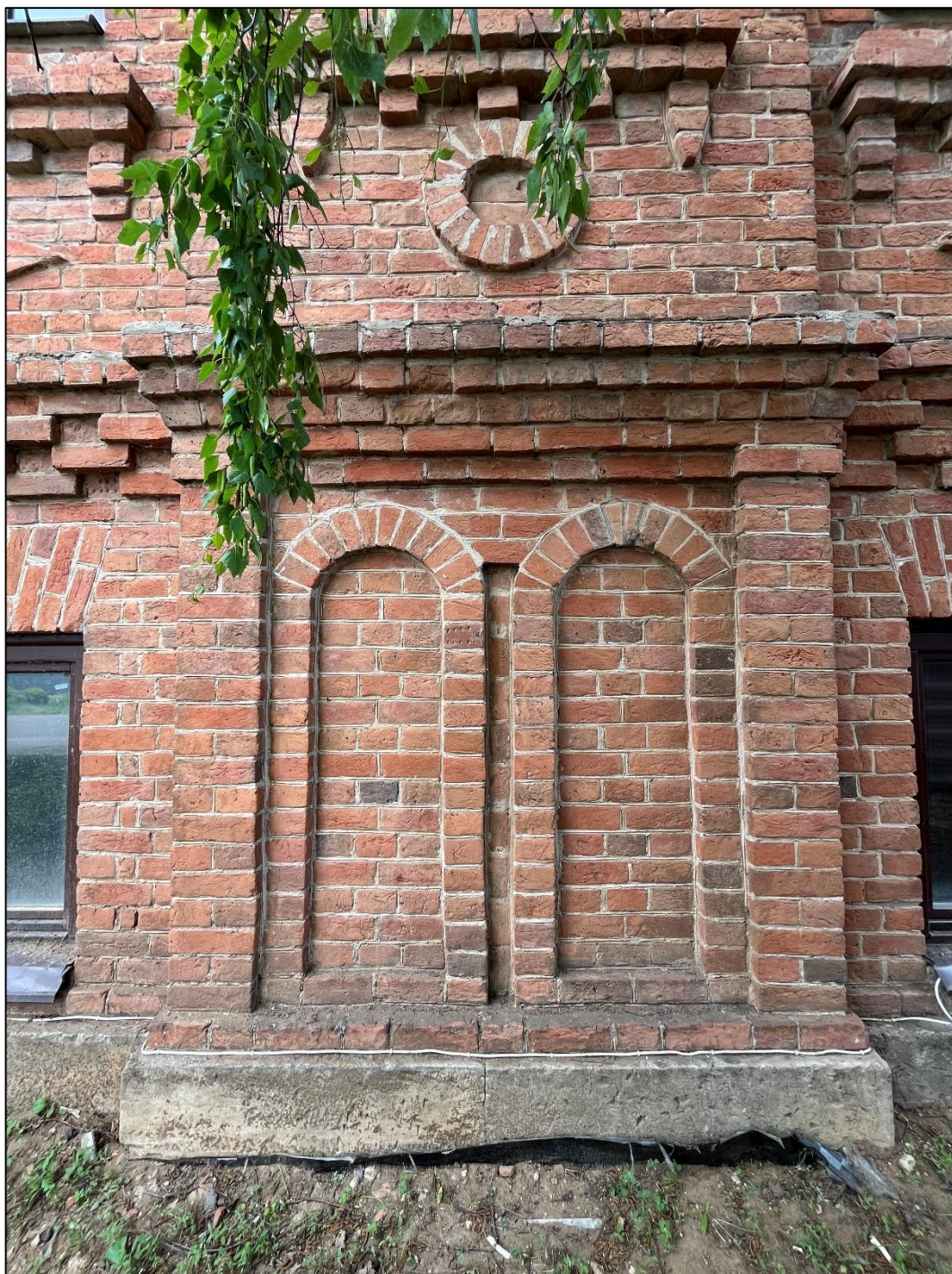
Т.ф. 1. Объект экспертизы. Ризалит, ниши с арочным обрамлением (ложные оконные проемы), межэтажный карниз.
