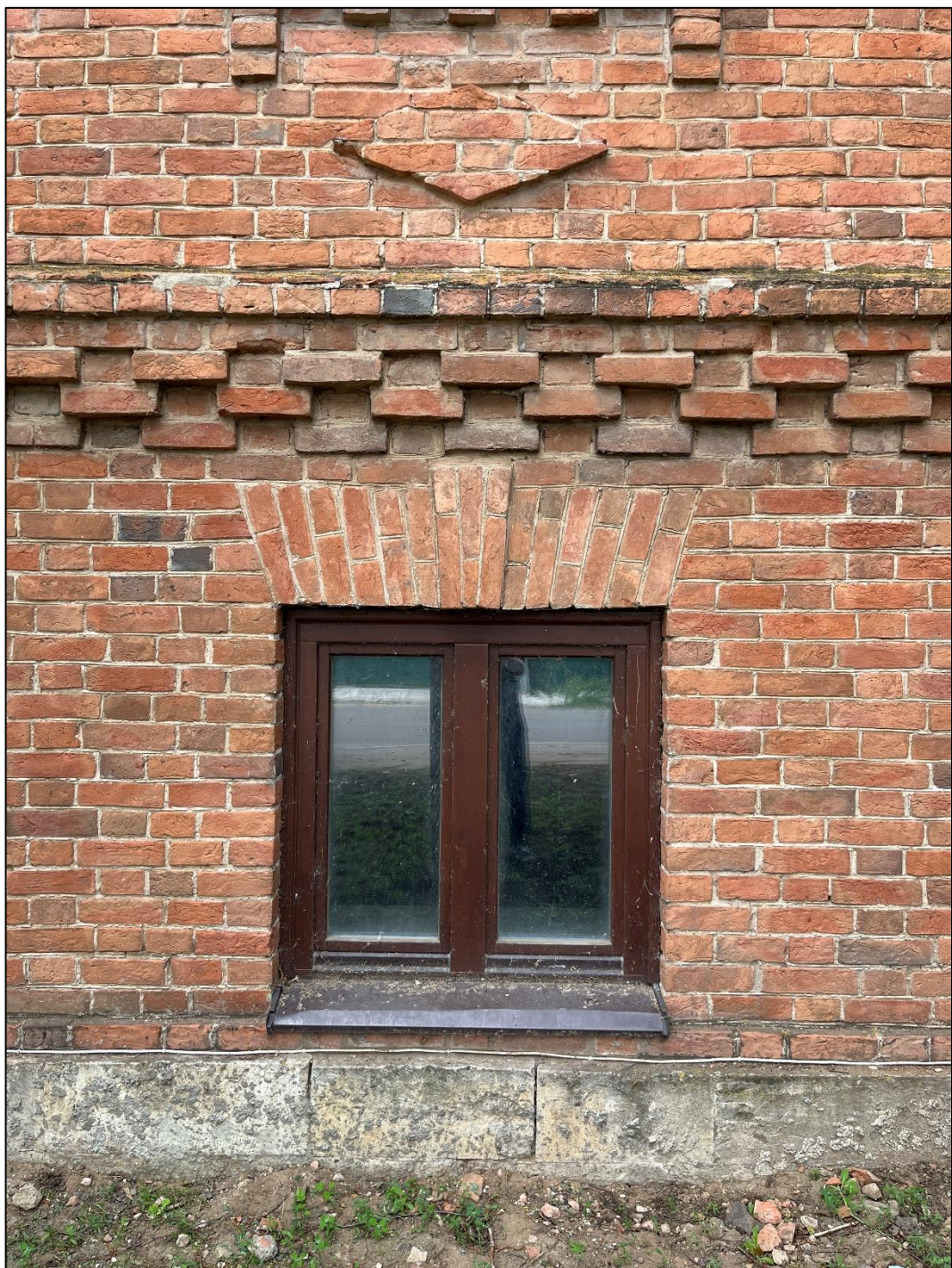
Т.ф. 1. Объект экспертизы. Оконный проем с клинчатой перемычкой и замковым камнем, межэтажный пояс, белокаменный цоколь.
