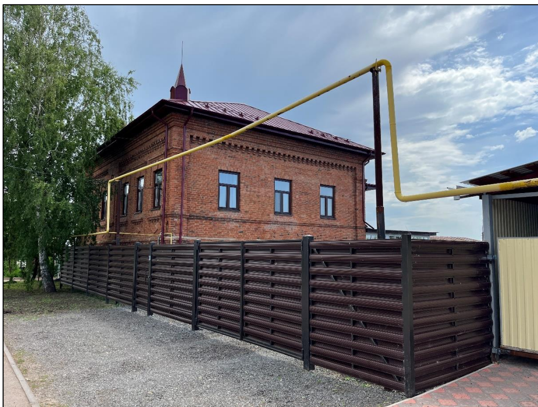
Т.ф. 2. Объект экспертизы. Общий вид со стороны ул. Ленина.
