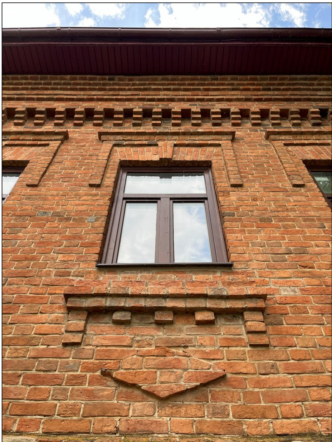
Т.ф. 1. Объект экспертизы. Оконный проем с клинчатой перемычкой и замковым камнем, подоконной полочкой с сухариками и на консолях, ромбовидная филенка, сандрик с карнизиком и сережками, венчающий карниз с консолями.
