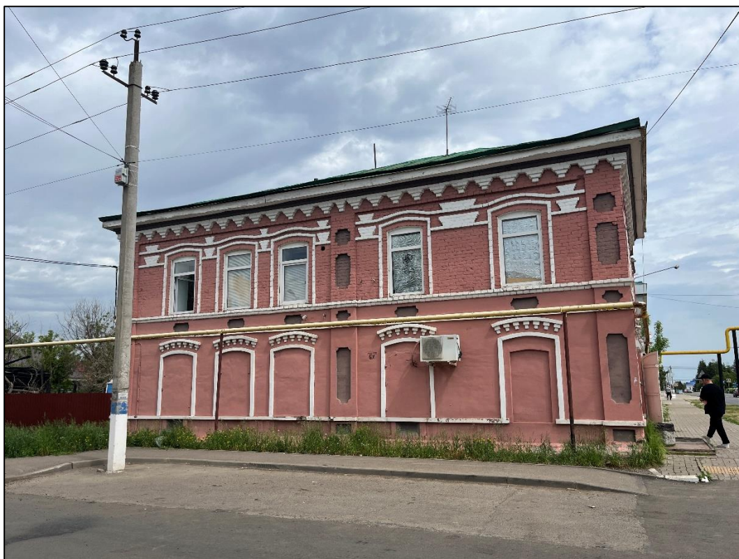
Т.ф. 4. Объект экспертизы. Общий вид со стороны улицы Красноармейская.
