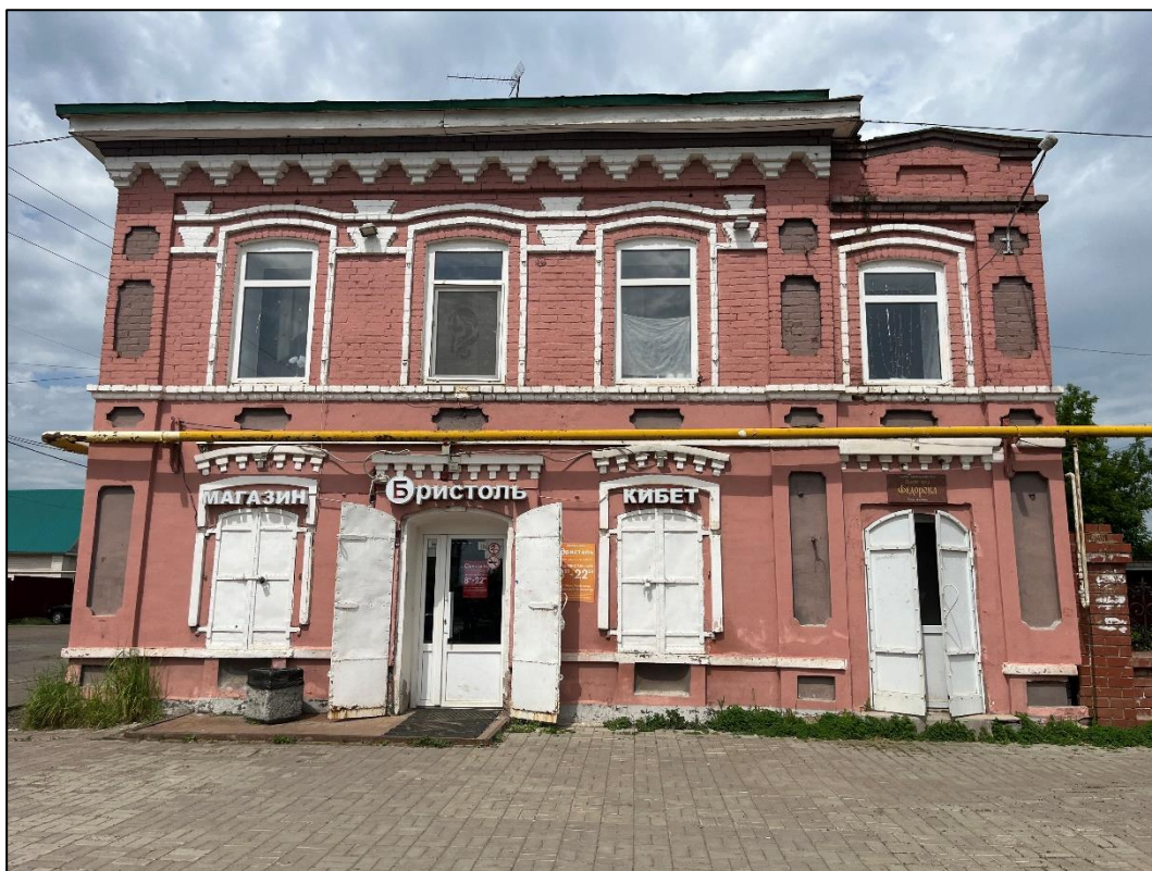
Т.ф. 2. Объект экспертизы. Главный фасад со стороны улицы Карла Маркса.
