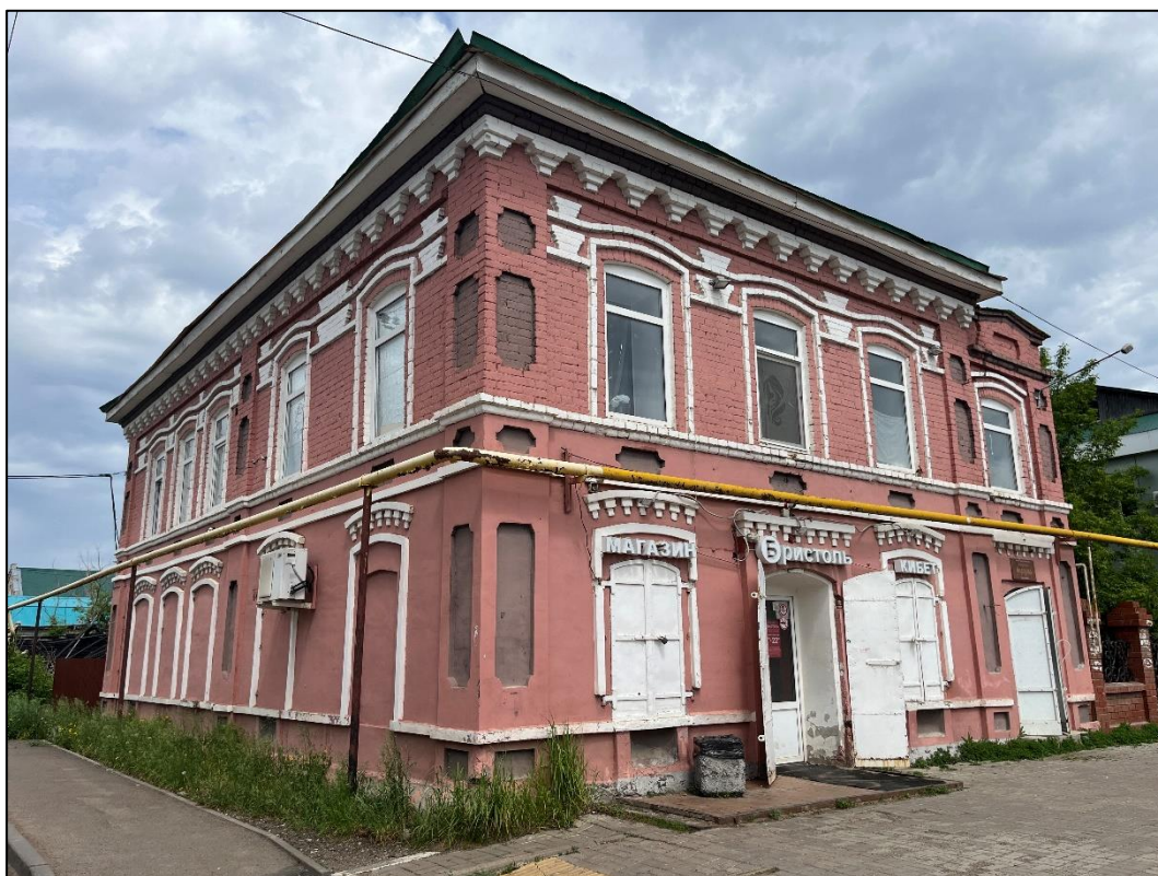
Т.ф. 1. Объект экспертизы. Объемно-пространственная композиция
