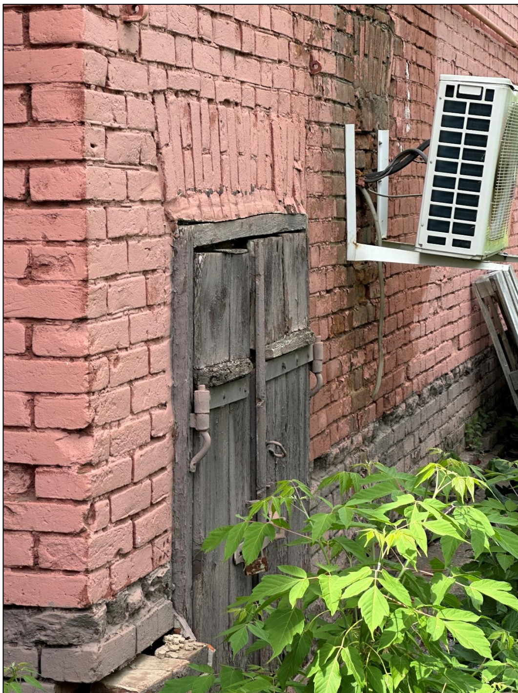
Т.ф. 3. Объект экспертизы. Дверной проем с лучковой перемычкой бокового фасада, металлические кованые изделия: опоры (кулаки), навески и ручки.
