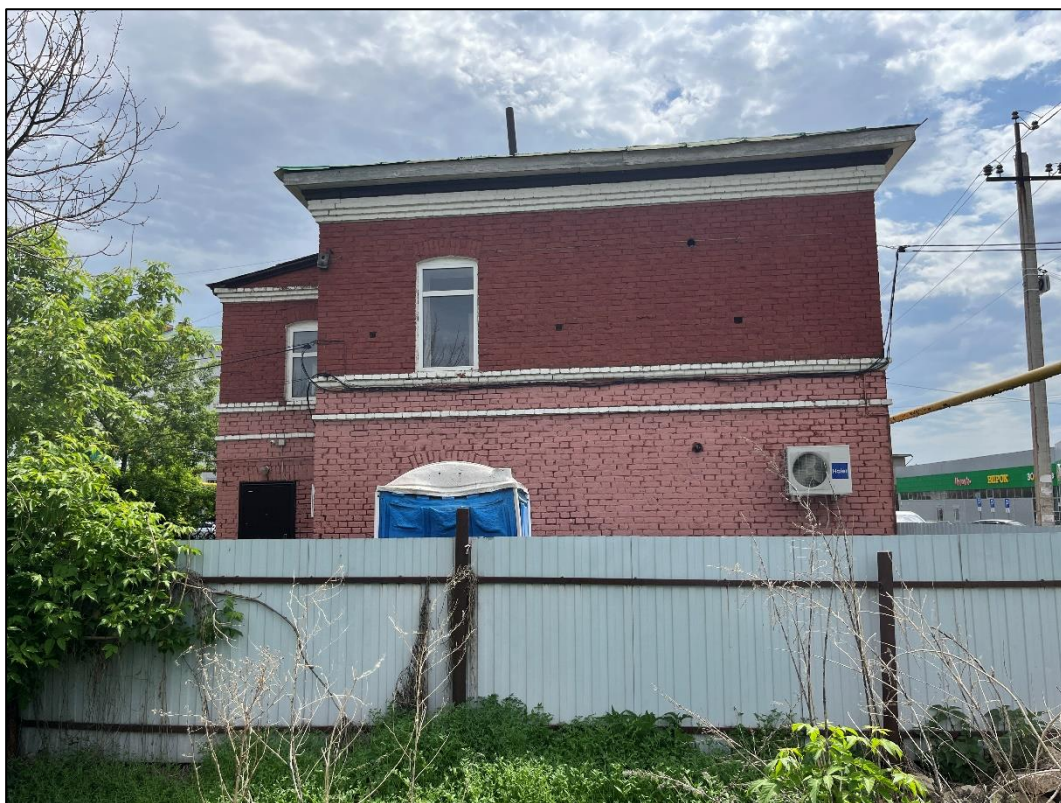
Т.ф. 5. Объект экспертизы. Дворовой фасад.
