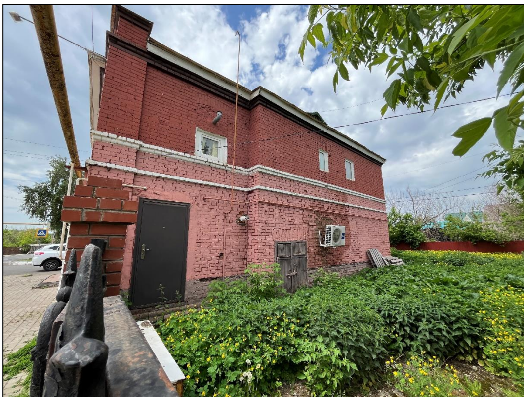
Т.ф. 3. Объект экспертизы. Боковой фасад.
