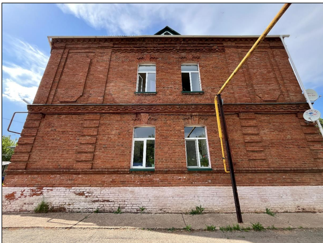
Т.ф. 3. Объект экспертизы. Боковой фасад
