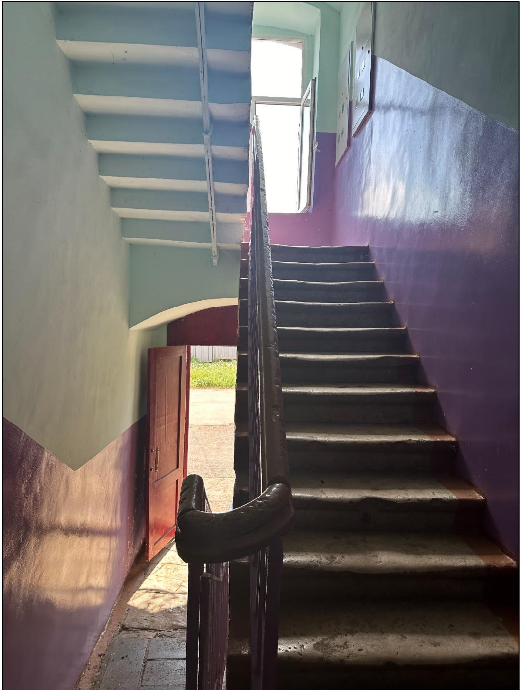
Объект экспертизы. Каменная четырехмаршевая лестница с металлическими воздушными связями.
