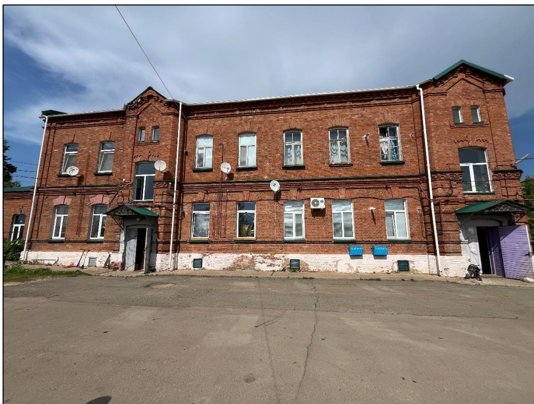
Т.ф. 4. Объект экспертизы. Дворовой фасад, эркеры входов
