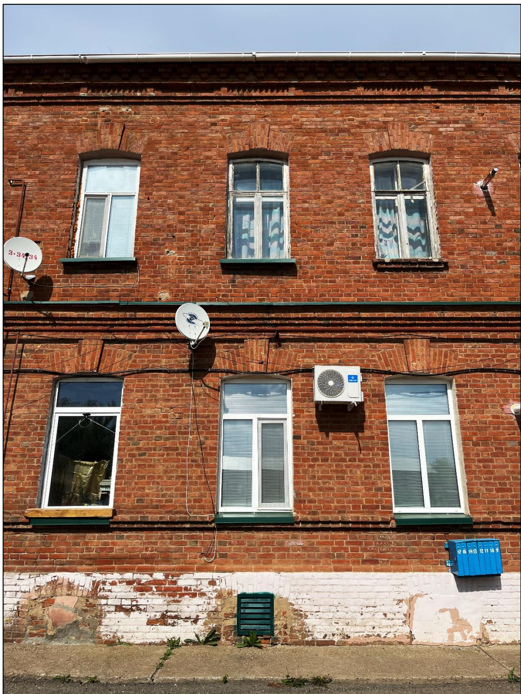
Т.ф. 4. Объект экспертизы. Центральная часть дворового фасада
