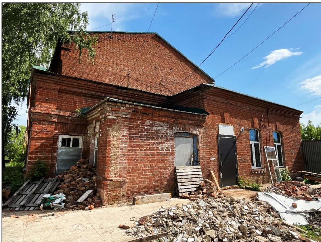
Т.ф. 5. Объект экспертизы. Боковой фасад флигеля и северный фасад основного объема
