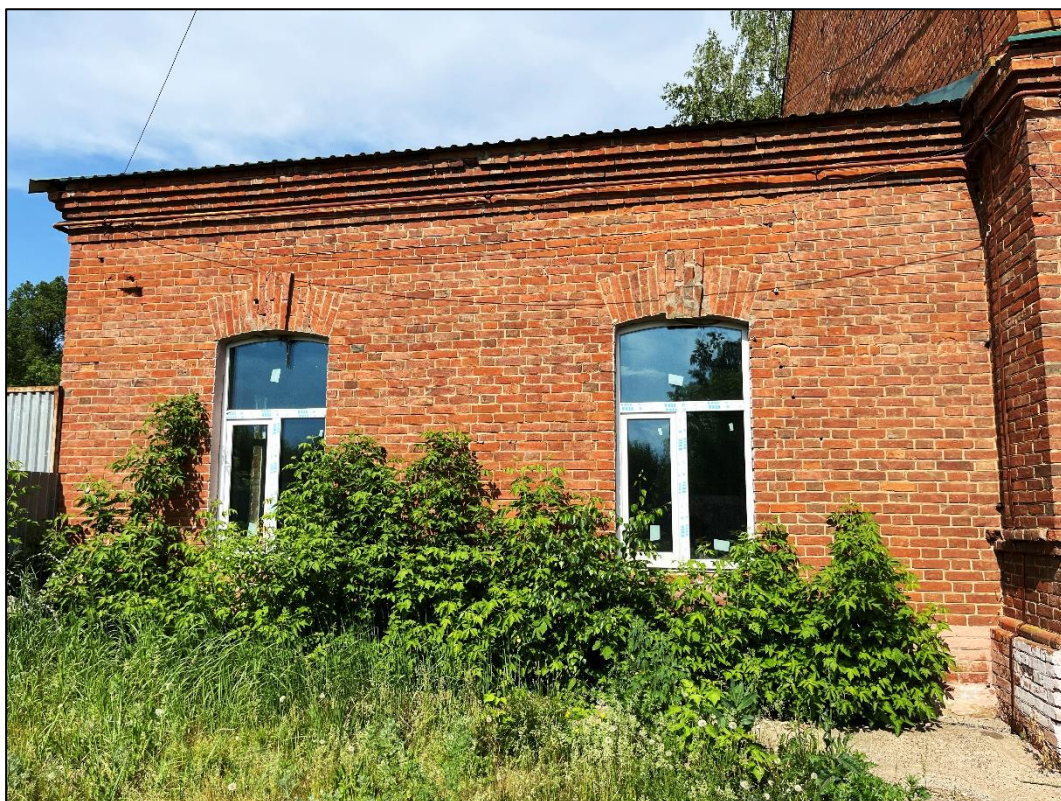
Т.ф. 4. Объект экспертизы. Дворовой фасад флигеля
