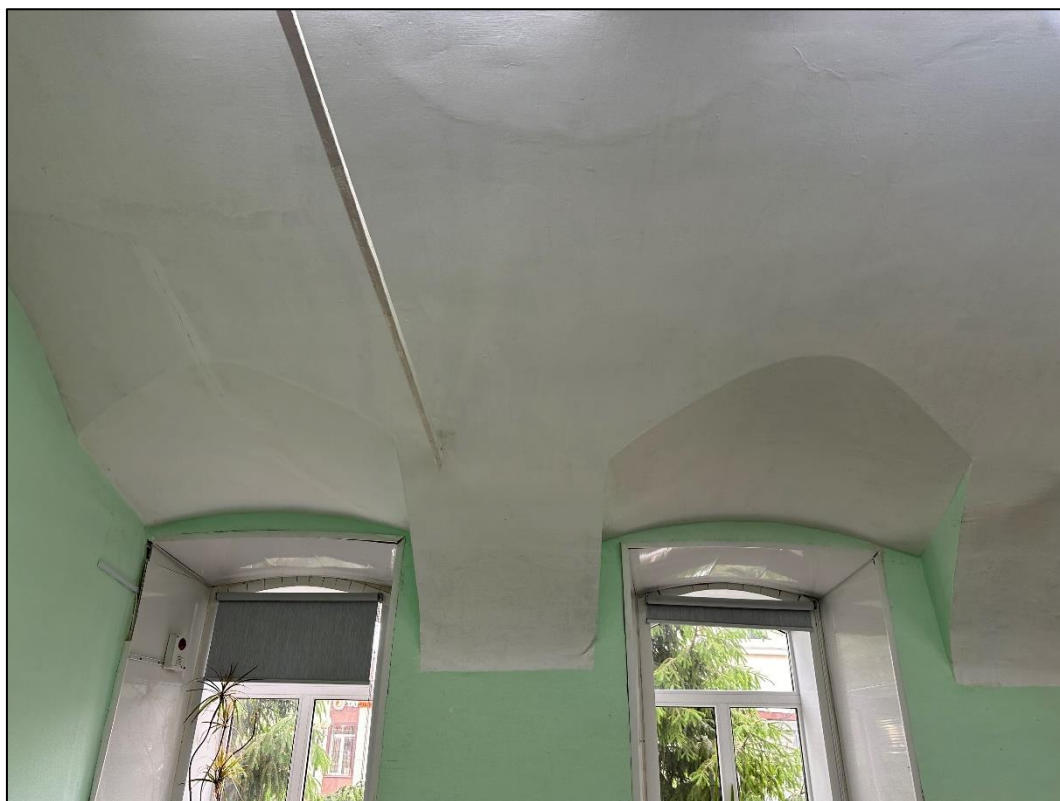
Объект экспертизы. Система сводчатых перекрытий с распалубками.
