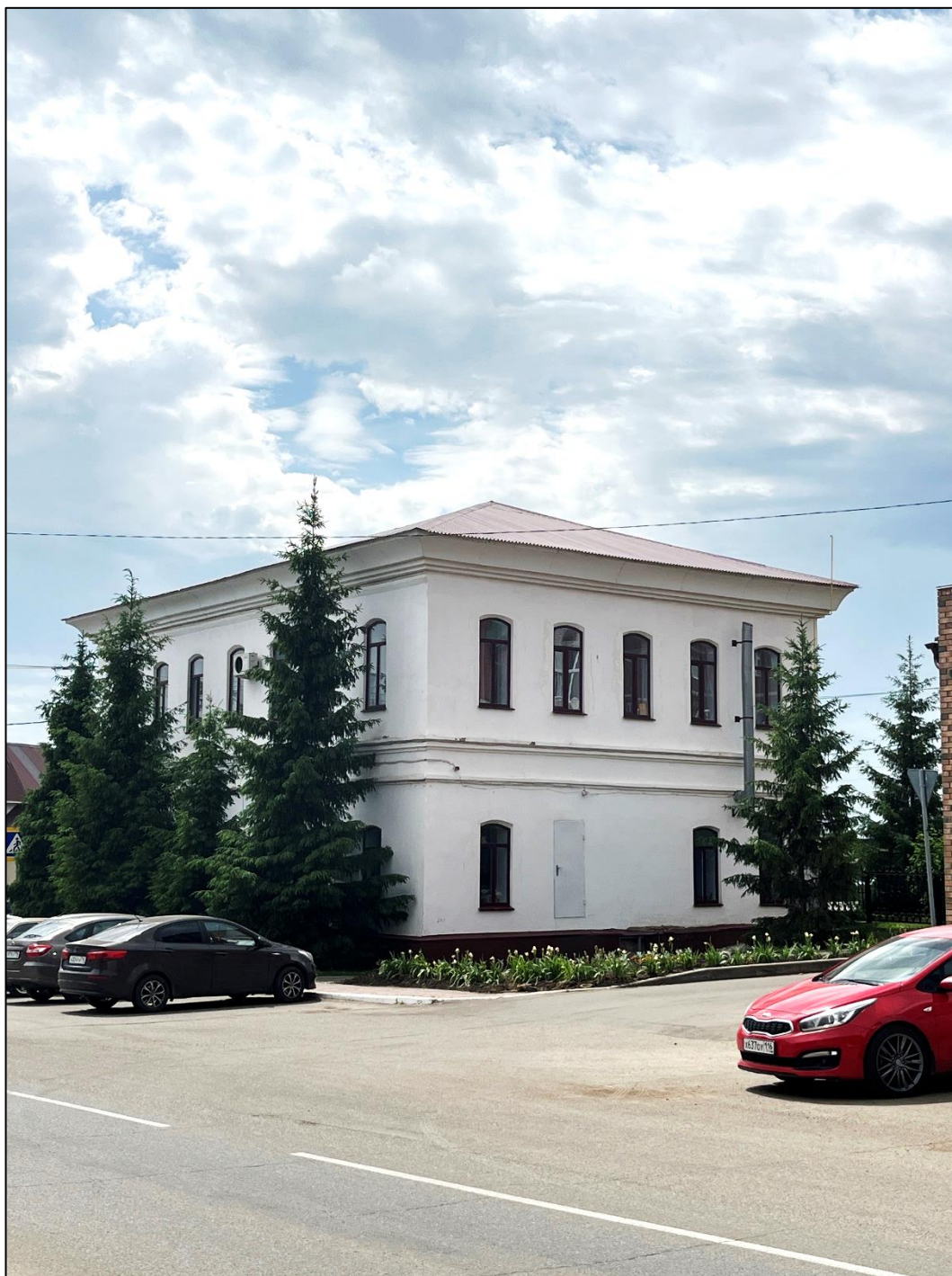
Т.ф. 1. Объект экспертизы. Общий вид со стороны улицы Мусы Джалиля.
