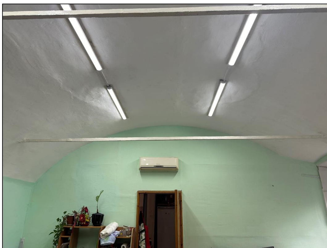
Объект экспертизы. Система сводчатых перекрытий.
