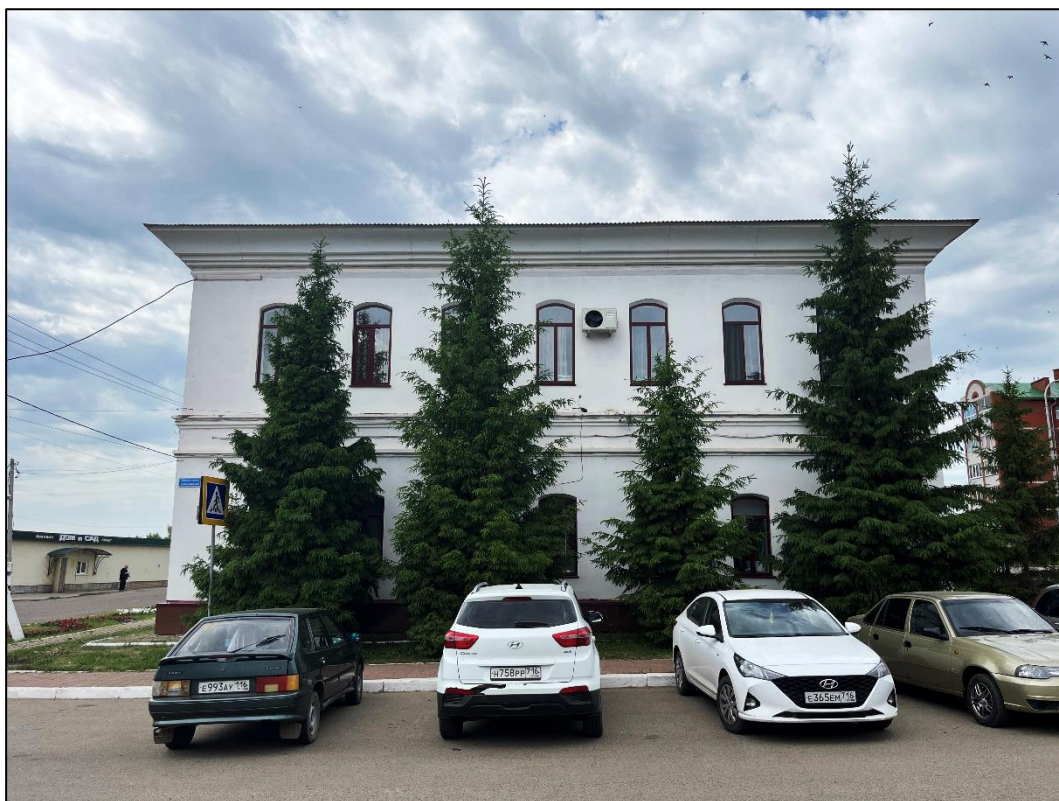
Т.ф. 2. Объект экспертизы. Общий вид со стороны улицы Мусы Джалиля (главный фасад).
