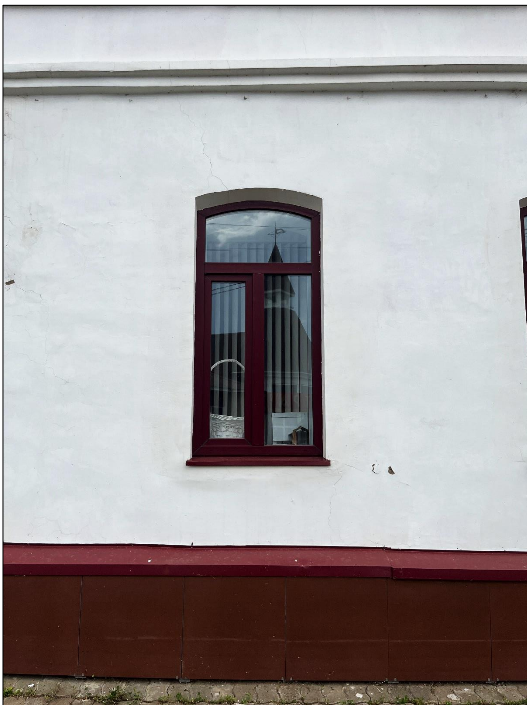
Т.ф. 4. Объект экспертизы. Обрез цоколя, оконный проем первого этажа с лучковой перемычкой, межэтажный карниз.
