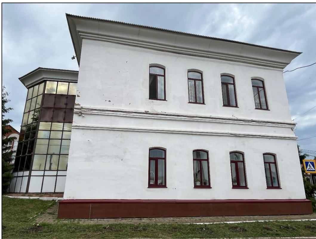
Т.ф. 4. Объект экспертизы. Общий вид со стороны улицы Габдуллы Тукая.
