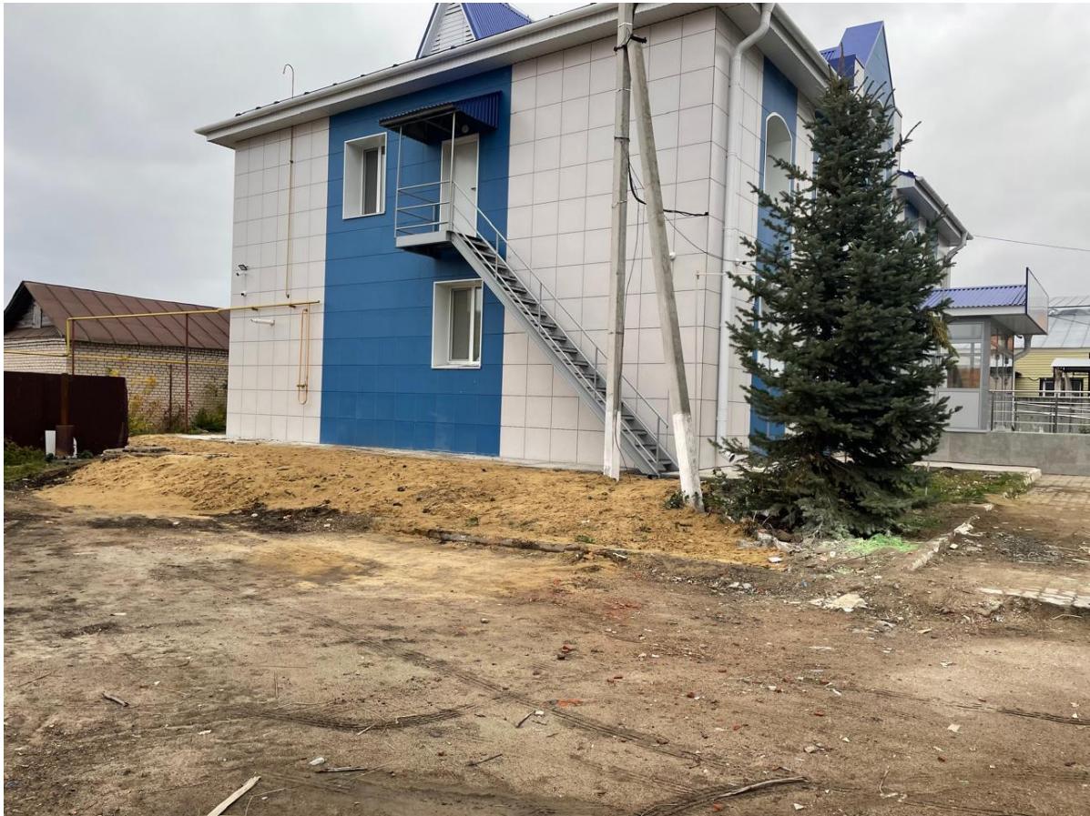
Кадр 1. Фото бокового и главного фасадов. Дата: 12.10.2024
