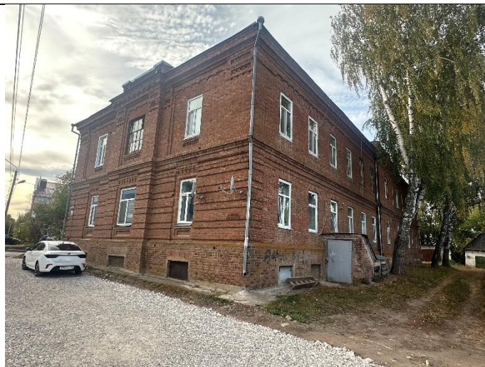
Вид с юго-восточной стороны
