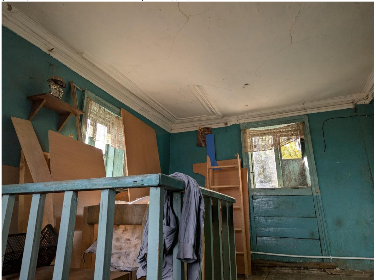
Кадр 12. Дата: 28.09.2024 г. Лестничный пролет подъезда
