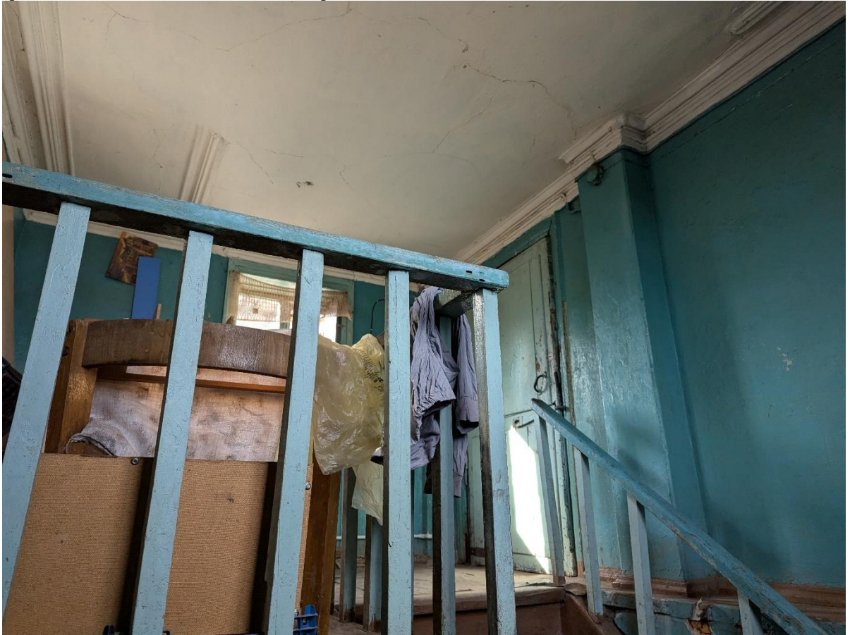
Кадр 11. Дата: 28.09.2024 г. Лестничный пролет подъезда
