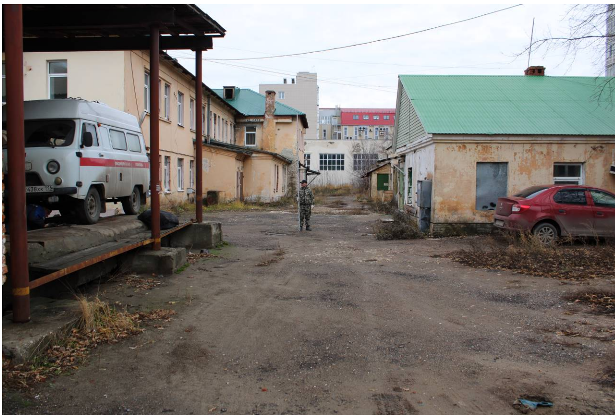
Рис. 11. «Строительство здания ГАУЗ «Республиканский клинический кожно-венерологический диспансер МЗ РТ имени профессора А.Г. Ге». Общий вид центральной части участка обследования. ТФ 6. Вид с юго-востока.
