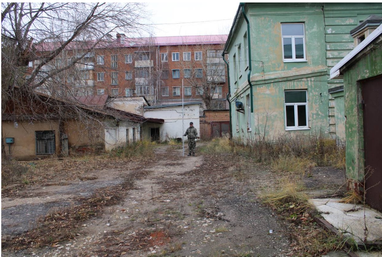
Рис. 15. «Строительство здания ГАУЗ «Республиканский клинический кожно-венерологический диспансер МЗ РТ имени профессора А.Г. Ге». Общий вид юго-западной части участка обследования. ТФ 10. Вид с северо-востока.
