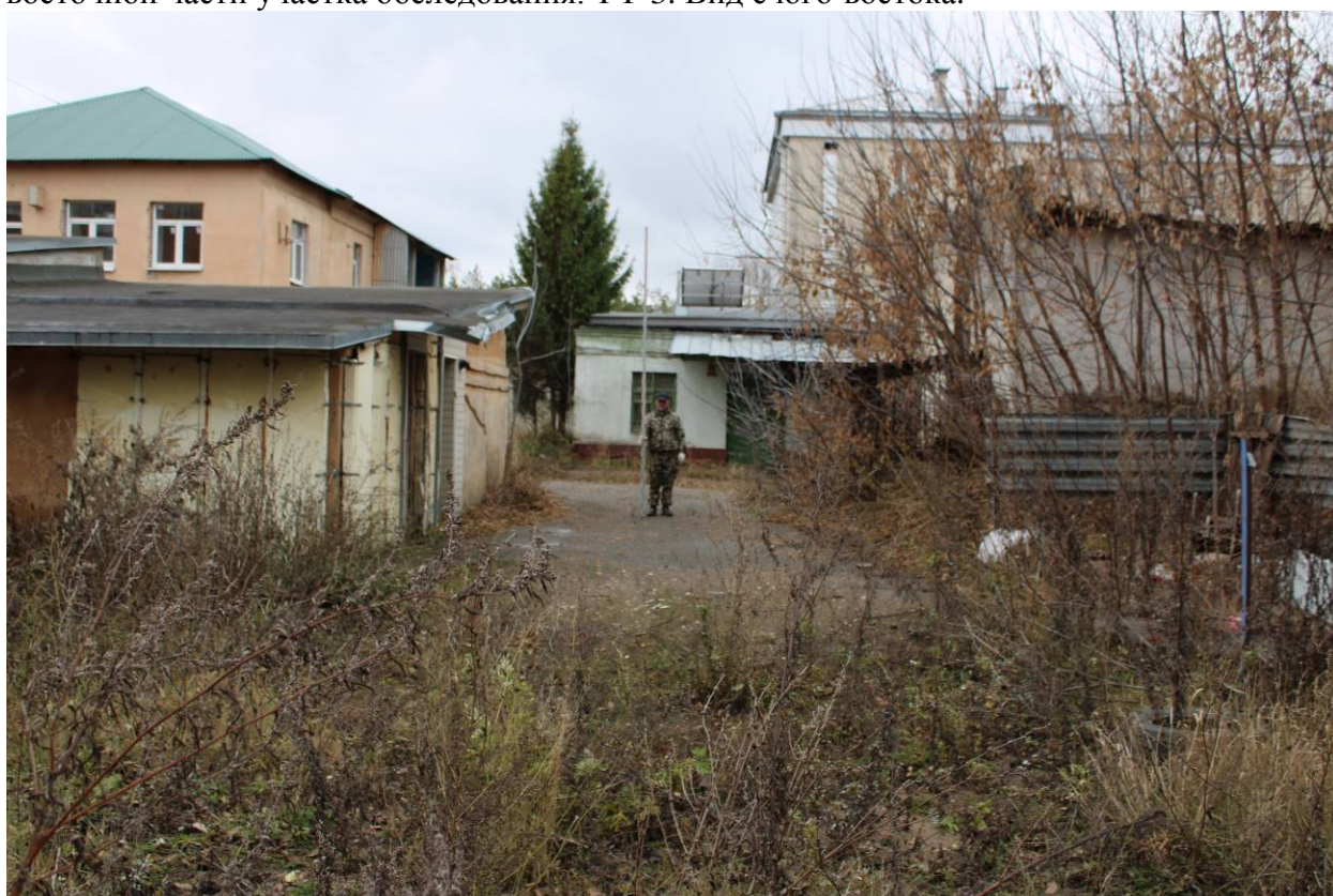
Рис. 8. «Строительство здания ГАУЗ «Республиканский клинический кожно-венерологический диспансер МЗ РТ имени профессора А.Г. Ге». Общий вид северо-западной части участка обследования. ТФ 4. Вид с северо-востока.
