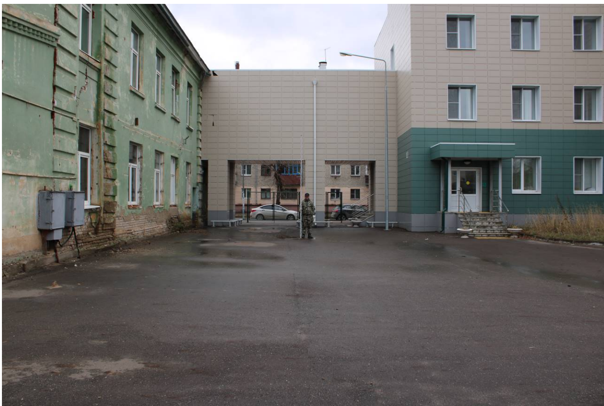
Рис. 17. «Строительство здания ГАУЗ «Республиканский клинический кожно-венерологический диспансер МЗ РТ имени профессора А.Г. Ге». Общий вид южной части участка обследования. ТФ 12. Вид с северо-запада.
