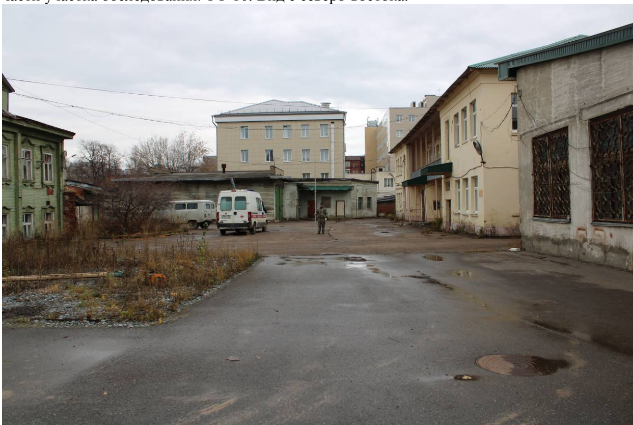
Рис. 16. «Строительство здания ГАУЗ «Республиканский клинический кожно-венерологический диспансер МЗ РТ имени профессора А.Г. Ге». Общий вид западной части участка обследования. ТФ 11. Вид с востока-юго-востока.
