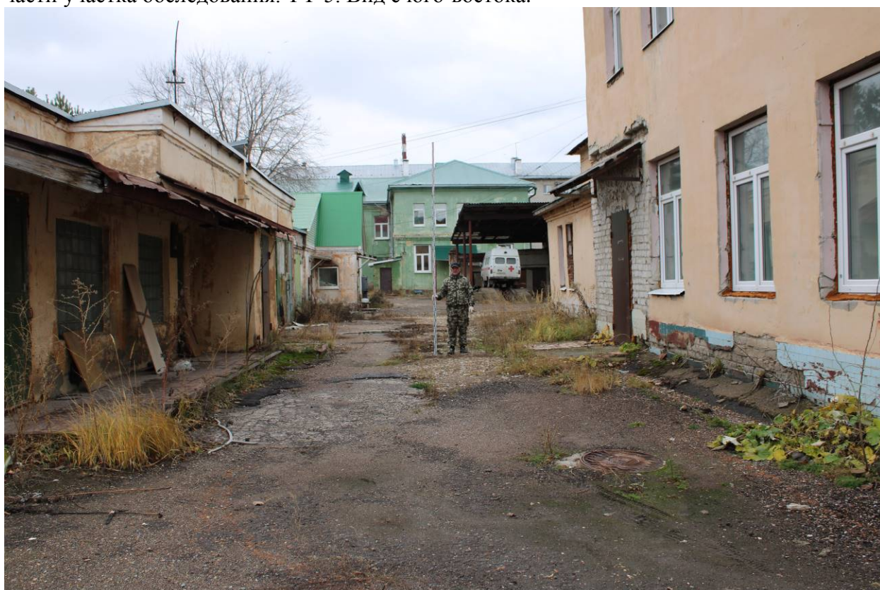
Рис. 10. «Строительство здания ГАУЗ «Республиканский клинический кожно-венерологический диспансер МЗ РТ имени профессора А.Г. Ге». Общий вид центральной части участка обследования. ТФ 5. Вид с северо-запада.
