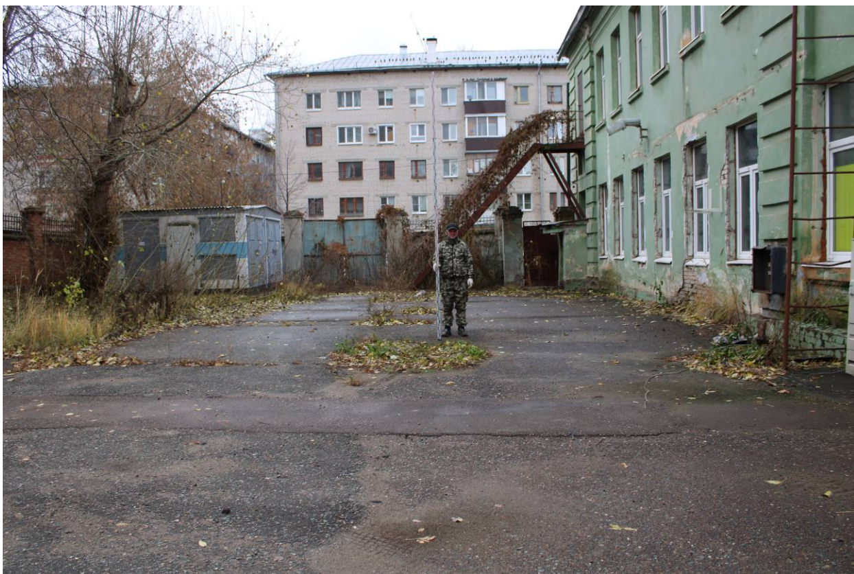
Рис. 13. «Строительство здания ГАУЗ «Республиканский клинический кожно-венерологический диспансер МЗ РТ имени профессора А.Г. Ге». Общий вид юго-западной части участка обследования. ТФ 8. Вид с северо-запада.
