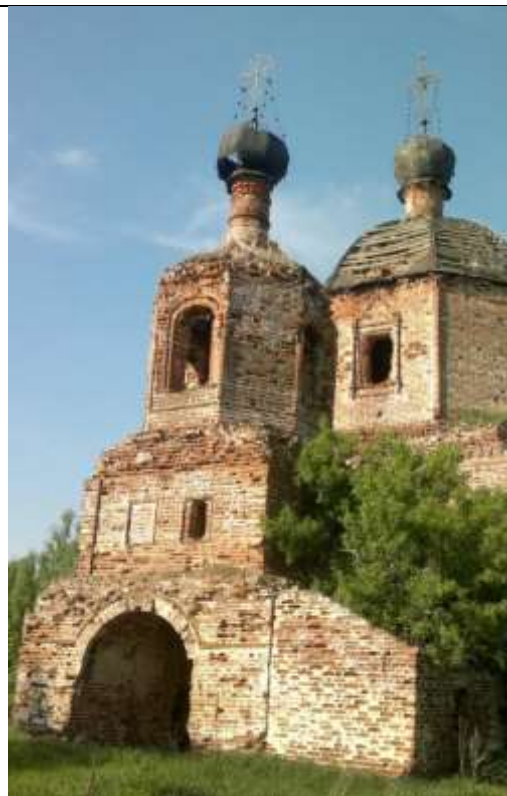
Вид с юга. Колокольня.
