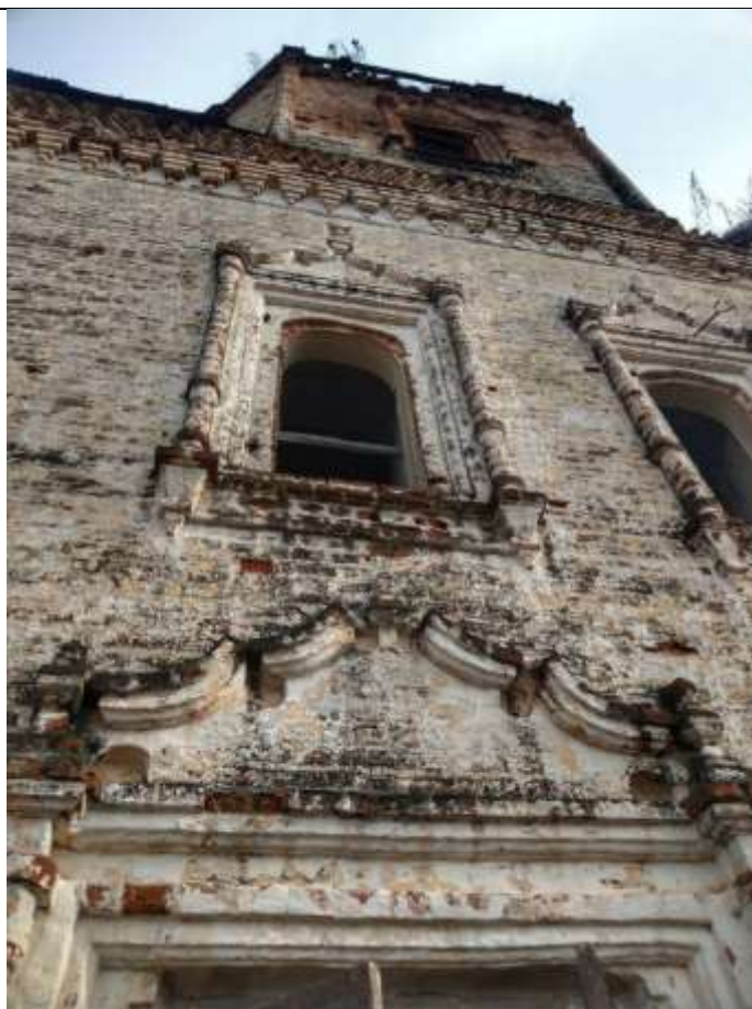
Вид с северо-запада. Фрагмент храмовой части. Окна.
