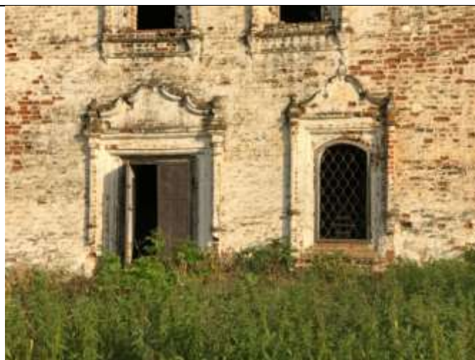
Вид с северо-запада. Дверной проем и окна храмовой части
