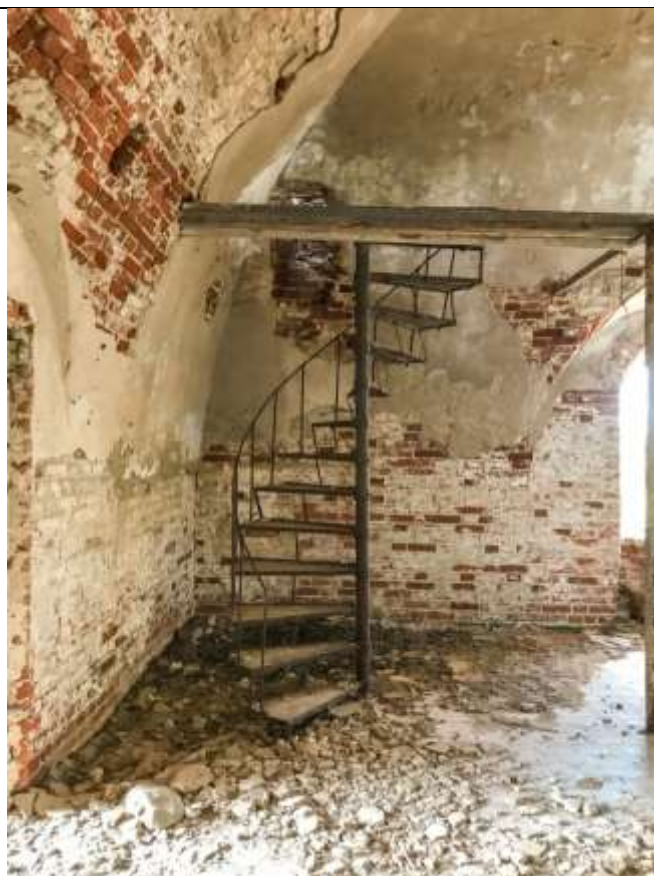
Внутреннее помещение храмовой части. Металлическая кованая лестница.
