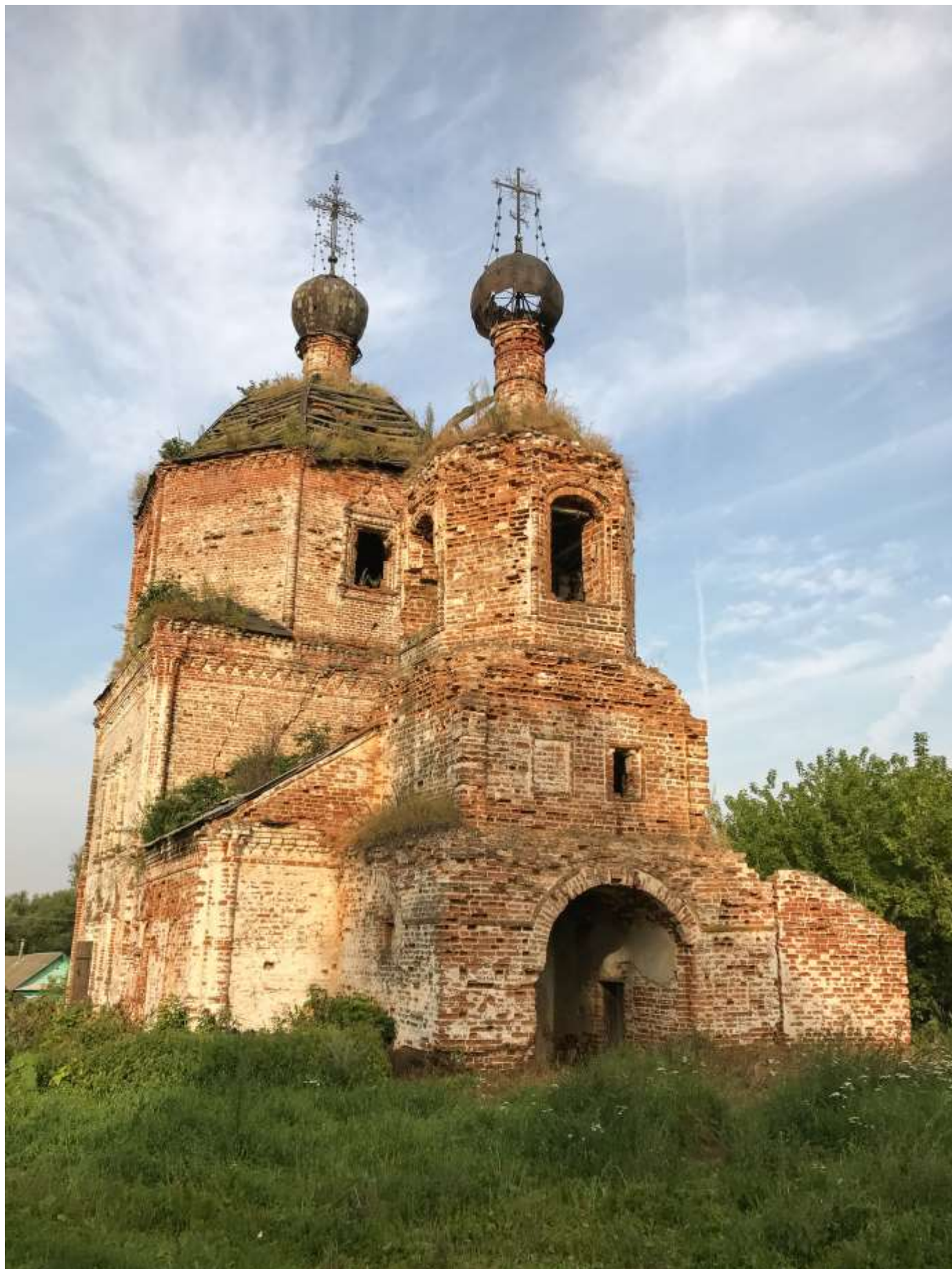
Фото 1. Общий вид запада. Дата съемки 15.09.2024. Архипов П. В.
