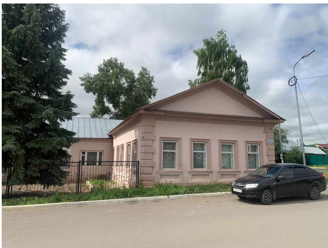
Фото 4. Западный флигель. Вид с севера.
