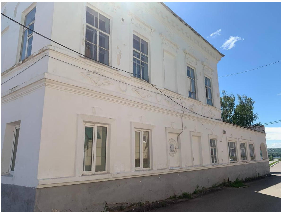
Фото 3. Вид с северо-запада.
