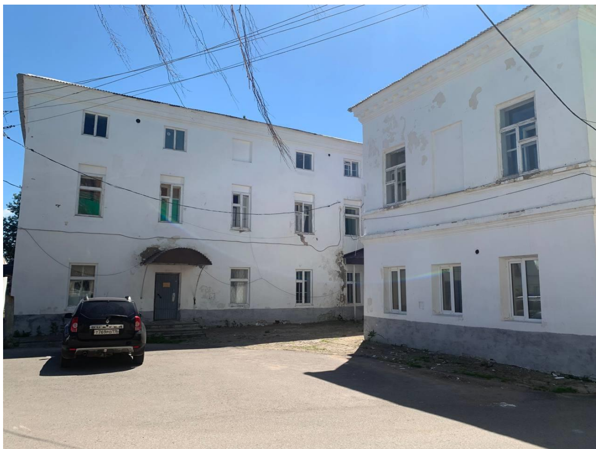
Фото 5. Вид с северо-запада.
