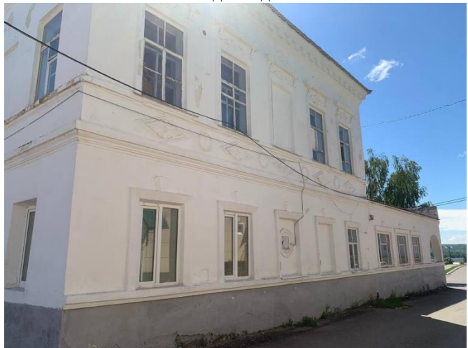
Вид с северо-запада
