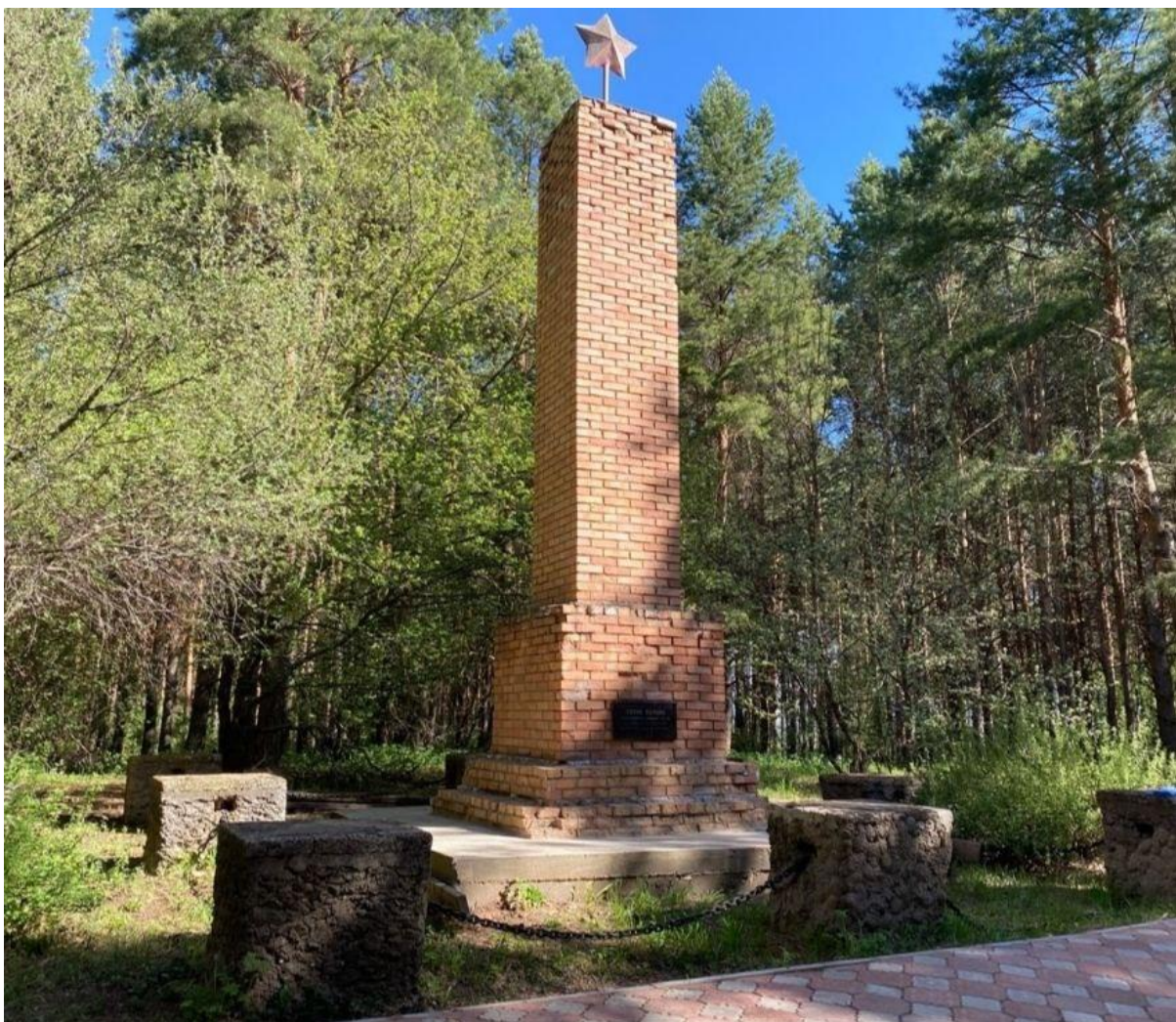
Фото 2. Вид с юго-востока.
